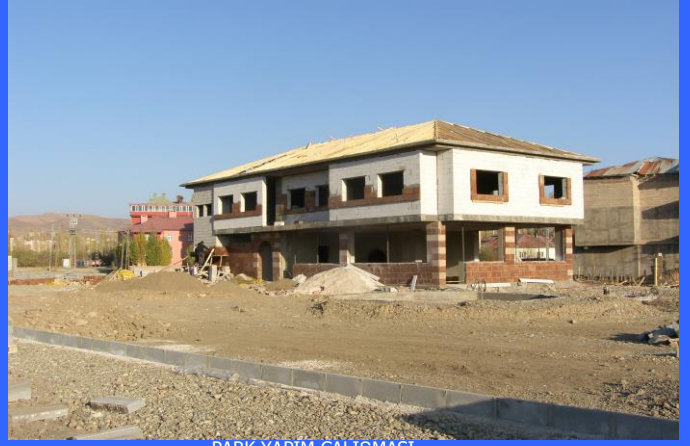
PARK YAPIM ÇALIŞMASI
