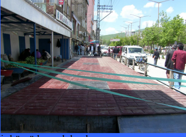
Demir köprü kauçuk kaplama
