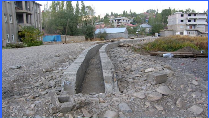
Beton Kanal Yapım işi
