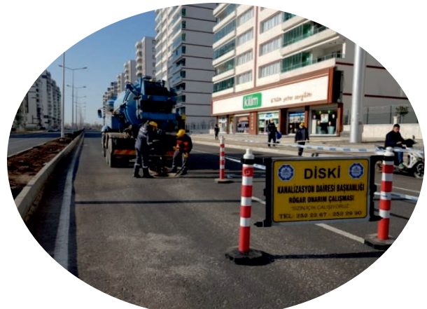
Sipan caddesi Kanalizasyon şebekesi vidaniörlü temizlik çalışması
