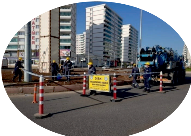
Nazım Hikmet caddesi Kanalizasyon şebekesi vidaniörlü temizlik çalışması
