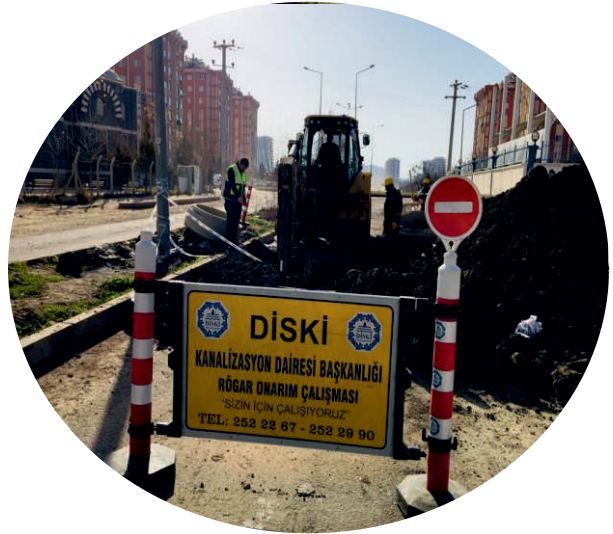
Üç kuyular TOKİ 2. Cadde Kanalizasyon Yağmur suyu şebeke çalışması
