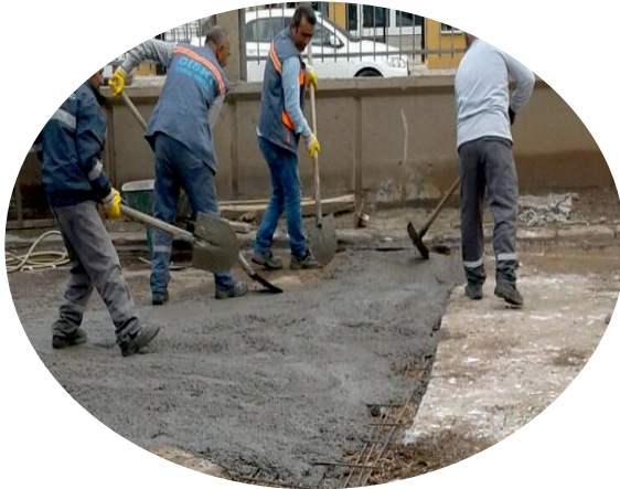
Bağlar bölgesi beton çalışması
