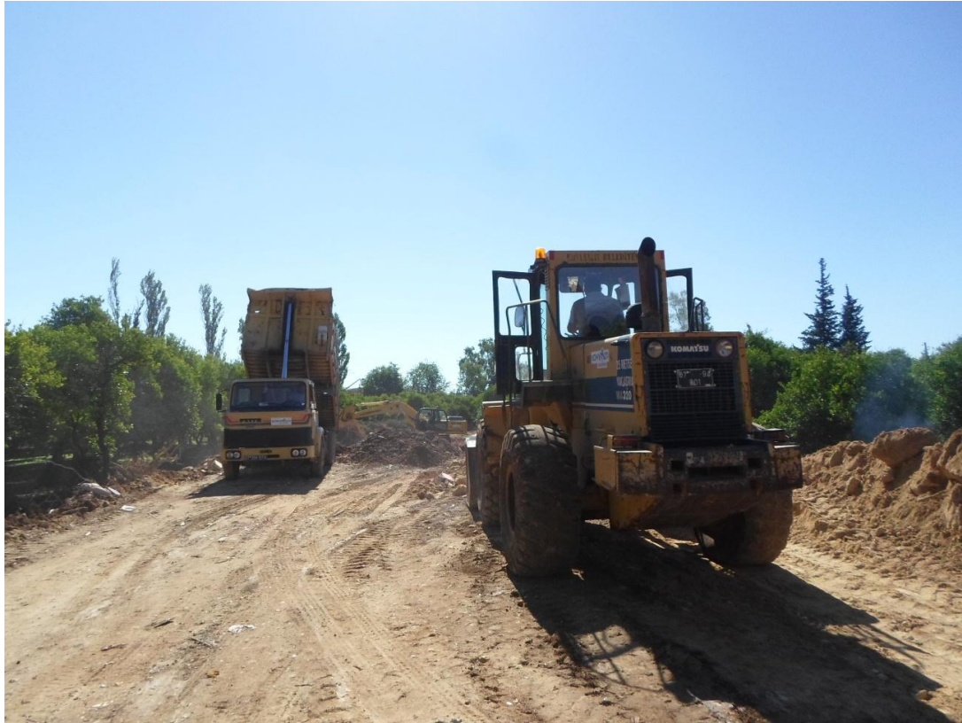
Mollayusuf Mahallesi 1469 Sokak (Karamersin Mevkii) Ham Yol Açma Çalışması
