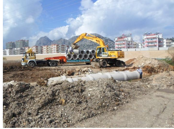
Hurma Mahallesi 206 – 214 Sokak kesişimi tahliye hattı geçişi yapımı
