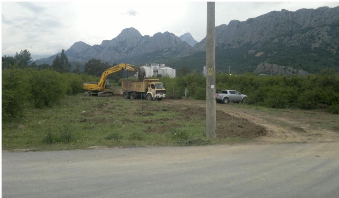
Liman Mahallesi 122 Sokak (38. Cadde) Ham Yol Açma Çalışmaları
