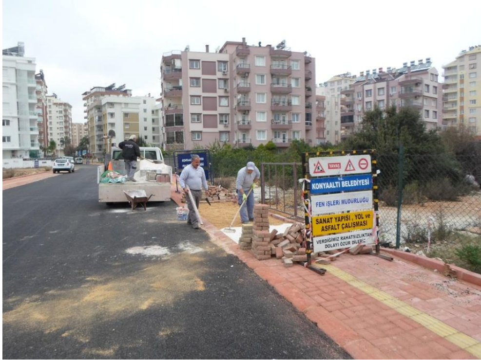
Uncalı Mahallesi 1207 Sokak Tamirat Ekibi çalışması
