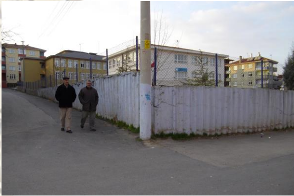
Okul Bahçe Duvarına Tel Çit Yapılması
