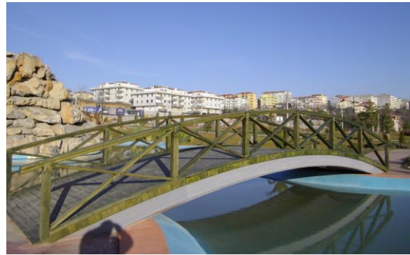
Havuz Üzerine Ahşap Köprü Yapılması
