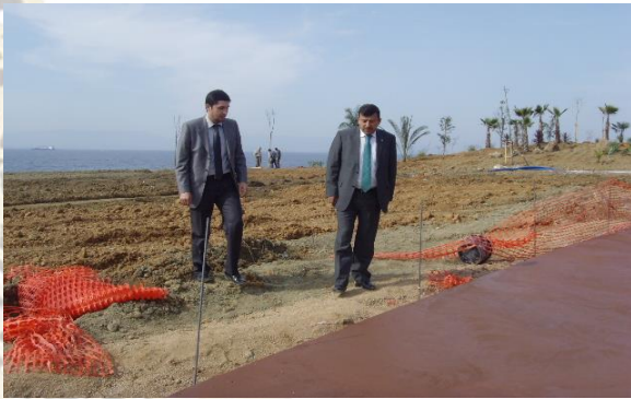
Sahil Yolların Betonlanması
