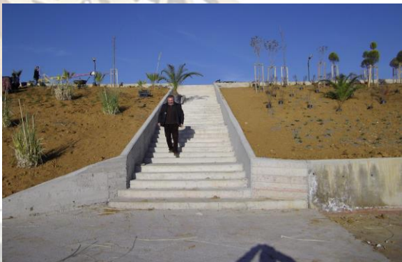
Sahile İniş Merdiveni Yapılması
