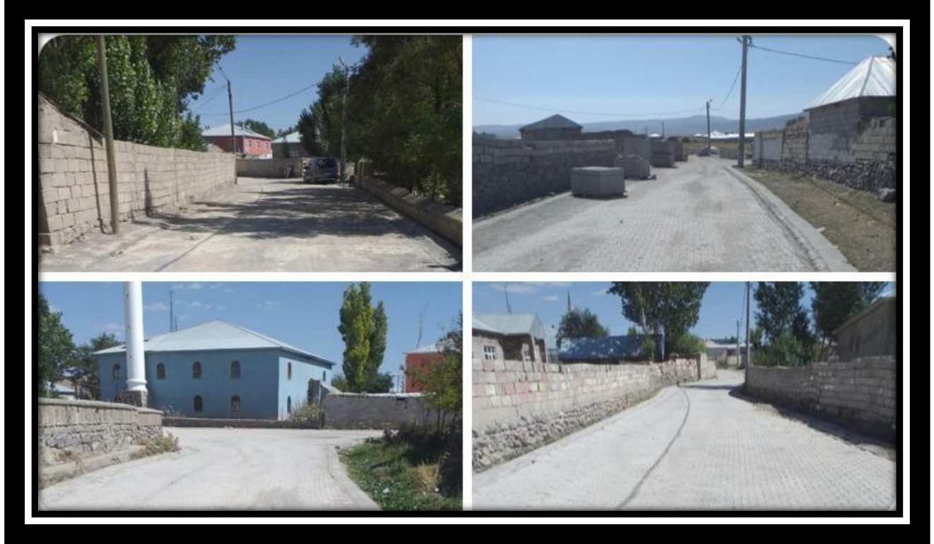
Belediyemizce 2022 yılı yatırım programı kapsamında İlçemize Bağlı Merkez ve Kırsal Mahallelerde yapılan Kilitli Parke Taşı, Bordür Taşı ve Oluklu Taş Döşenmesi
