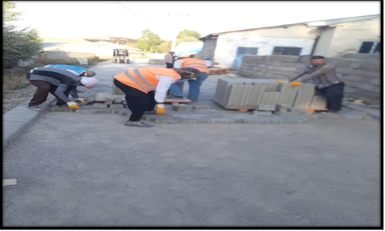
Belediyemizce yapılan 2 adet ihale kapsamında yapılan yol yapım çalışmaları.
