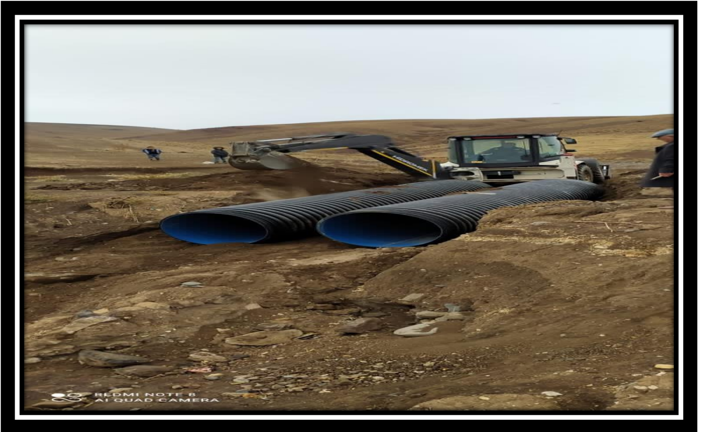
İlçemize bağlı Kırsal Mahallelerde Koruge boru Döşemeleri yapıldı.
