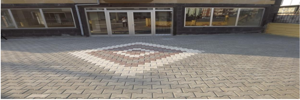
YENİCE MAHALLESİ KORU CAMİİ SERT ZEMİN ÇALIŞMASI
