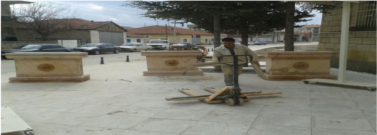
ÇUKURÇAYIR MAHALLESİ ALİ ÇAM CAMİİ MUSALLA TAŞI YAPIMI
