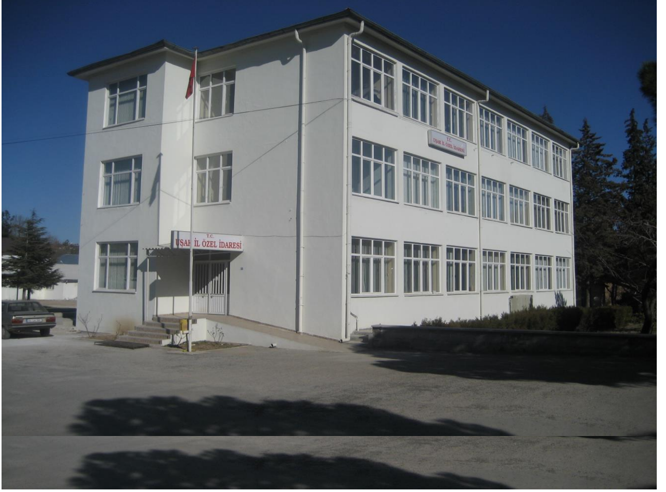
B Blok Hizmet Binası;
