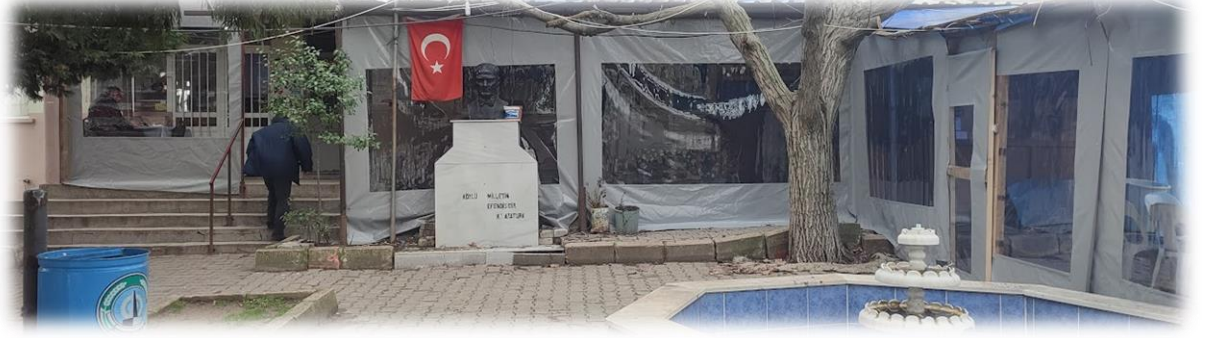
Evrenbey Mahallesi Muhtarlık Binası ve Köy Kahvehanesini Ön Cephe Tadilatı Çalışması
