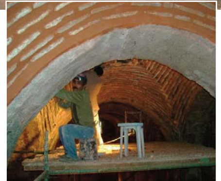
Pantokrator -Zeyrek Sarnıcı Restorasyonu (Fil Damı)
