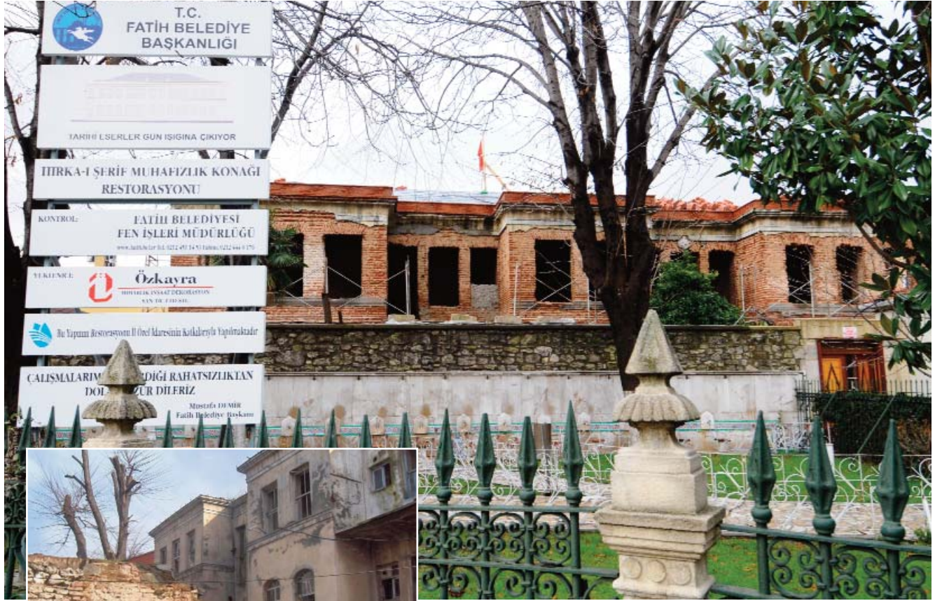
B8- Hırka-ı Şerif Muhafızlık Konağı Restorasyonu
