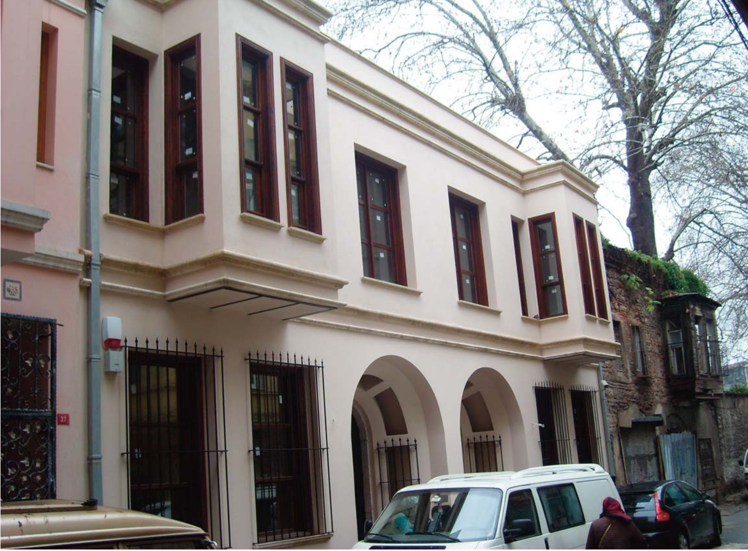
Tevkii Cafer Mah. 2309 ada 17/18 parseldeki kütüphanenin restorasyonu tamamlandı.
