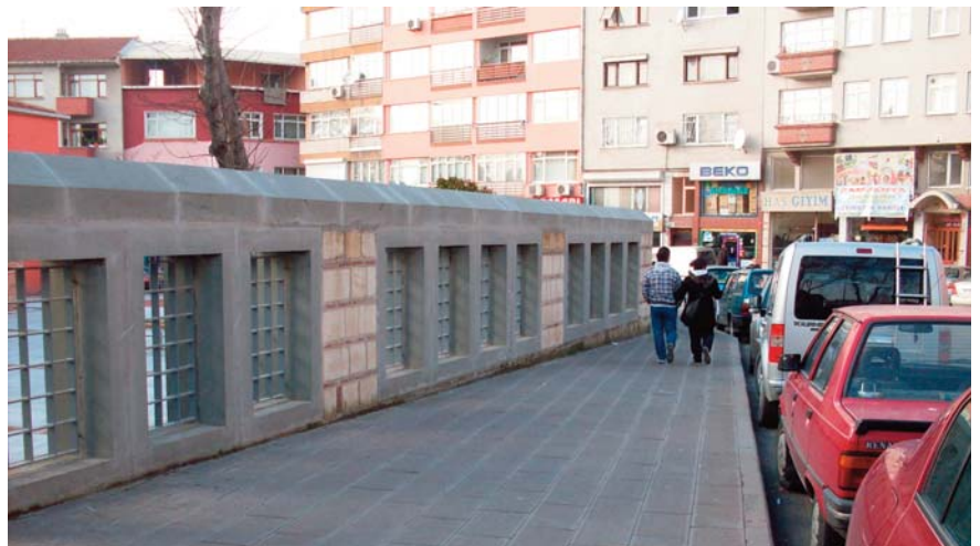
Andezit plak ve bordürle yol yapım çalışması
