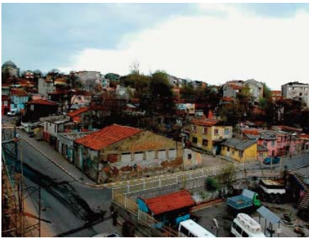
Neslişah ve Hatice Sultan Mahalleleri Yenileme Alanı
