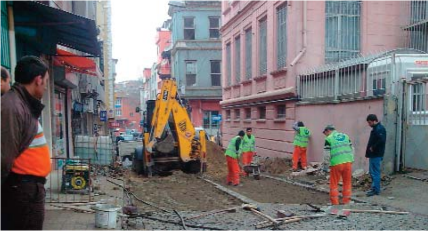
Granit küp taş döşeme çalışması
