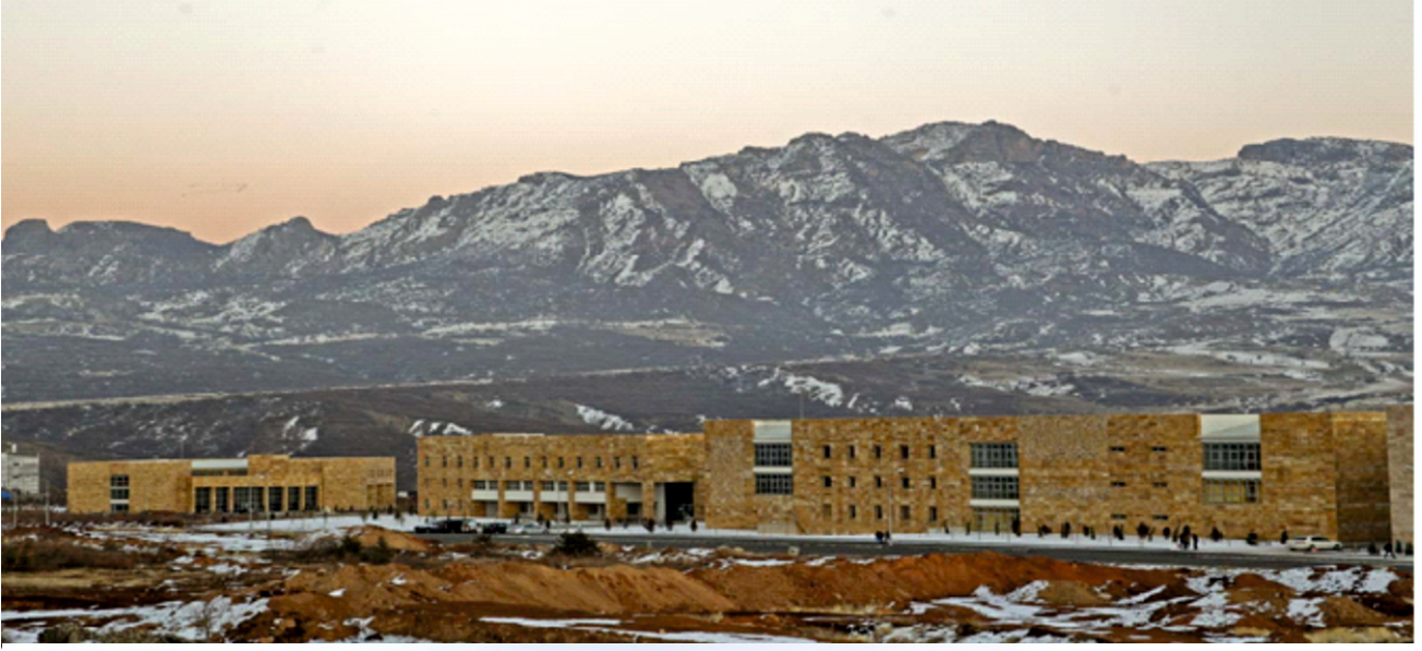
Aktuluk Yerleşkesi İnşaat mekanik elektrik altyapı yapım işi tamamlandı
