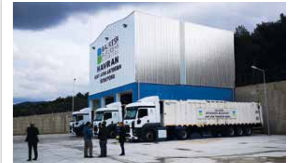
Havran Katı Atık Aktarma İstasyonu
