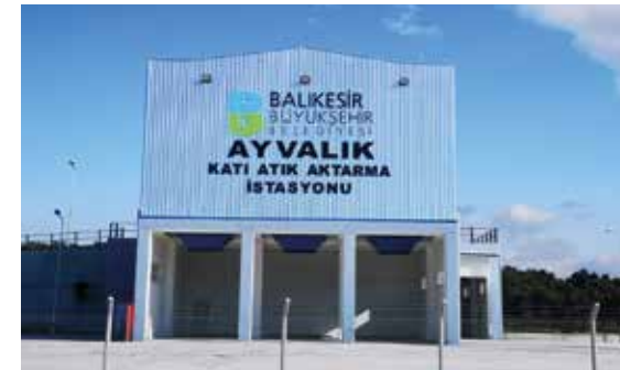
Ayvalık Katı Atık Aktarma İstasyonu
