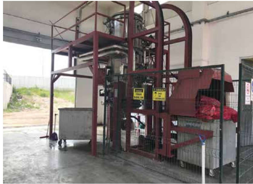
Tıbbi Atık Sterilizasyon Tesisi
