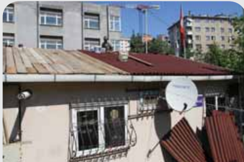
Karlıktepe Mahallesi Muhtarlık Binası Çatı Tamirâtı Yapımı
