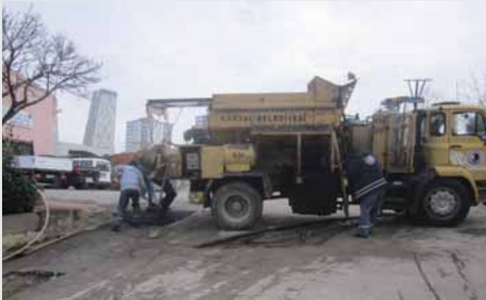
Esentepe Yol Yapım Amirliği Atölye Alanı Asfalt Yama Çalışması
