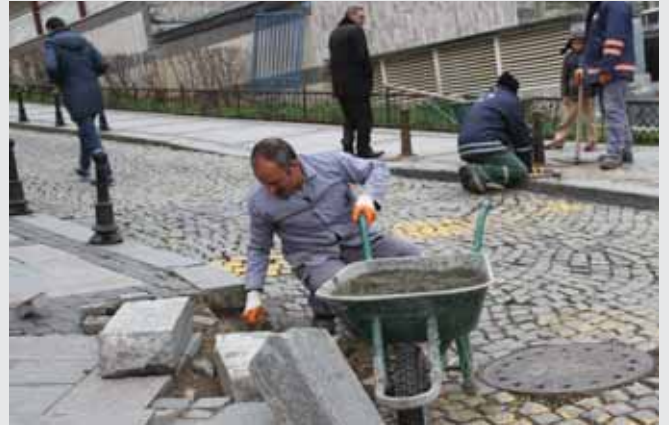
Yakacık Kültür Merkezi Önü Parke Taşı Tamir Çalışması
