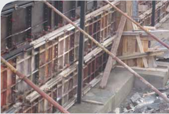
Hürriyet Mahallesi Şehit Ali Şener Sokak İstinat Duvarı Çalışması
