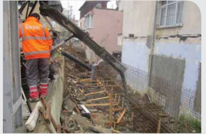
Hürriyet Mahallesi Gizem Sokak İstinat Duvarı Çalışması
