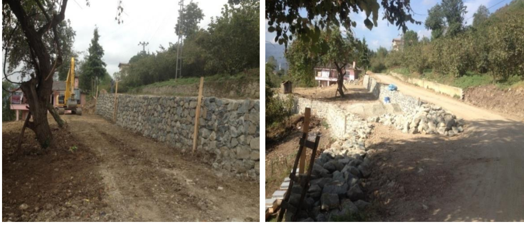
Akkese Mahallesi Moloztaş İksa Duvarı Yapım İşİ
