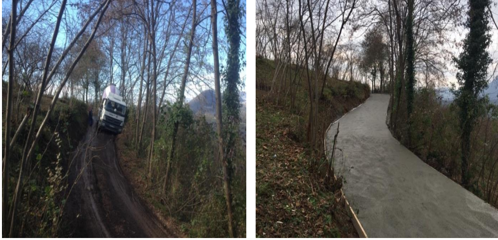
Övündük Mahallesi - Kucunali Sokak Beton Yol Çalışması İlk/Son Hali
