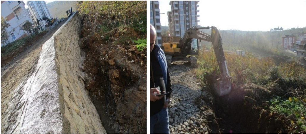
Bucak Mahallesi 437. Sokak Moloztaş Duvar Yapım İşİ İlk/Son Hali
