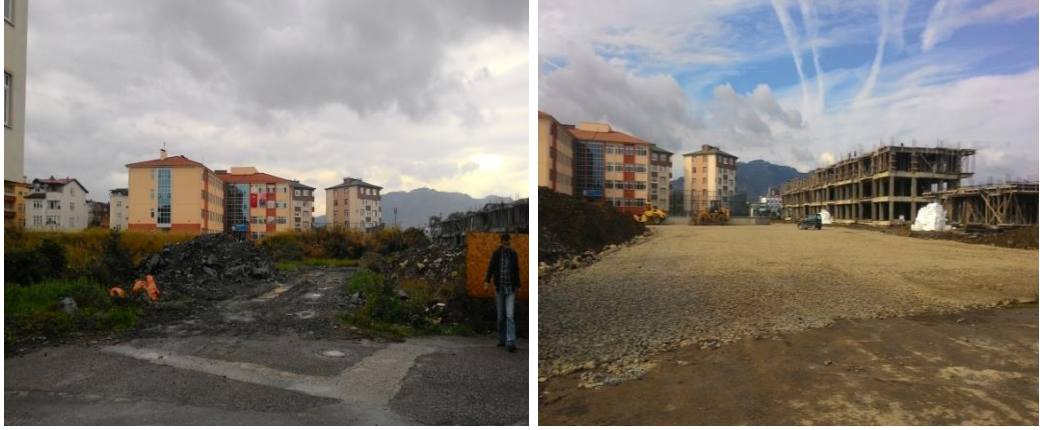
Durugöl Mahallesi 1093. Sokak (Durugöl İlköğretim) İmar Yolu Çalışması İlk/Son Hali
