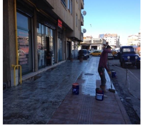
Subaşı Mahallesi 472. Sokak Baskı Beton Çalışmaları İlk/Son Hali
