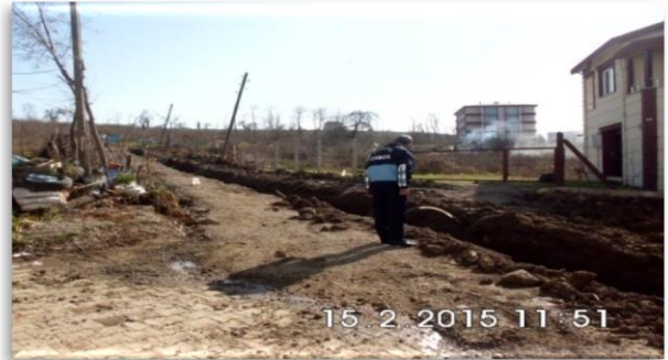
Doğalgaz Çalışmasında Sokağın Trafığa Kapatılması
