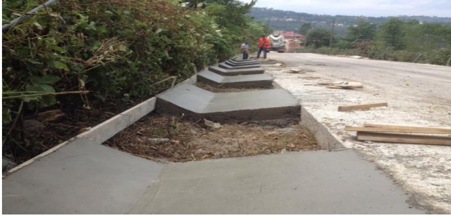
Kayabaşı Mahallesi Dayıslu Sokak Beton Yol- V Kanal Çalışması İlk/Son Hali
