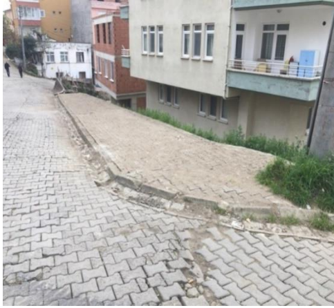
Selimiye Mahallesi 234. Sokak Parke Bakım- Onarım Çalışması İlk/Son Hali
