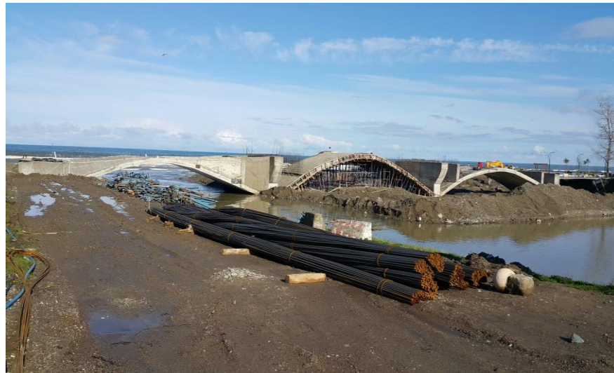
Mostar Köprü Projesi Yapım İşi Son Durum
