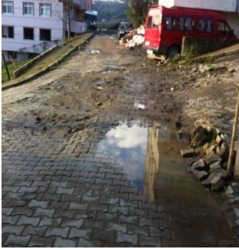
Selimiye Mahallesi 216. Sokak Parke Bakım-Onarım Çalışması İlk/Son Hali
