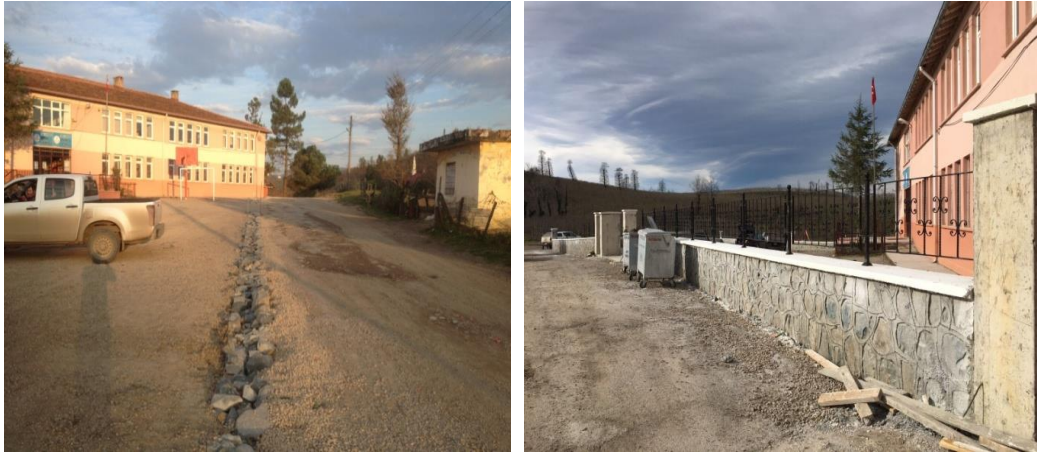
Bayadı Mahallesi İlköğretim Okulu İhata Duvarı Yapım İşİ ( Devam Ediyor. )
