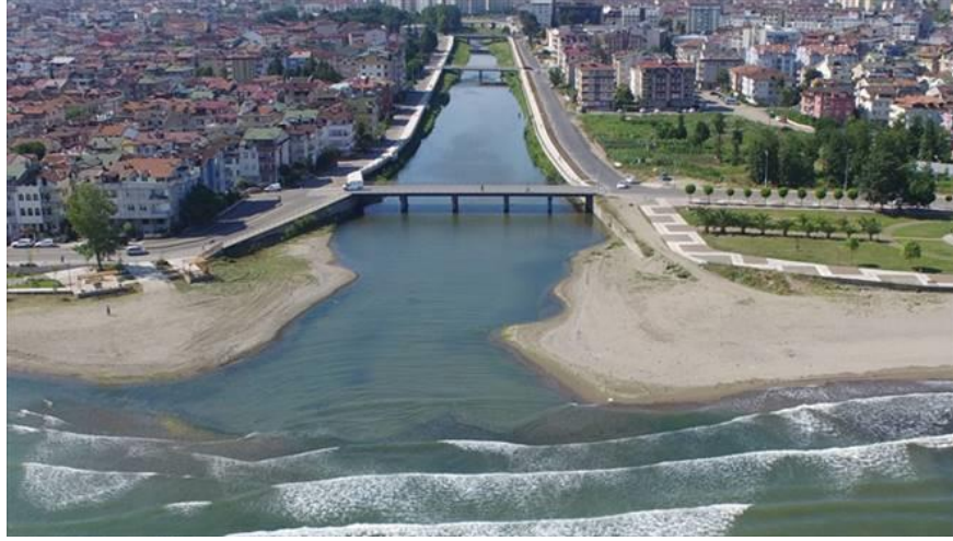
Altınordu Merkez Civil Irmağı Üzeri Mostar Köprüsü Proje Öncesi Hali
