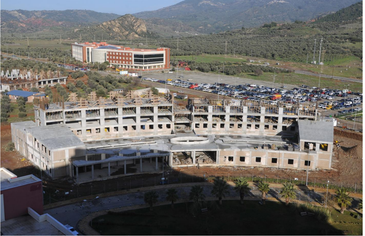
Hastane Ek Bina İnşaatı
