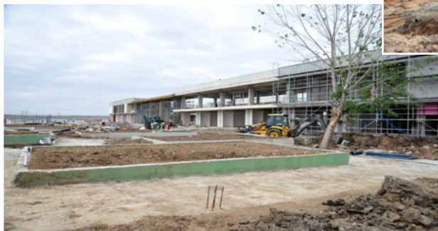
Lüleburgaz Yıldızları Sanat Akademisi İnşaat Alanı
