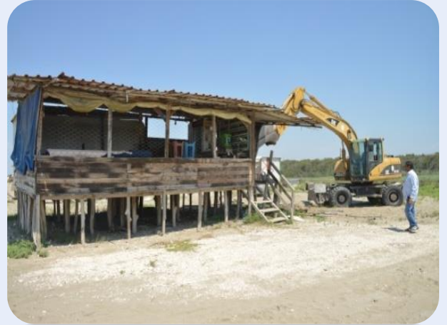
Metruk yapılar yıkıldı.
