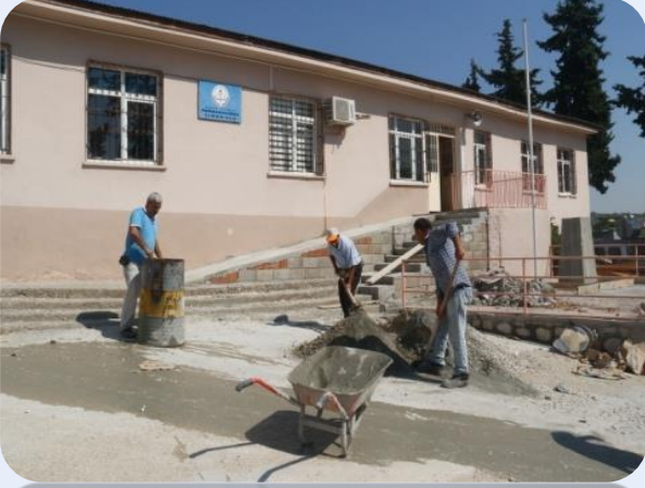
Okulların Bakım ve Onarımı yapıldı.
