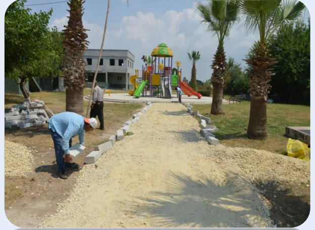
Adanalıoğlu Eylül Parkı yenileme çalışması yapıldı.
