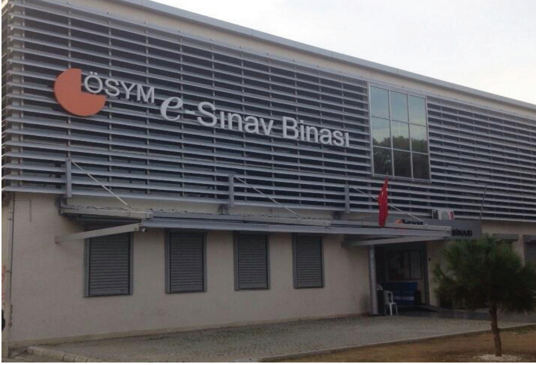
Resim 3- İzmir e-Sınav Binası
