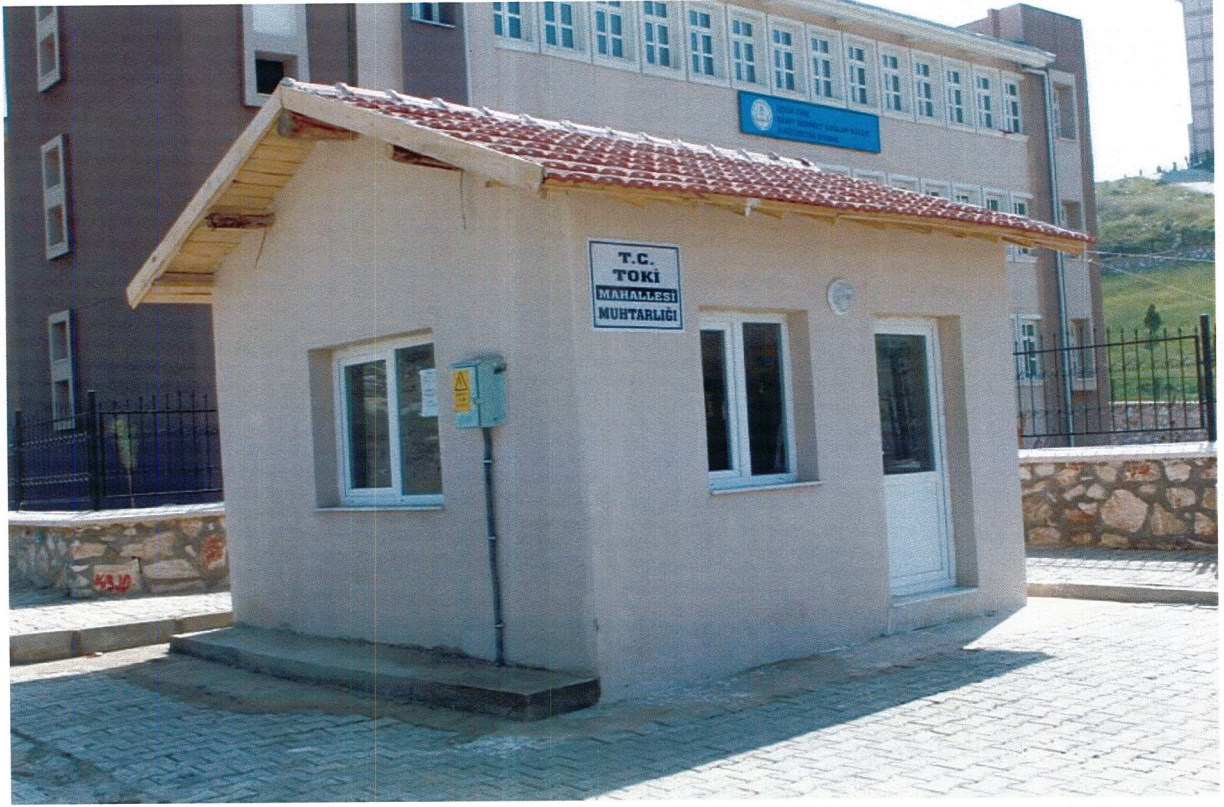
Toki Mahalle Muhtarlık Binası
