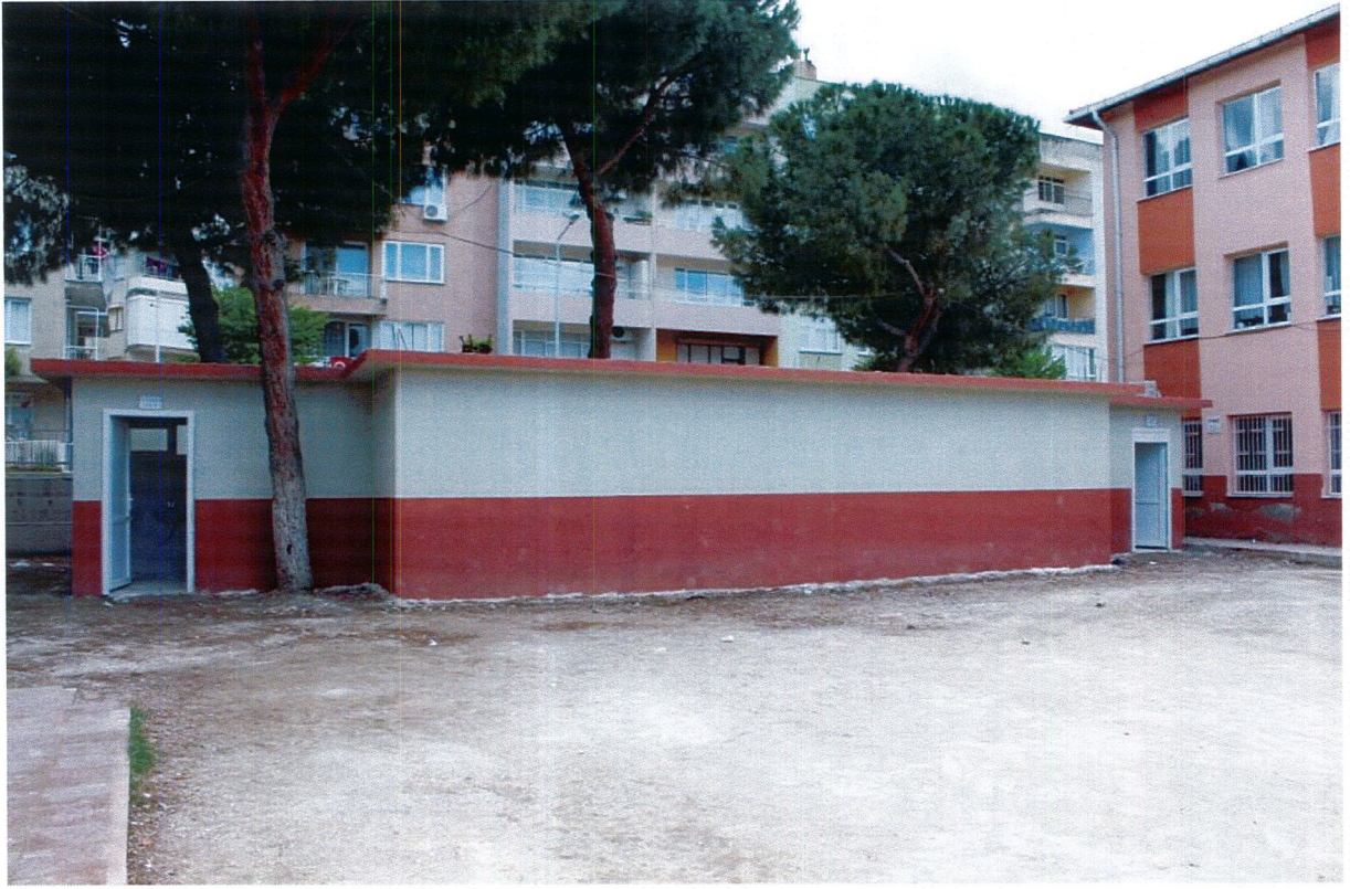
4 Eylül İlköğretim Okulu Tuvalet yapımı
