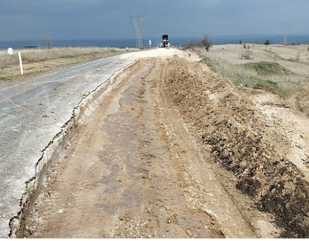
Bölgesel deformasyonların yaşandığı noktalarda zemin iyileştirme çalışmaları rutin şekilde sürdürülmüştür.
