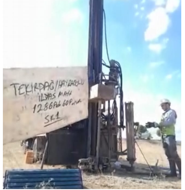
Sondaj Çalışması
