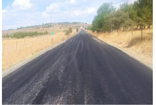
Mahalle bağlantı yollarında deformasyon olan noktalarda 2. kat sathi kaplama çalışması yapılabilmesi için yol platformu üzerinde tarafımızca asfalt serme çalışmaları yapılmıştır.
