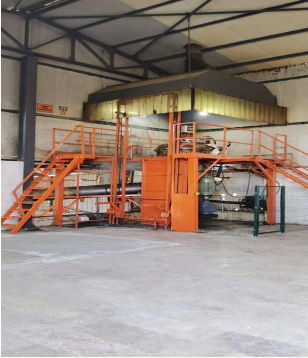
Şekil: Tıbbi Atık Sterilizasyon Tesisi
