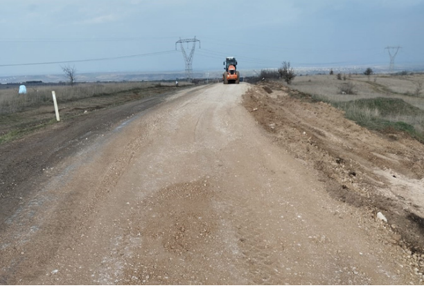
Bölgesel deformasyonların yaşandığı noktalarda zemin iyileştirme çalışmaları rutin şekilde sürdürülmüştür.
