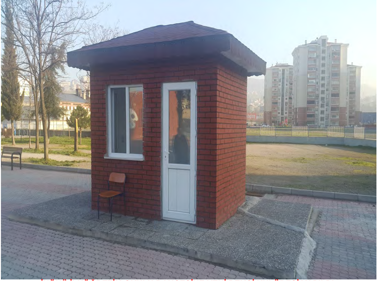
İNÖNÜ İLKÖĞRETİM OKULU BAHÇESİNE YENİ BEKÇİ KULÜBESİ YAPILDI.
