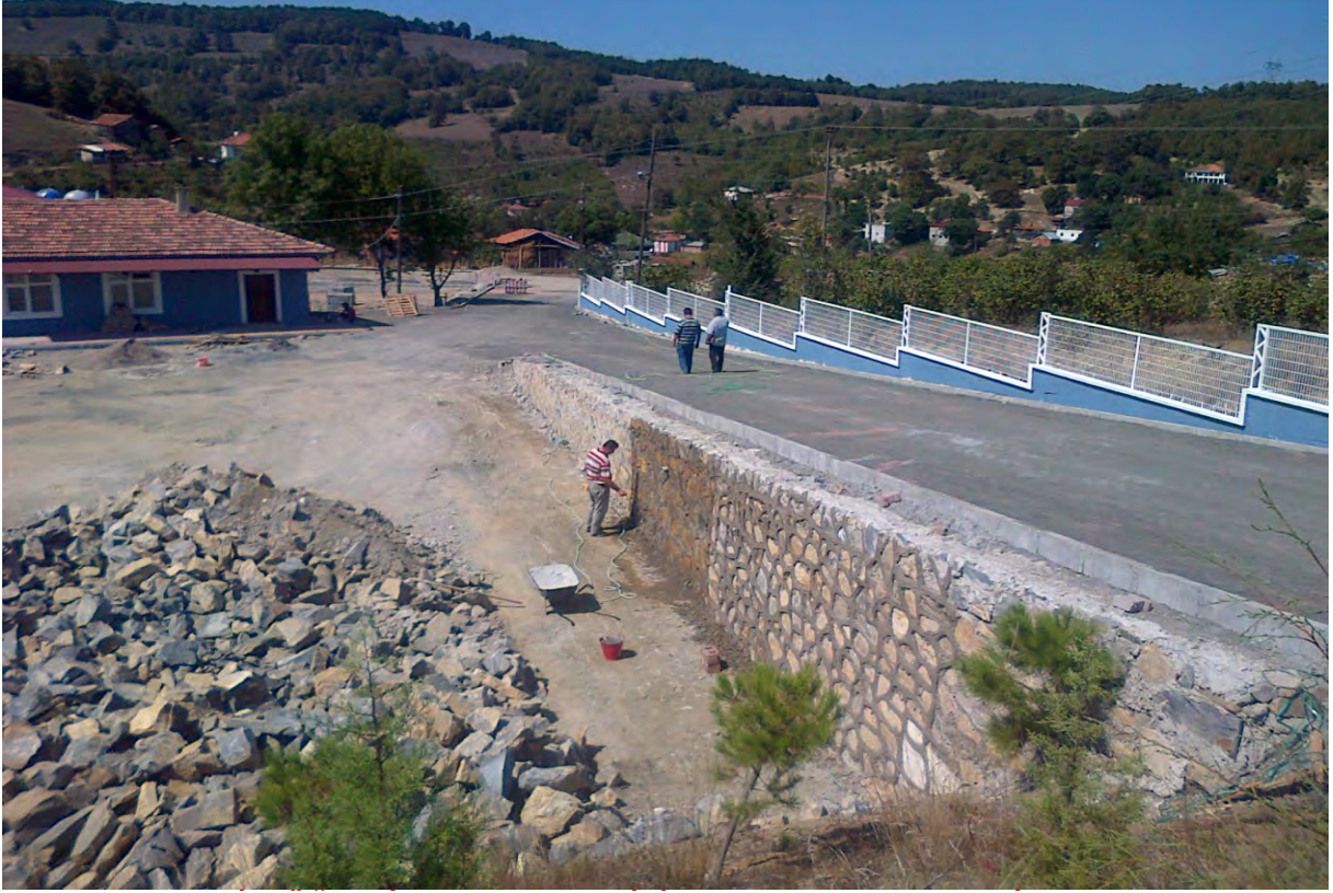
TUZAKLI İLKÖĞRETİM OKULU YOLU İÇİN 273 m 3 TAŞ DUVAR İMALATI YAPILDI.
