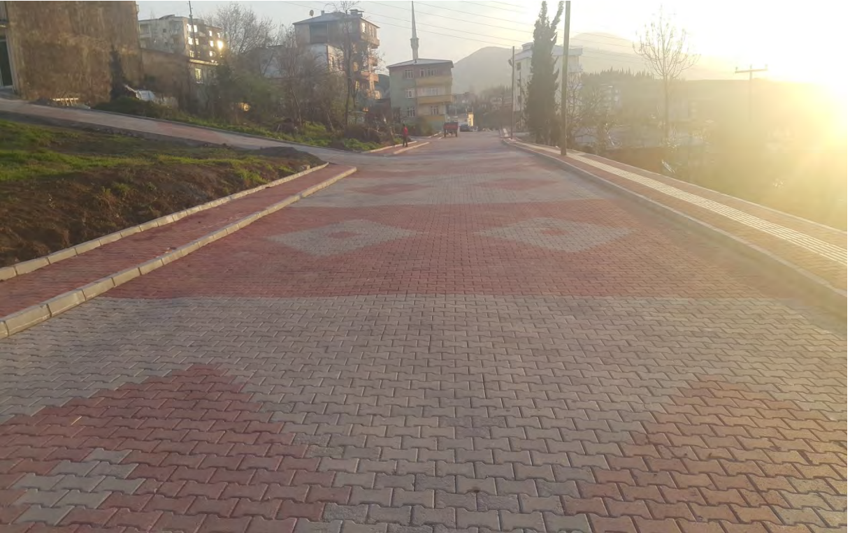
KARŞIYAKA MAHALLESİ AKINCILAR SOKAK PARKE ÇALIŞMASI YAPILDI.(YENİ)
