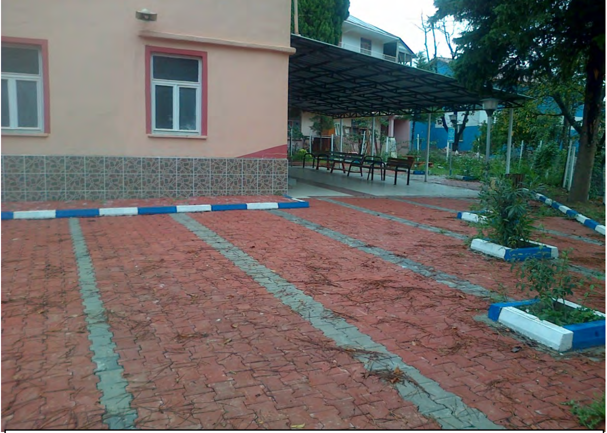
GÖLALAN MAHALLESİ MERKEZ CAMİ AVLUSUNA 1.730 m 2 DESENLI PARKE KAPLAMA 258 m BORDÜR YAPILDI.
