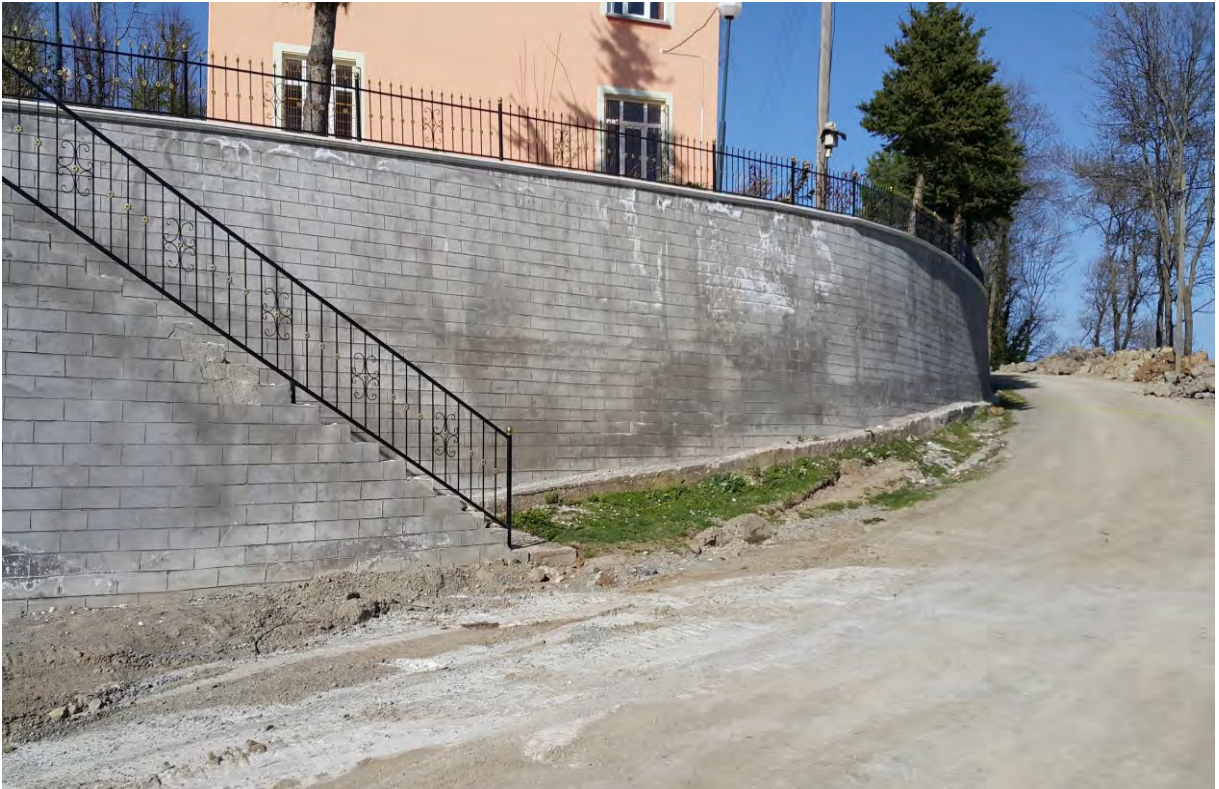
KAŞAYLA MAHALLESİ MERKEZ CAMİ ÇEVRE DUVARLARI DEKORATİF SIVA YAPILDI.
