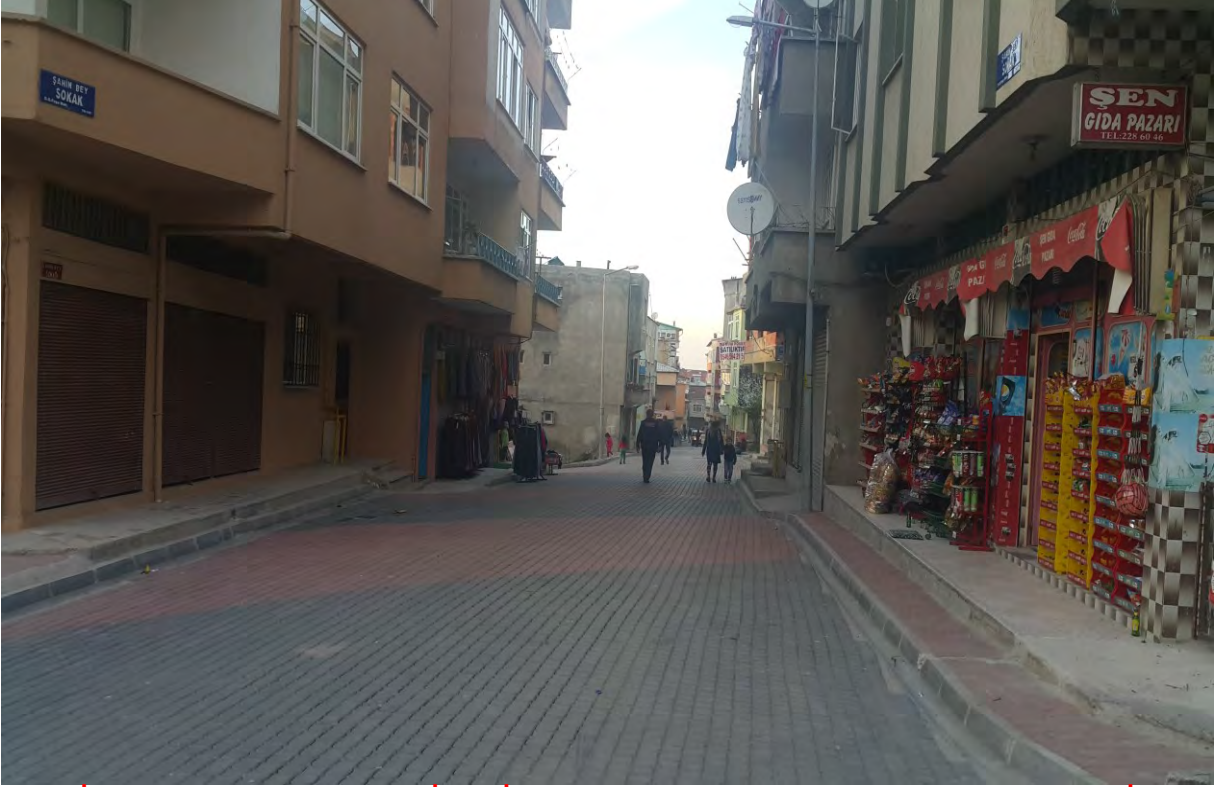
GAZİ OSMAN PAŞA MAHALLESİ ŞAHİNBİY SOKAK PARKE ÇALIŞMASI YAPILDI.(ESKİ)
