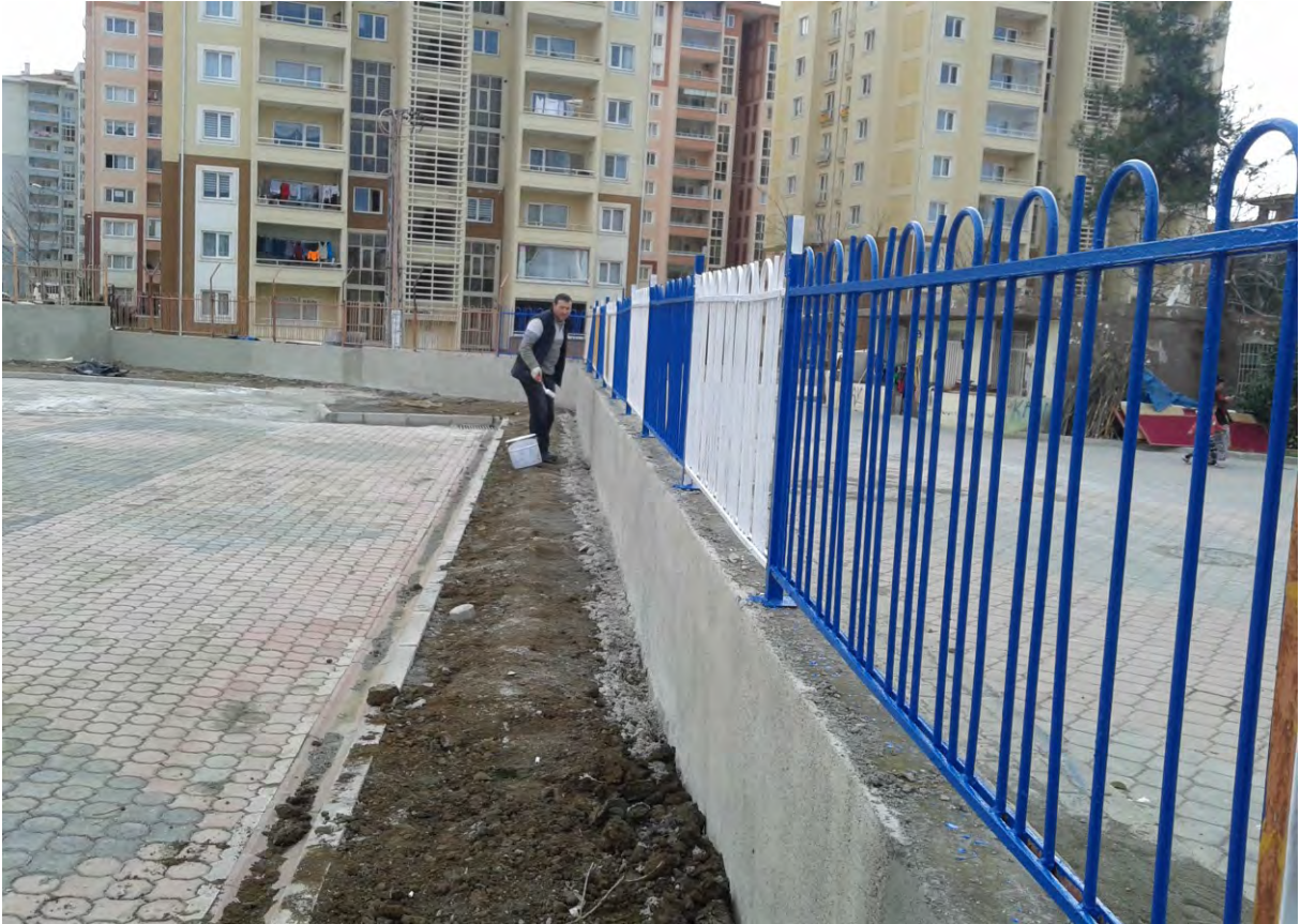
İNÖNÜ İLKÖĞRETİM OKULU ÇEVRE DUVAR KORKULUKLARININ BOYASI YAPILDI.
