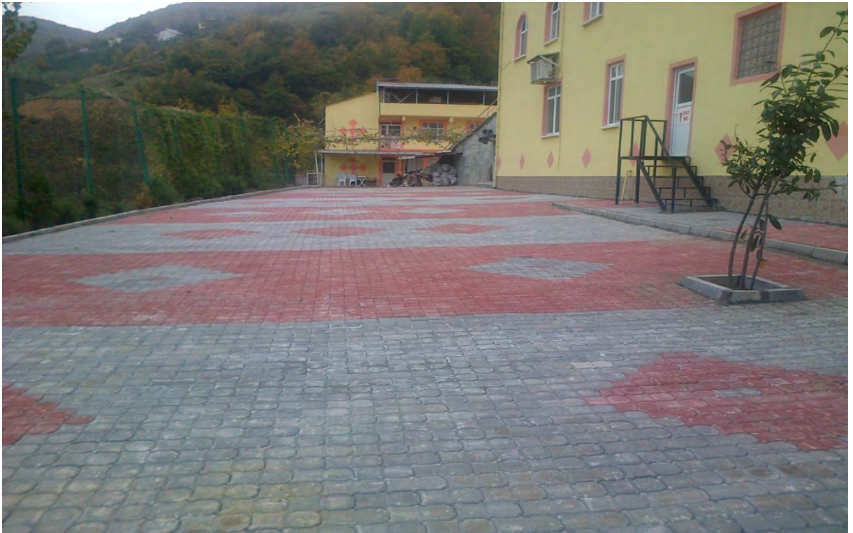
YENİ KÖY MAHALLESİ MERKEZ CAMİİ AVLUSUNA 1.420 m 2 DESENLİ PARKE KAPLAMA 248 m BORDÜR 120 m KORKULUK YAPILDI.
