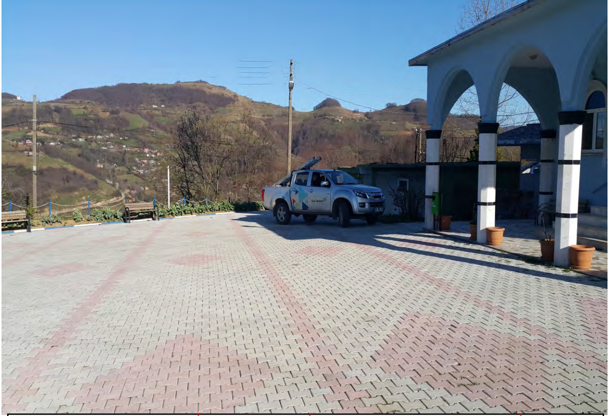
ADATEPE MAHALLESİ MERKEZ CAMİ AVLUSUNA 1742 m 2 DESENLİ PARKE KAPLAMA 211 m BORDÜR YAPILDI.
