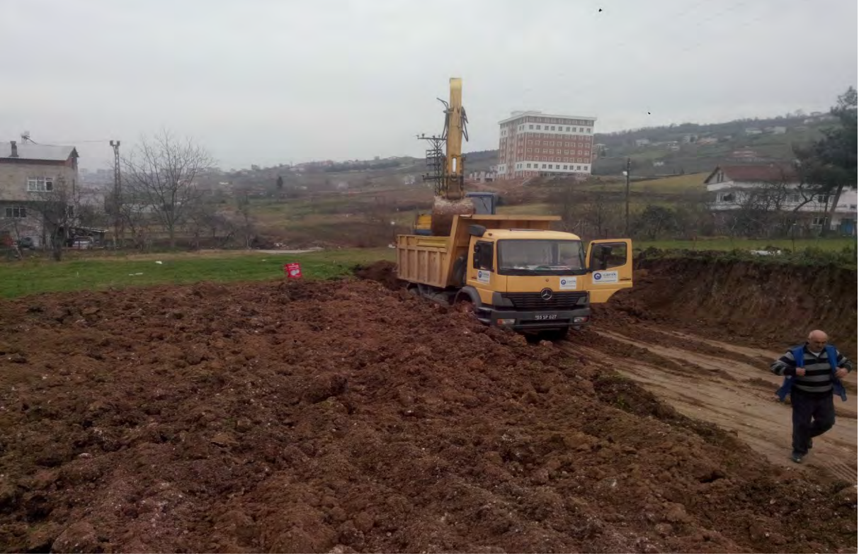
ATATÜRK MAHALLESİ YOL AÇMA ÇALIŞMALARI YAPILDI.
