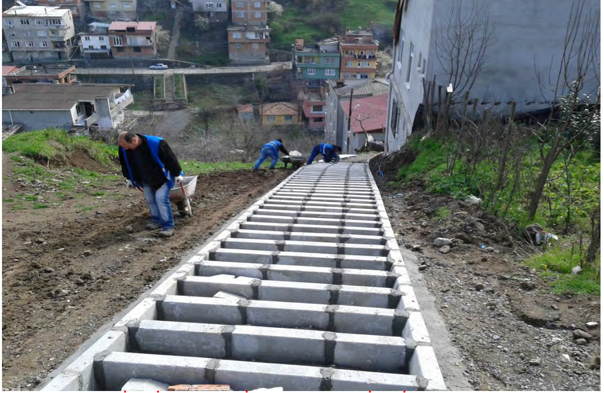
HACI İSMAİL MAHALLESİ 279 SOKAK MERDİVEN İMALATI YAPILDI.
