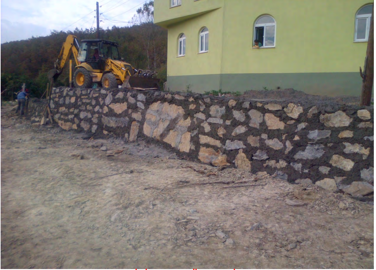
TUZAKLI MAHALLESİ SİVASLI CAMİİ ÇEVRESİ TAŞ DUVAR YAPILDI.
