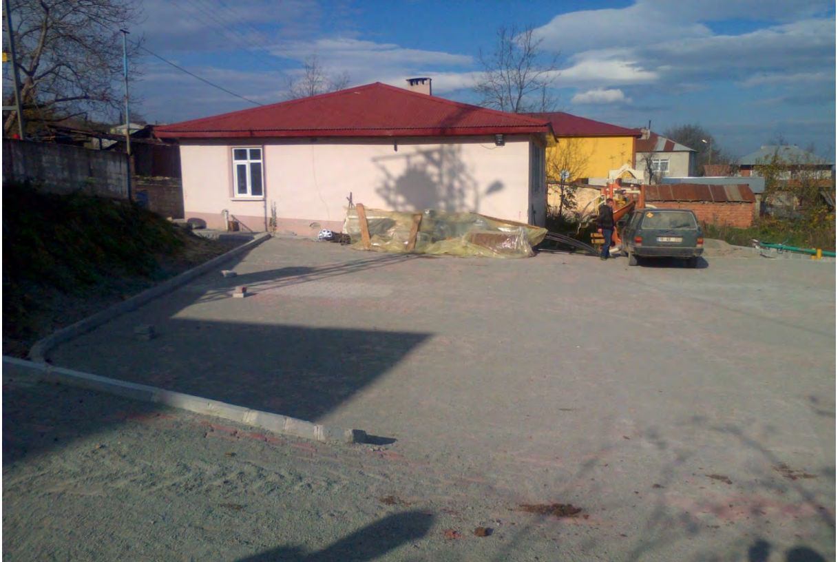
KIZIL OĞLAK MAHALLESİ KÖY KONAĞI AVLUSUNA DESENLİ PARKE KAPLAMA YAPILDI.
