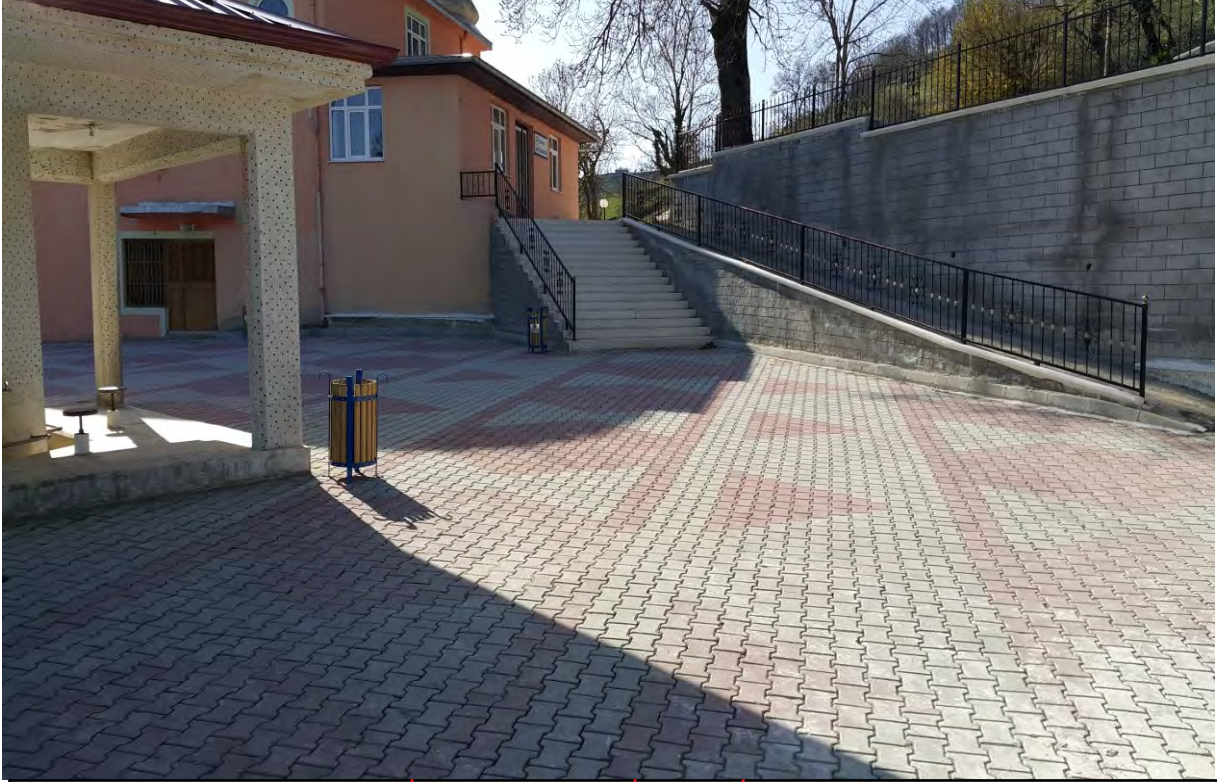
KAŞYAYLA MAHALLESİ MERKEZ CAMİ MERDİVEN VE DUVARLARA 100 m FERFORJE KORKULUK YAPILDI.
