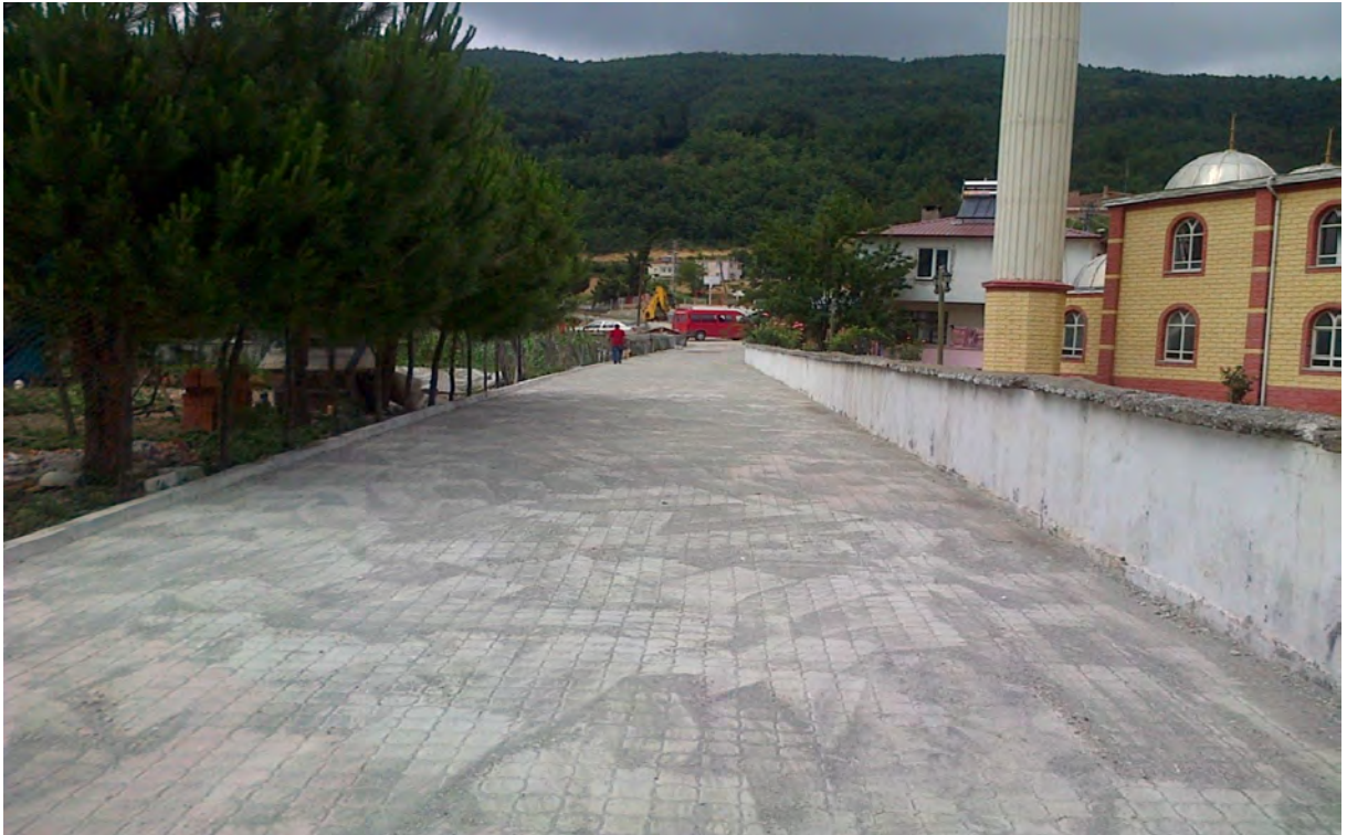
BAŞKONAK MAHALLESİ MEZARLIK VE CAMİ YOLU YOLUNDA 3.260 m 2 PARKE 572 m BORDÜR YOL YAPILDI.
