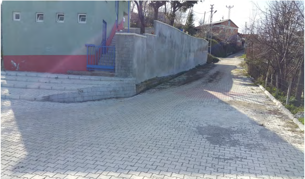
SARIBIYIK MAHALLESİ MERKEZ CAMİ YOLUNDA 1.742 m 2 PARKE 211 m BORDÜR YOL YAPILDI.
