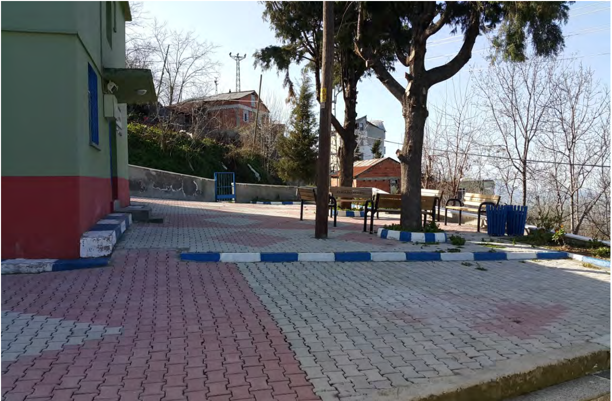
SARIBIYIK MAHALLESİ MERKEZ CAMİ AVLUSUNA BANK VE ÇÖP KOVASI MONTAJI YAPILDI.
