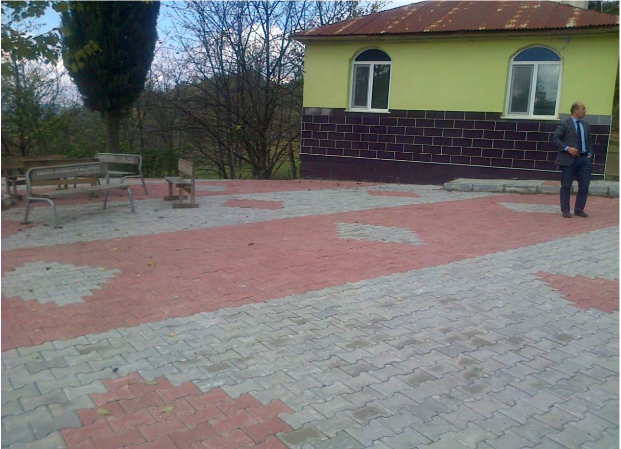
TEKKİRAZ MAHALLESİ KOCA ALAN CAMİİ AVLUSUNA 1.630 m 2 DESENLİ PARKE KAPLAMA 268 m BORDÜR YAPILDI.
