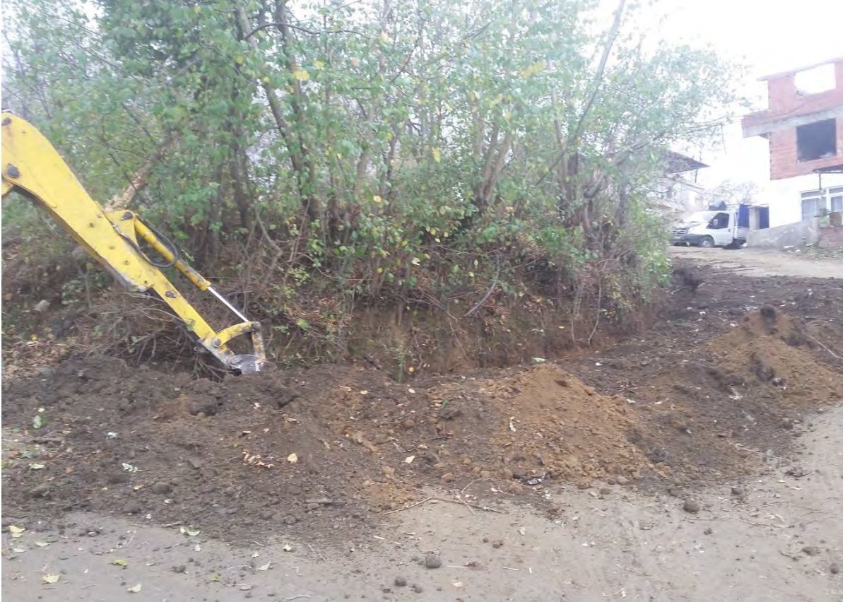
DERELER MAHALLESİ YOL GENİŞLETME ÇALIŞMALARI YAPILDI.
