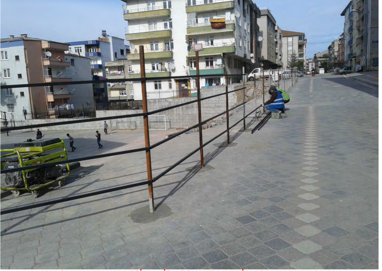
KARŞIYAKA MAHALLESİ MANİSA SOKAKTA DEMİR KORKULUK YAPILDI.
