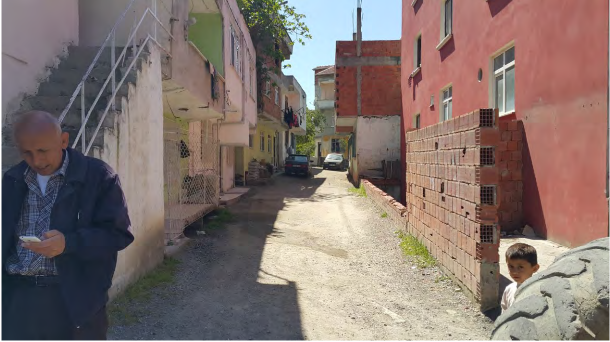
DÜVECİK MAHALLESİ ARA YOLLARDA PARKE ÇALIŞMASI YAPILDI. (ESKİ)
