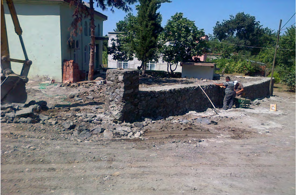
KOZLU MAHALLESİ CAMİİ ETRAFINA 1180.37 M3 TAŞ DUVAR YAPILDI.
