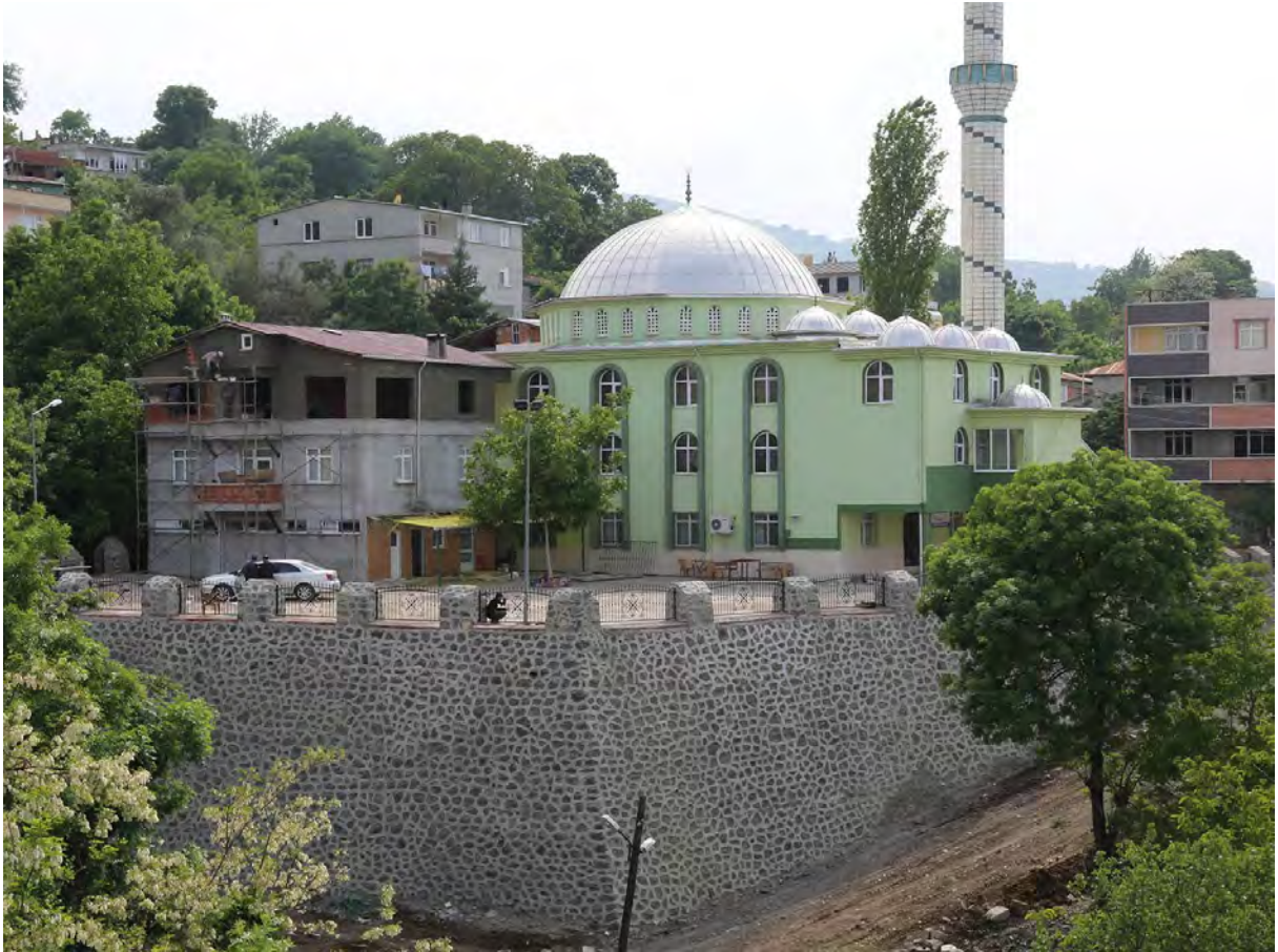
DERELER MAHALLESİ MERKEZ CAMİİ ÇEVRESİ TAŞ DUVAR YAPILDI.
