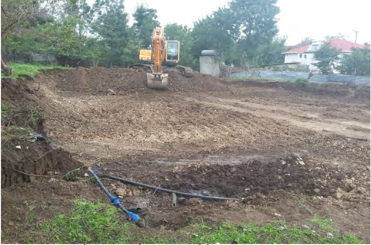
DEVGERİř MAHALLESİ HANIM KONAđI İNřAATTI TEMEL KAZISI YAPILDI
