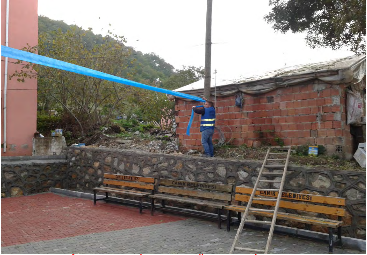
KIZILOĞLAK MAHALLESİ MERKEZ CAMİİ TAŞ DUVAR İMALATI YAPILDI.
