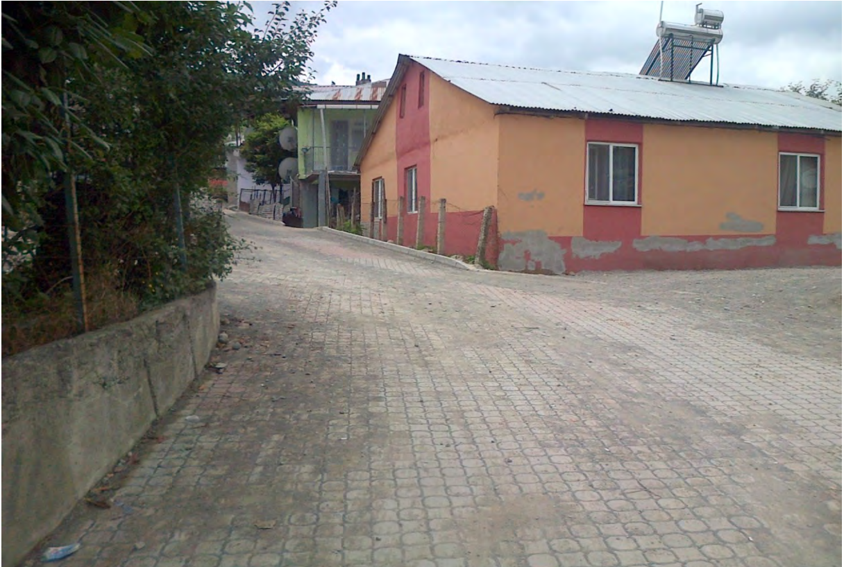
DEMİRCİ MAHALLESİNDE 2.325 m 2 PARKE 800 m BORDÜR YOL KAPLAMA İŞLERİ YAPILDI (YENİ)
