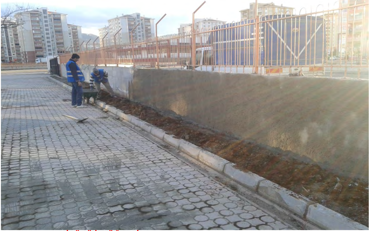
İNÖNÜ İLKÖĞRETİM OKULU ÇEVRE DUVAR SIVASI YAPILDI.
