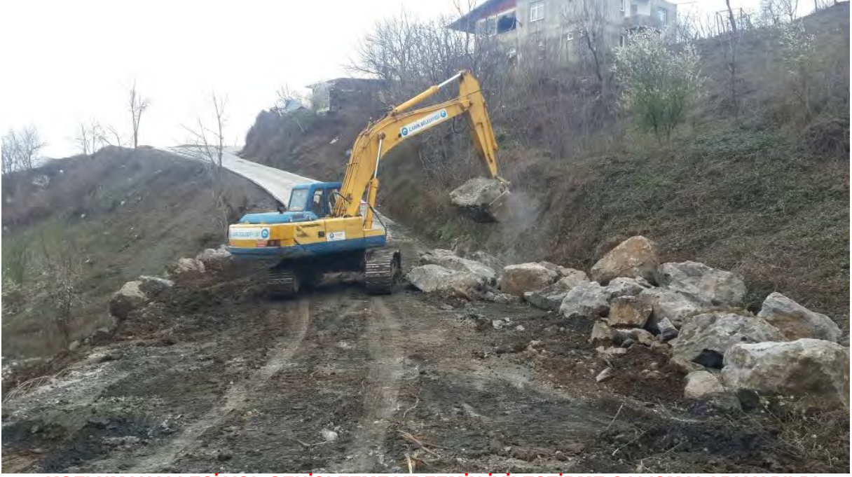
KOZLUMAHALLESİ YOL GENİŞLETME VE ZEMİN İYİLEŞTİRME ÇALIŞMALARI YAPILDI
