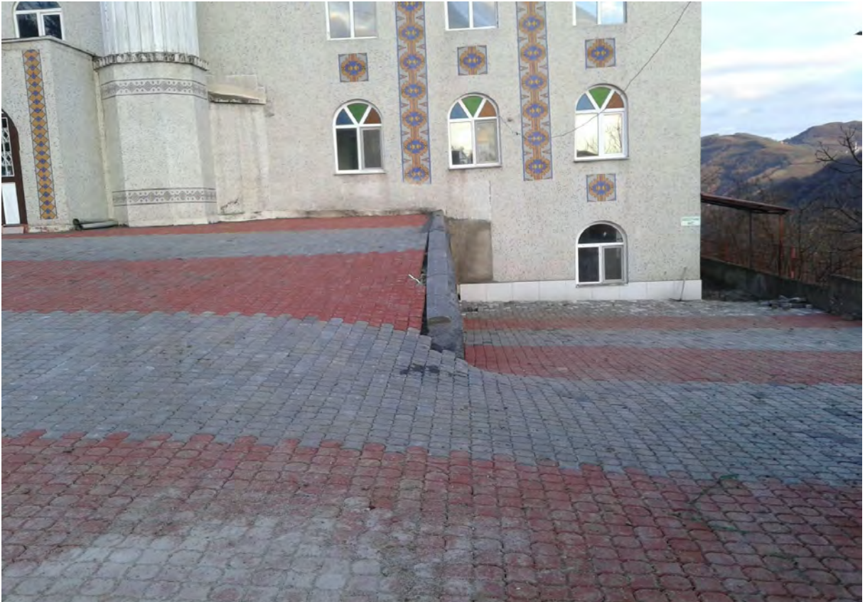
TOYGAR MAHALLESİ MERKEZ CAMİ AVLUSUNA 1200 m 2 DESENLİ PARKE KAPLAMA 110 m BORDÜR YAPILDI.
