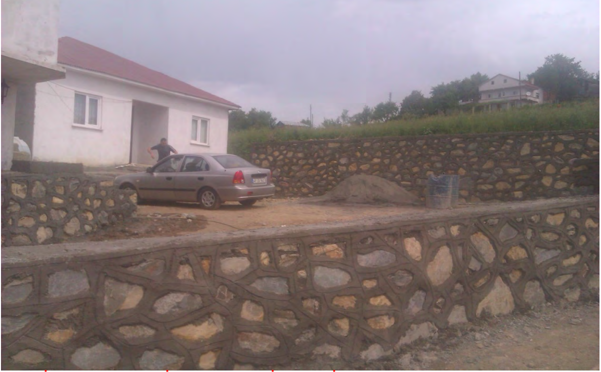
İMAMLAR HANYERİ MAHALLE CAMİ ÇEVRESİNE 130.55M3 TAŞ DUVAR YAPILDI.
