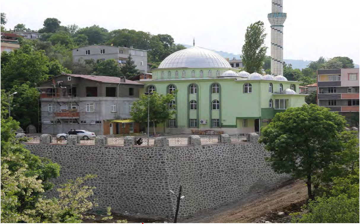
DERELER MERKEZ CAMİ ETRAFINA 2626.77M3 TAŞ DUVAR YAPILDI.
