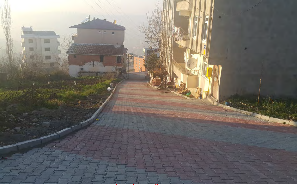
TEKNEPINAR MAHALLESİ YENİ MEVKİİ PARKE ÇALIŞMASI YAPILDI.
