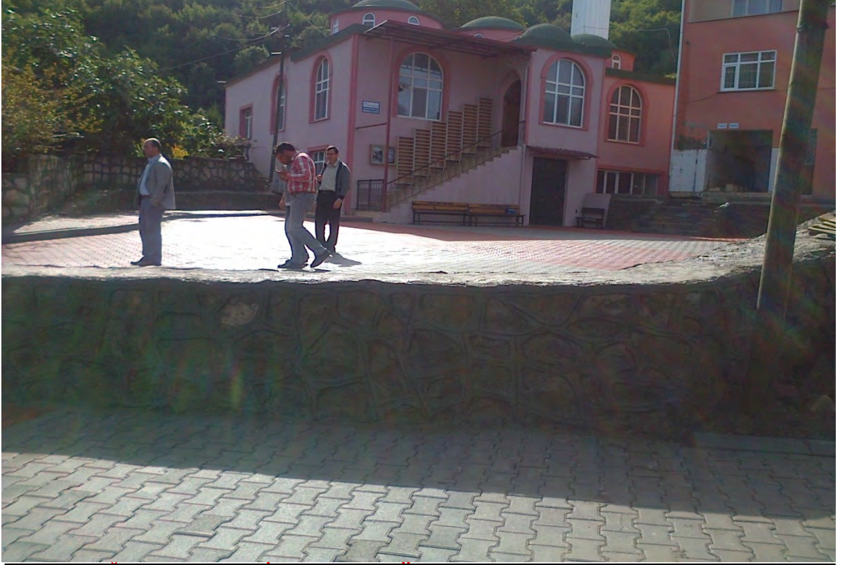
KIZIL OĞLAK MAHALLESİ MERKEZ CAMİİ ETRAFINA 110 m 3 TAŞ DUVAR YAPILDI.
