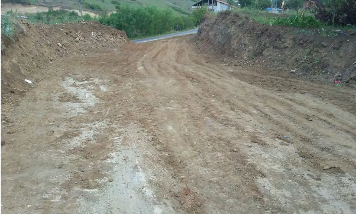
DÜVECİK MAHALLESİ YOL AÇMA ÇALIŞMALARIN YAPILDI.
