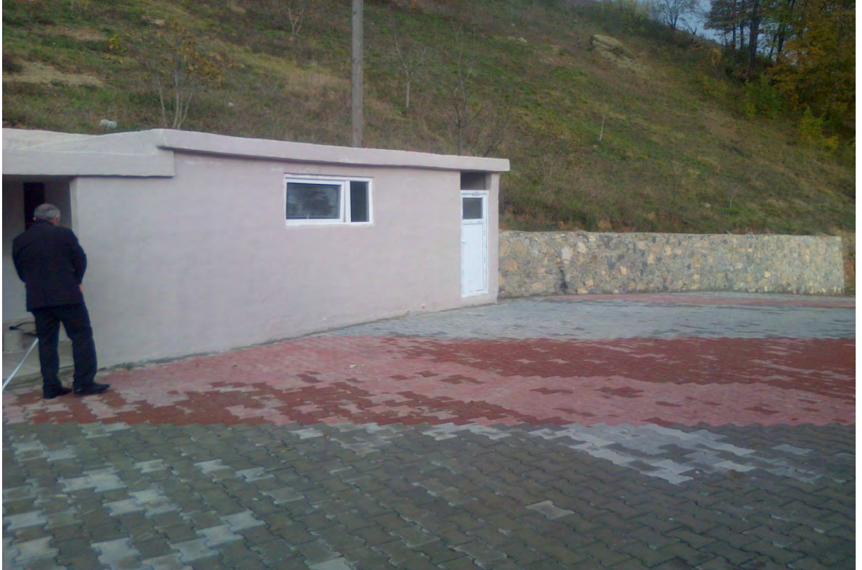
TEK KİRAZ MAHALLESİ MERKEZ CAMİİ BAĞÇESİNE YENİ ABDESTHANE VE TUVALET YAPILDI.
