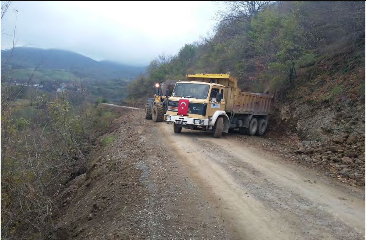
KOZLU MAHALLESİNDE YOL GENİŞLETME ÇALIŞMALARI YAPILDI
