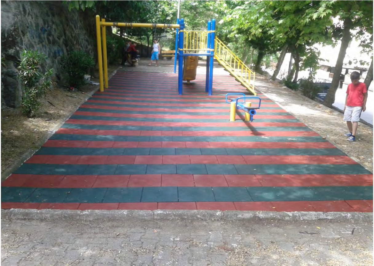
ULUDAĞ MAHALLESİ BİNBİR GECE SOKAKTA PARKIN KAUÇUK ZEMİNİ YAPILDI.
