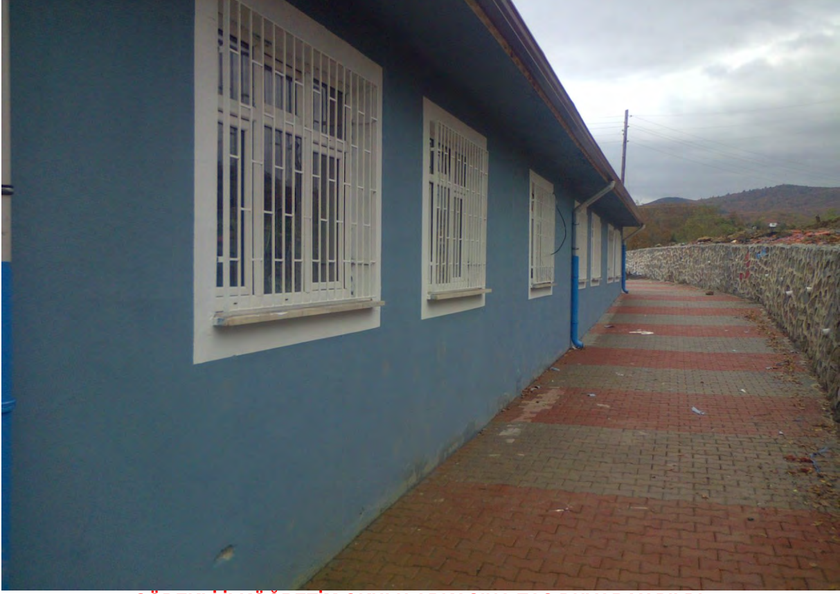
GÖDEKLİ İLKÖĞRETİM OKULU ARKASINA TAŞ DUVAR YAPILDI.
