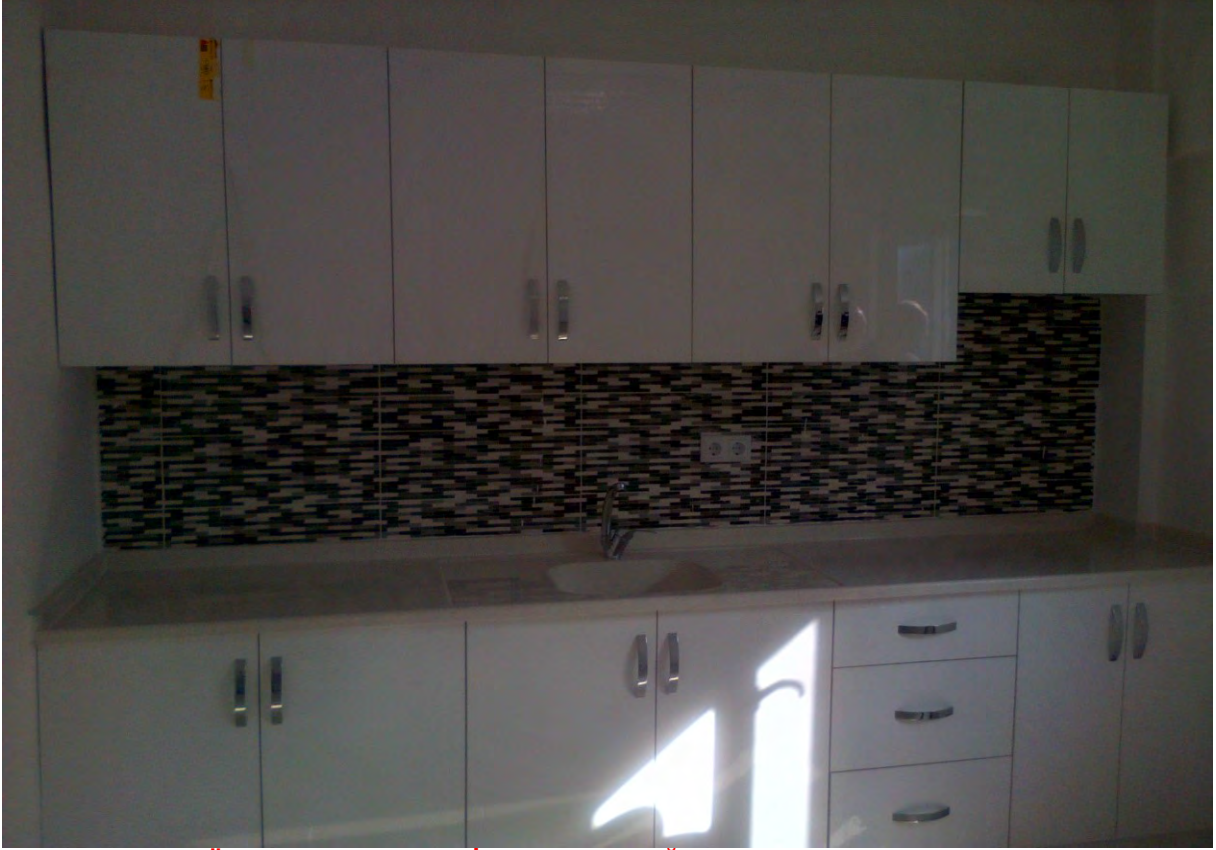
GÖLALAN MAHALLESİ HANIM KONAĞI 1 ADET MUTFAK YAPILDI.
