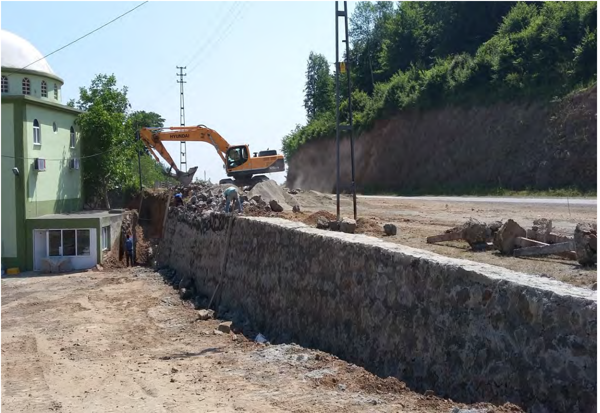
GÜRGENYATAK MAHALLESİ MERKEZ CAMİİ ÇEVRESİ TAŞ DUVAR YAPILDI.
