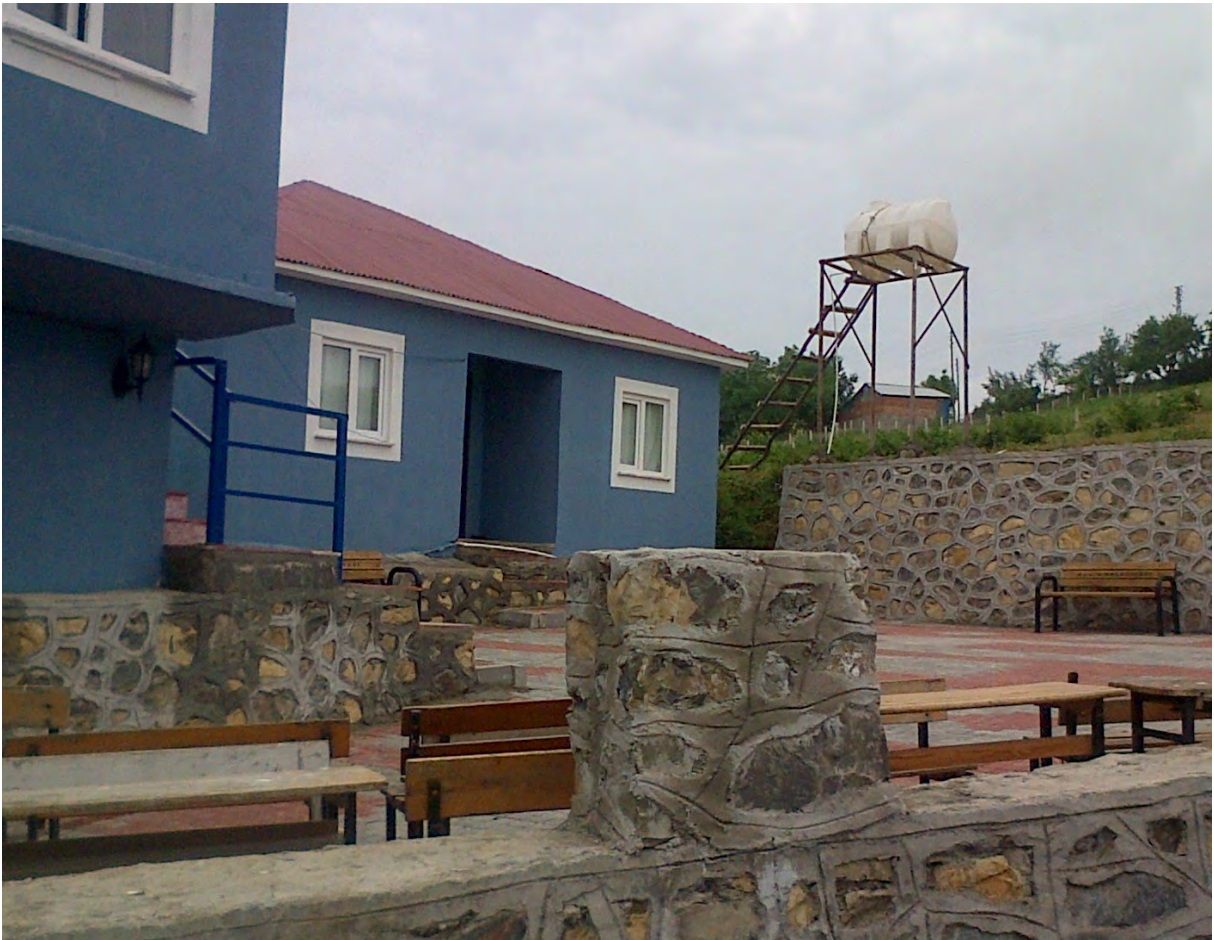
İMAMLAR HANYERİ MAHALLE CAMİ İLE İMAM LOJMANI DIŞ CEPHE BOYADI, CAMİ AVLUSUNA BANK VE ÇÖP KOVASI MONTAJI YAPILDI.
