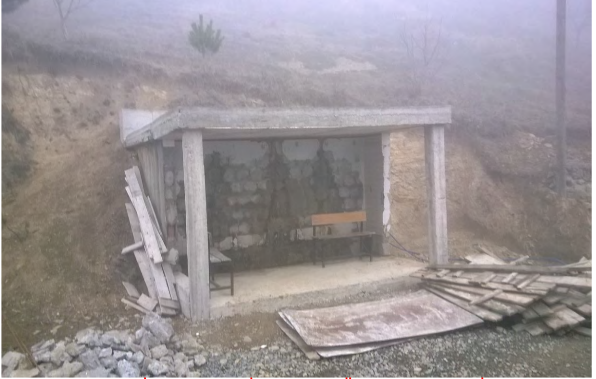
TEK KİRAZ MAHALLESİ MERKEZ CAMİİ ABDESTHANE (ESKİ)
