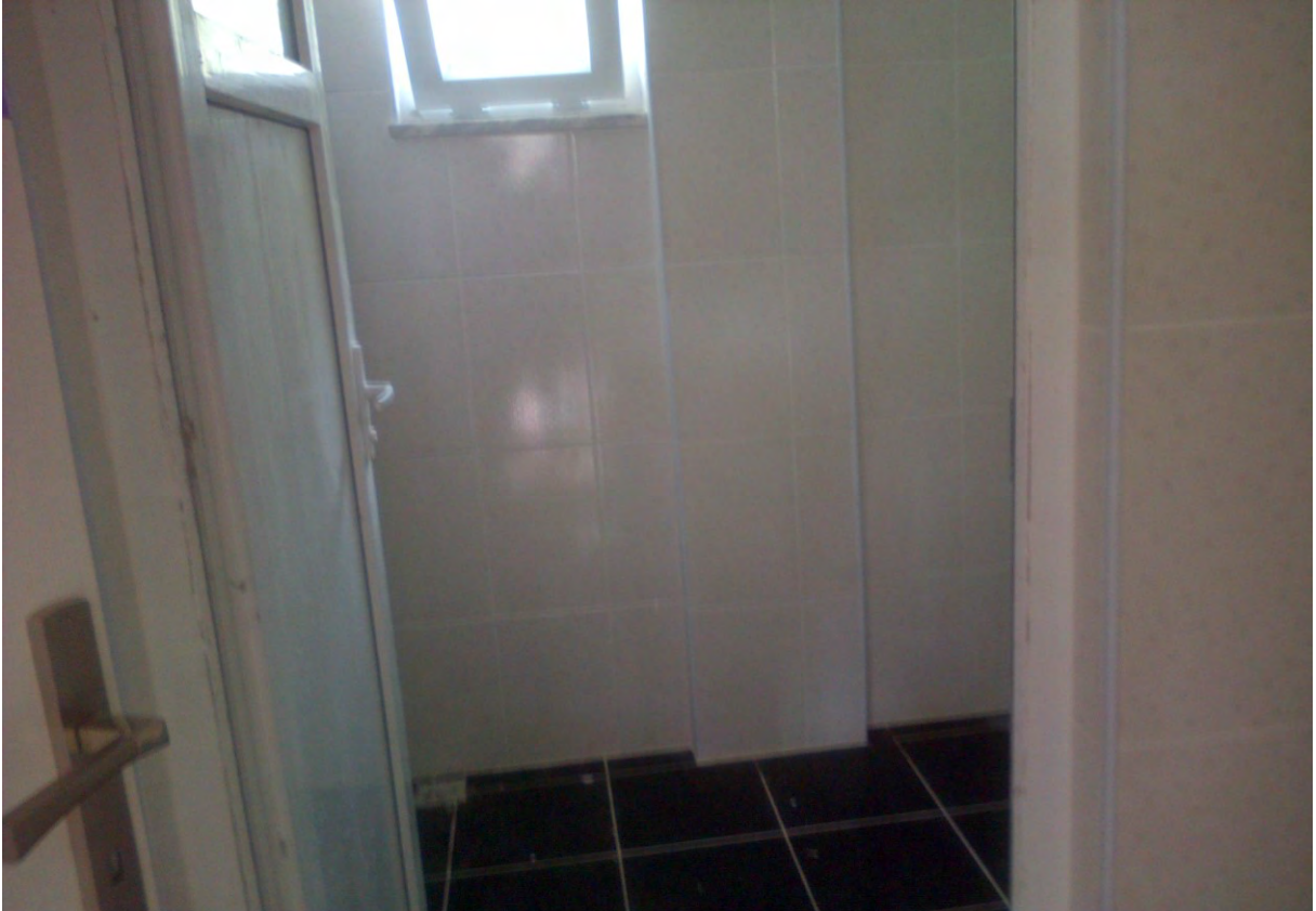
GÖLALAN MAHALLESİ HANIM KONAĞI TUVALET YAPILDI.
