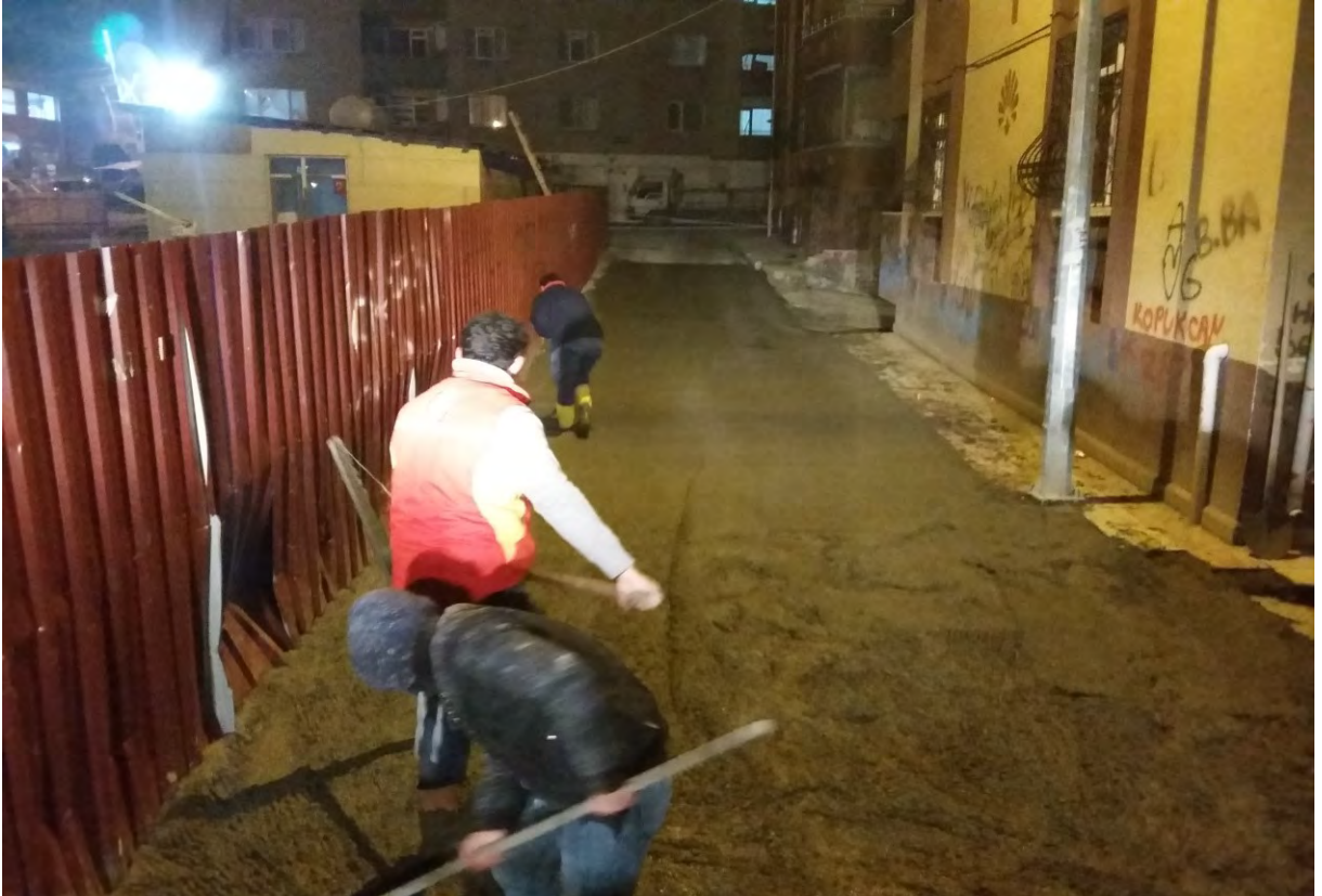
KARŞIYAKA MAHALLESİ UZUN KÖPRÜ SOKAKTA BETON YOL YAPILDI.
