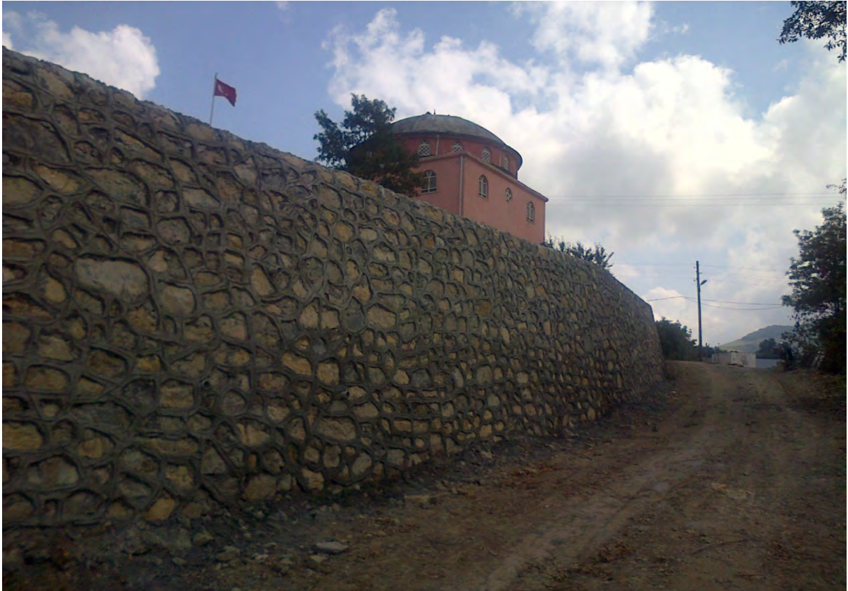
BAŞALAN MAHALLESİ ÇAKIRLAR CAMİİ ÇEVRESİ TAŞ DUVAR YAPILDI.
