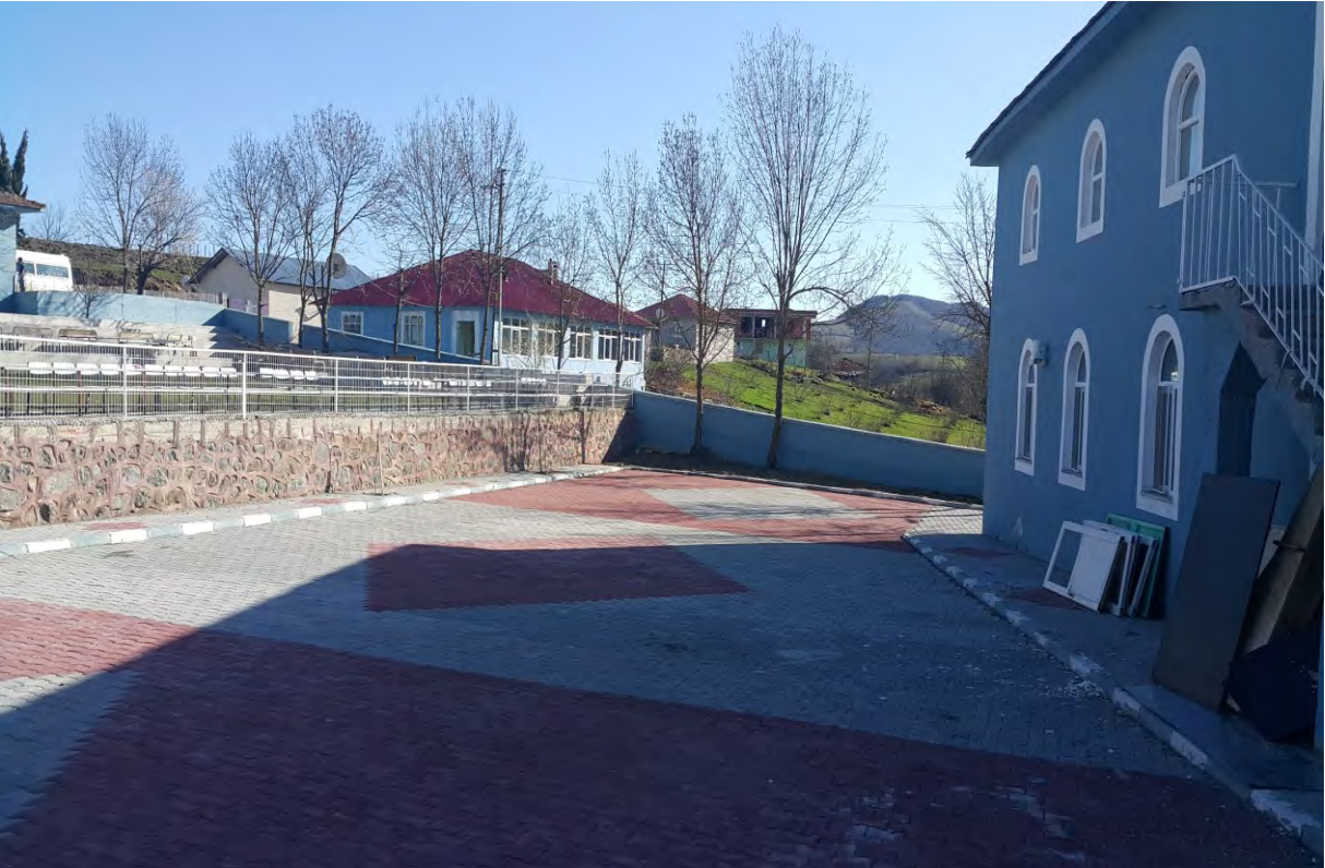
TUZAK MAHALLESİ MERKEZ CAMİİ AVLUSUNA 3.685 m 2 DESENLİ PARKE KAPLAMA 863 m BORDÜR, BANK VE ÇÖP KOVASI MONTAJI YAPILDI.
