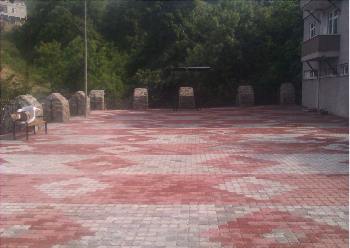
DERELER MERKEZ CAMİ AVLUSUNA 951 m 2 DESENLİ PARKE 100 m BORDÜR KAPLAMA YAPILDI.
