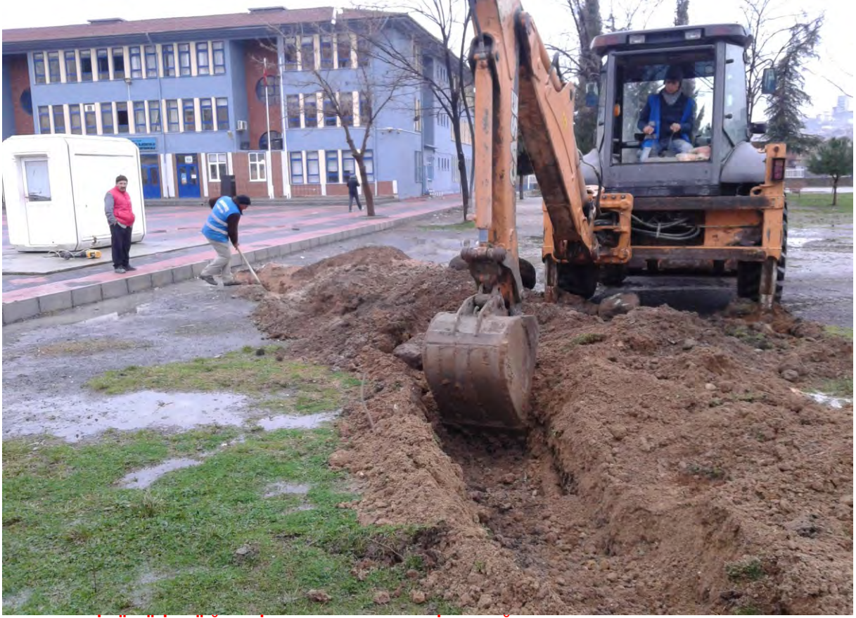
İNÖNÜ İLKÖĞRETİM OKULU BAHÇESİNE YAĞMUR SUYU HATTI YAPILDI.
