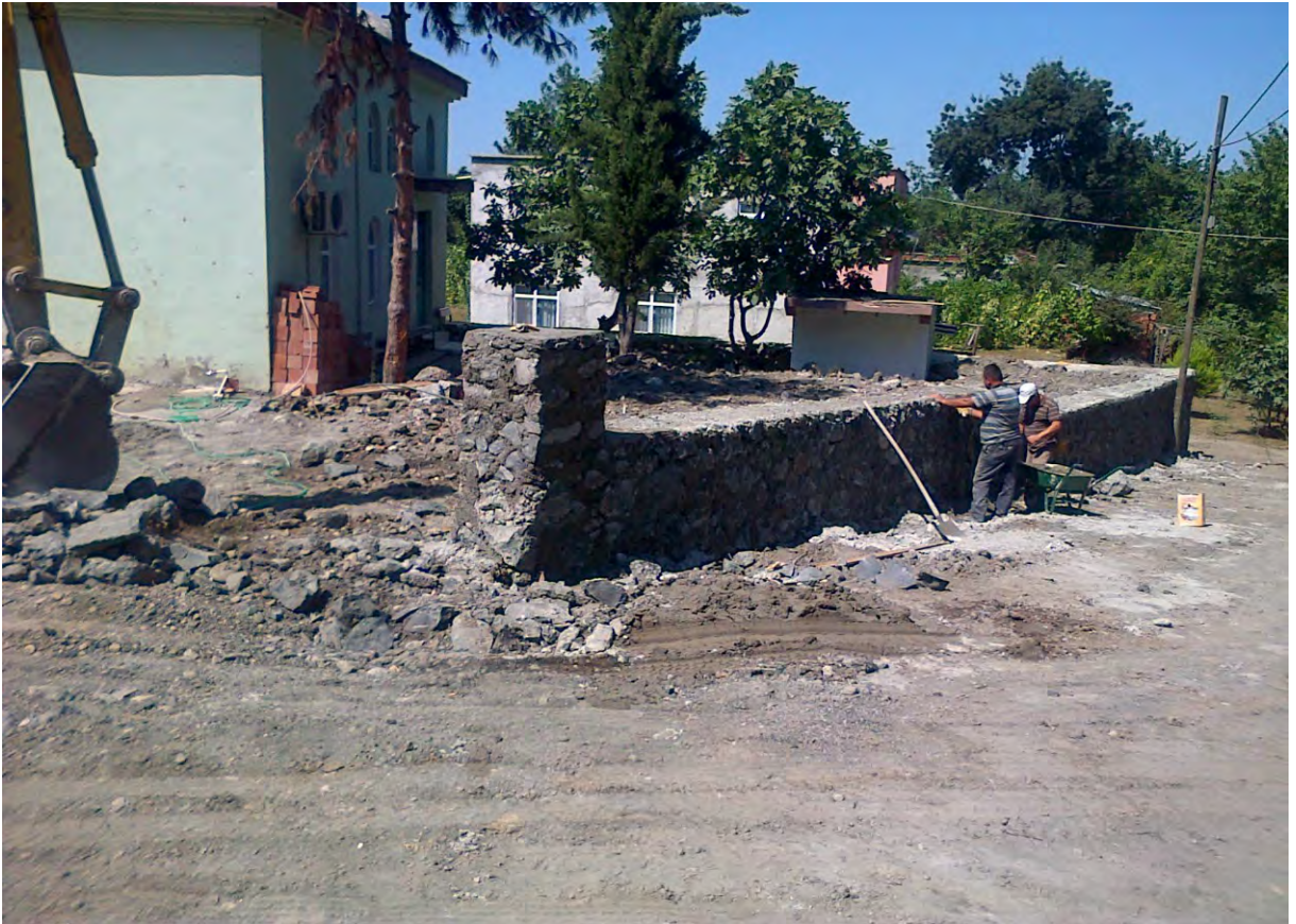
KOZLU MAHALLESİ MERKEZ CAMİİ ÇEVRESİ TAŞ DUVAR YAPILDI.
