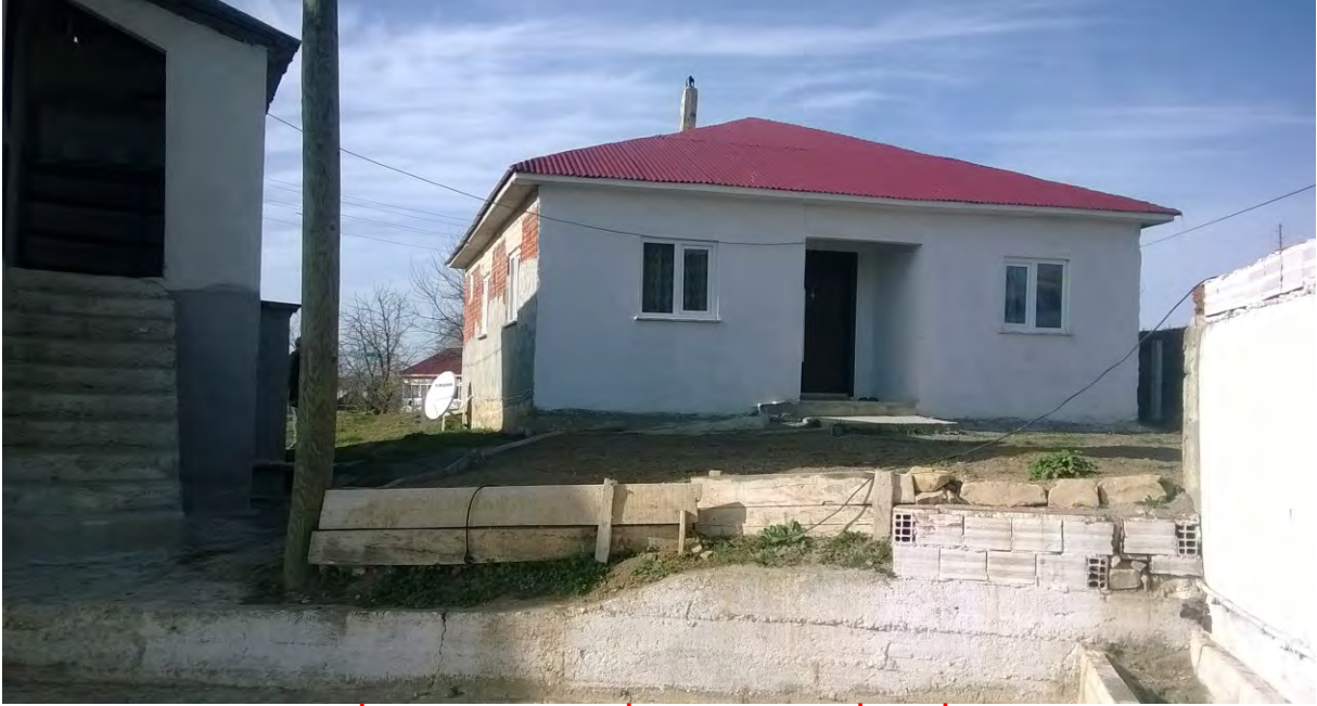
İMAMLAR HANYERİ MAHALLE CAMİ (ESKİ)
