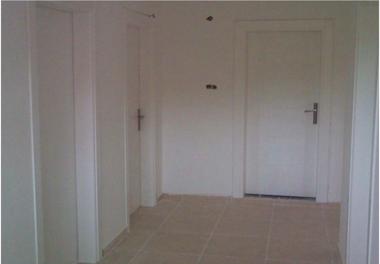
GÖLALAN MAHALLESİ HANIM KONAĞI İÇERİSİNDE SERAMİK, LAMINANT DÖŞEME, PENCERELER PVC OLARAK YAPILMIŞTIR.
