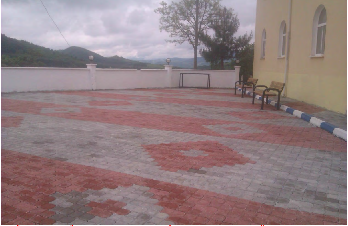
GÖKÇEPINAR GÜNEŞTEPE MAHALLE CAMİ AVLUSUNA BANK VE ÇÖP KOVASI MONTAJI YAPILDI.
