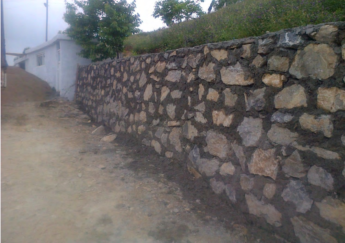
TEKKİRAZ MAHALLESİ MERKEZ CAMİİ ÖNÜ TAŞ DUVAR YAPILDI.
