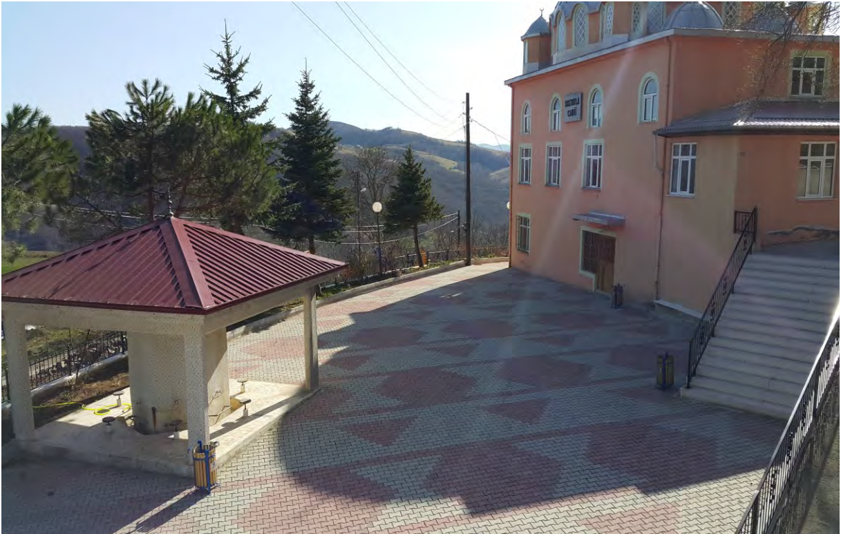
KAŞYAYLA MAHALLESİ MERKEZ CAMİ AVLUSUNA 1.733 m 2 DESENLİ PARKE KAPLAMA 383 m BORDÜR YAPILDI.
