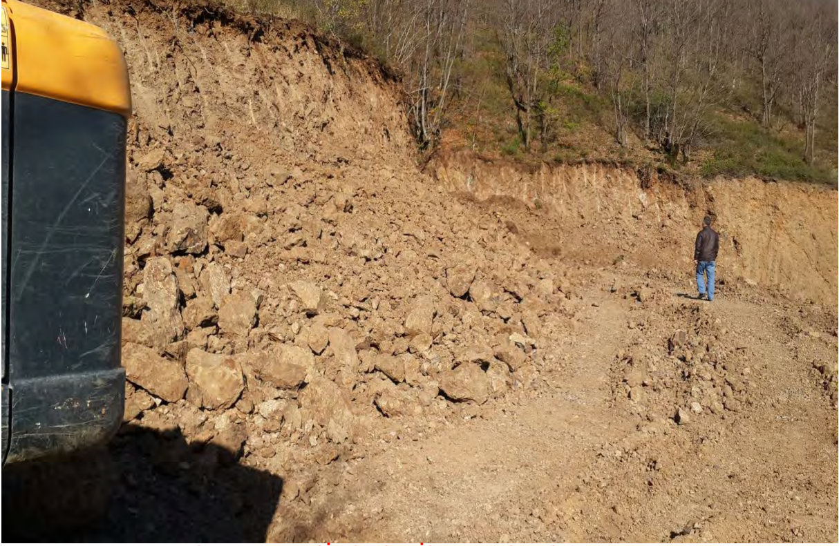
AVLUCA MAHALLESİ YOL GENİŞLETME ÇALIŞMALARI YAPILDI
