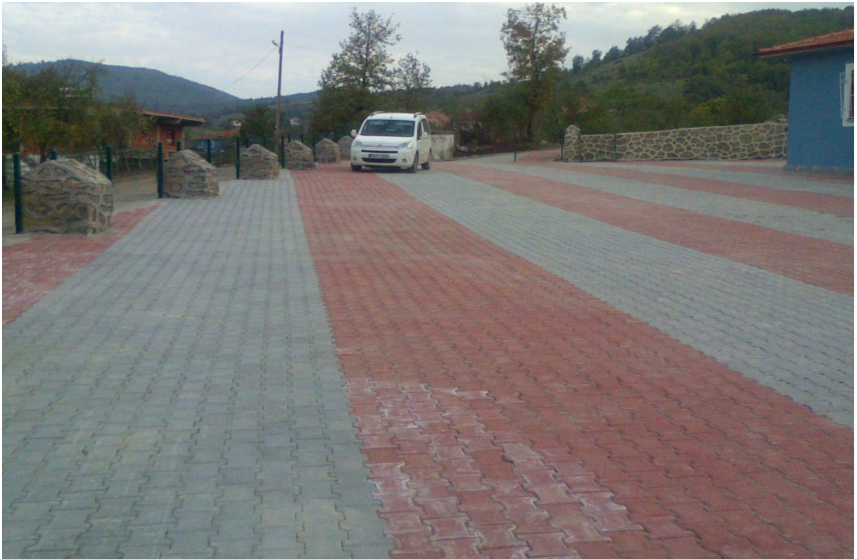
GÖDEKLİ İLKÖĞRETİM OKULU ETRAFINA 773 m 3 TAŞ DUVAR YAPILDI.
