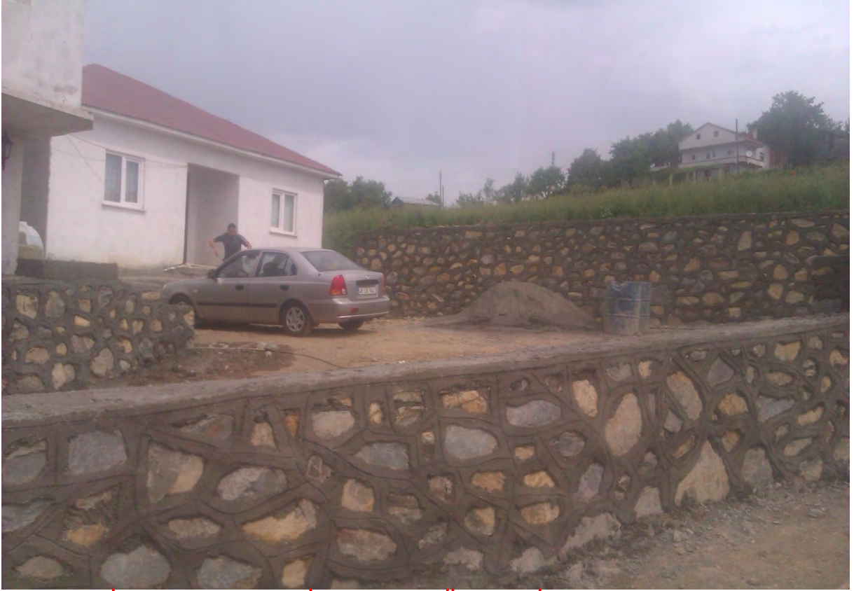
İMAMLAR MAHALLESİ MERKEZ CAMİİ ÇEVRESİ TAŞ DUVAR YAPILDI.
