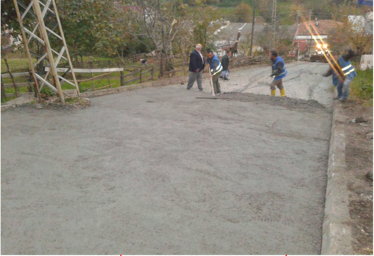
TEKNEPINAR MAHALLESİ 576. VE 577. SOKAKLARDA BETON YOL İMALATI YAPILDI.
