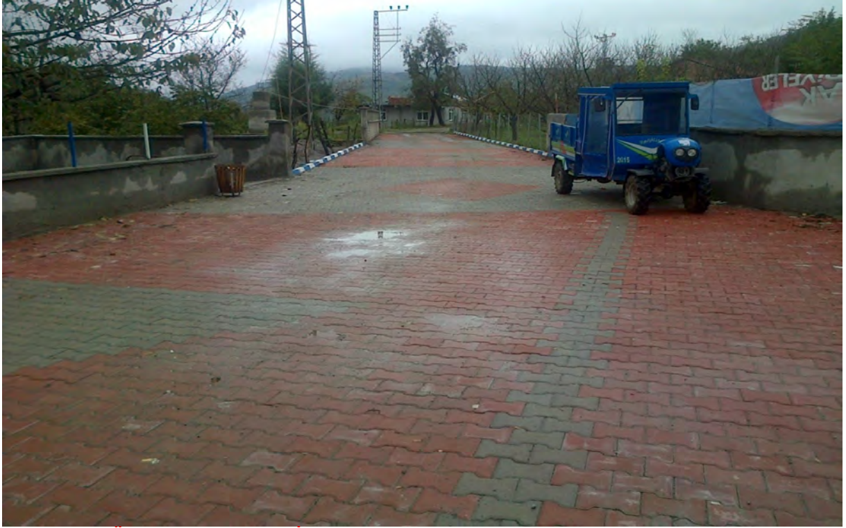
GÖLALAN MAHALLESİ MEZARLIK YOLUNDA 1.730 m 2 PARKE YOL YAPILDI.
