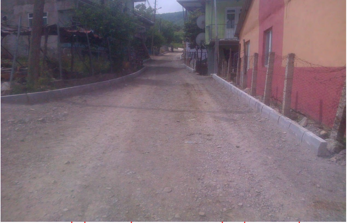
DEMİRCİ MAHALLESİ PARKE YOL KAPLAMA İŞLERİ YAPILDI (ESKİ)
