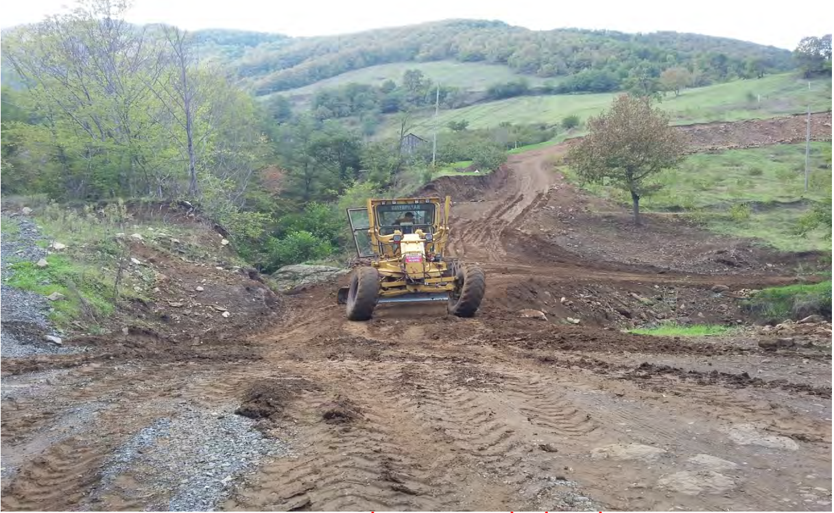
ADATEPE MAHALLESİNDE YOL TESVİYE İŞLERİ YAPILDI
