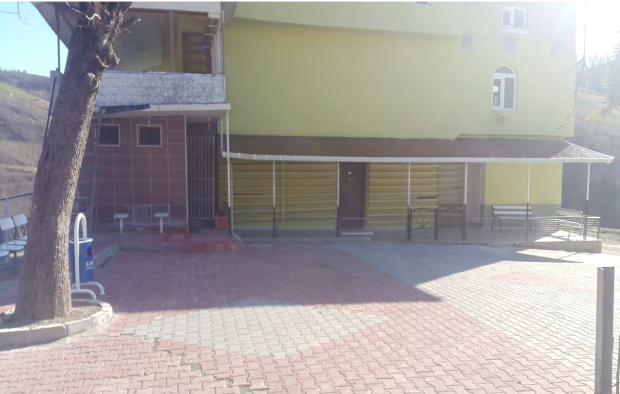
TUZAK MAHALLESİ SİVASLI CAMİİ AVLUSUNA DESENLİ PARKE KAPLAMA, BANK VE ÇÖP KOVASI MONTAJI YAPILDI.
