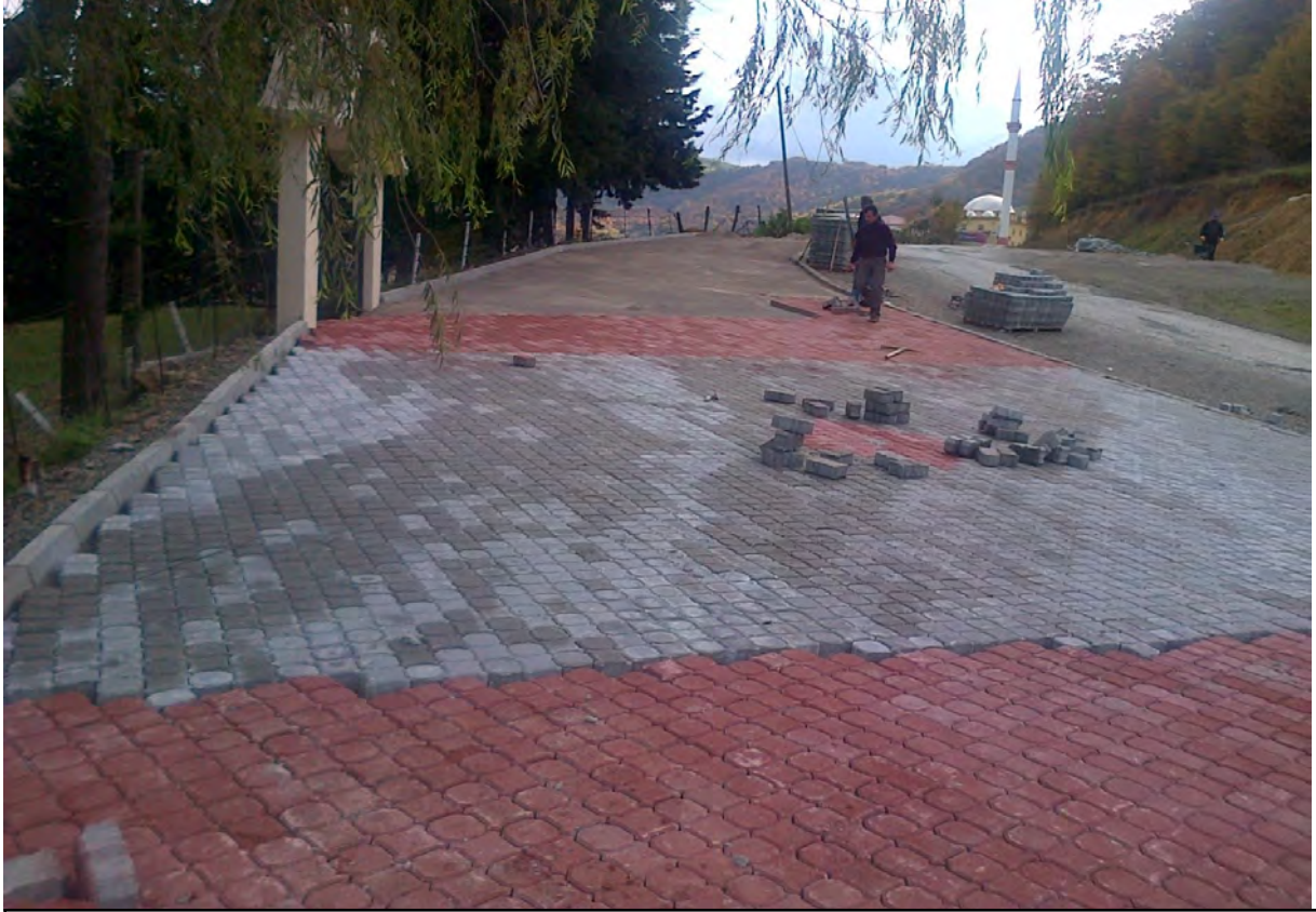
YENİ KÖY MAHALLESİ MEZARLIK YOLUNDA 1.420 m 2 PARKE 428 m BORDÜR YOL YAPILDI.
