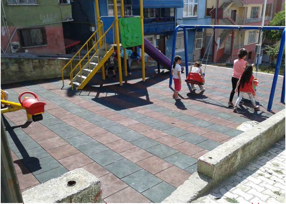
GAZİ OSMAN PAŞA MAHALLESİ SUNGURBEY SOKAKTA PARKIN KAUÇUK ZEMİNİ YAPILDI.
