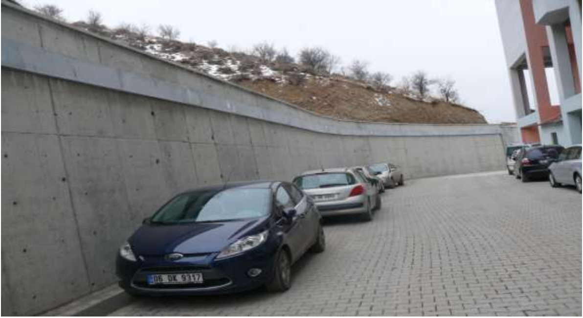
-Çankırı 150 Yataklı Devlet Hastanesinin istinat duvarı yapım işi
