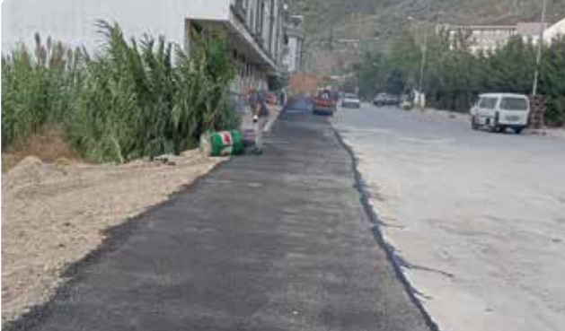
Asfaltlama ve Yol Tamir Çalışmaları
