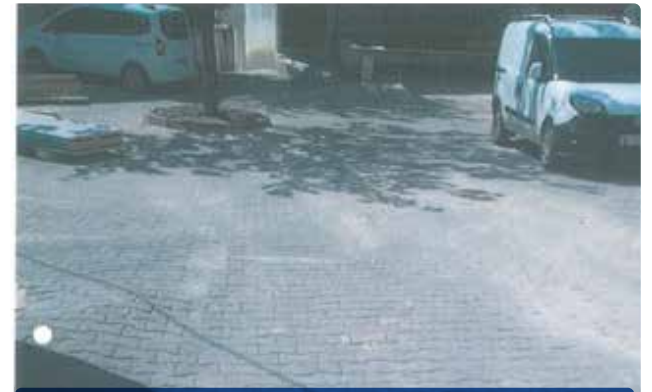
Adliye ve Güvenli Mah. 3000 m 2 Taş Parke Çalışması Yapılmıştır.
