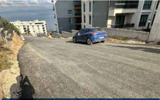
Asfaltlama ve Yol Tamir Çalışmaları
