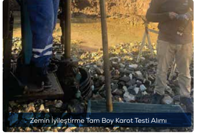
Zemin İyileştirme Uygulama Kontrolü
