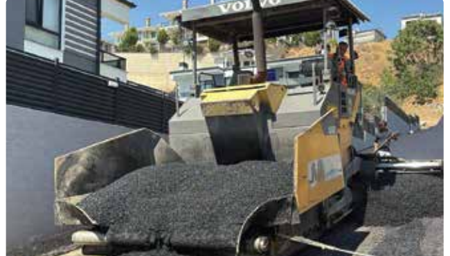
Asfaltlama ve Yol Tamir Çalışmaları
