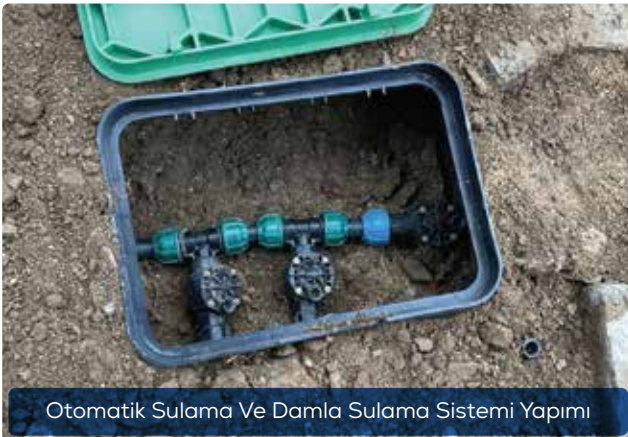
Otomatik Sulama Ve Damla Sulama Sistemi Yapımı
