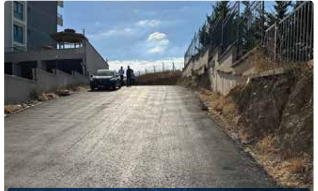
Asfaltlama ve Yol Tamir Çalışmaları
