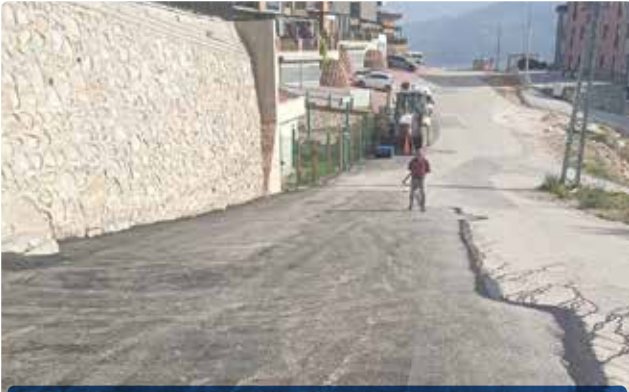
Asfaltlama ve Yol Tamir Çalışmaları
