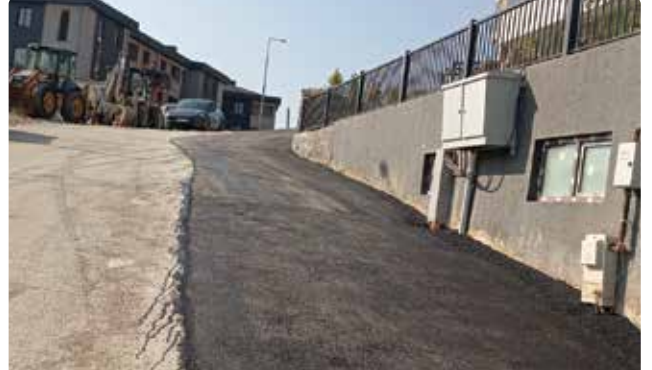
Asfaltlama ve Yol Tamir Çalışmaları
