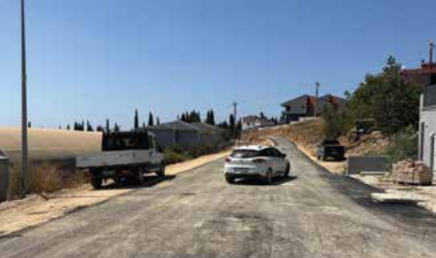
Asfaltlama ve Yol Tamir Çalışmaları
