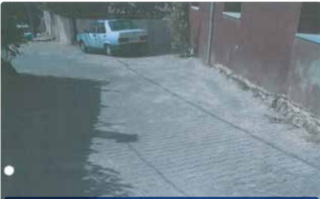
Adliye ve Güvenli Mah. 3000 m 2 Taş Parke Çalışması Yapılmıştır.
