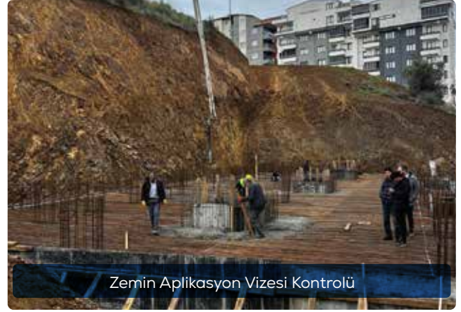
Zemin Aplikasyon Vizesi Kontrolü
