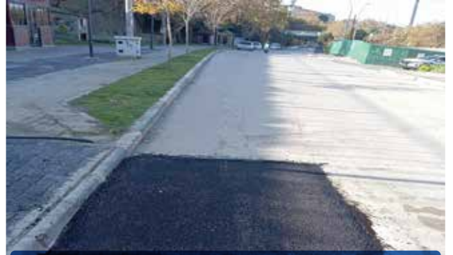
Asfaltlama ve Yol Tamir Çalışmaları
