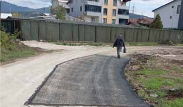
Asfaltlama ve Yol Tamir Çalışmaları
