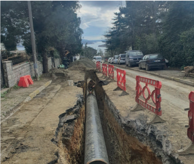
İçme Suyu Şebeke Çalışması
