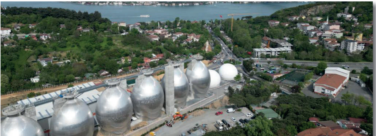
Baltalımanlı Biyolojik Atık Su Arıtma Tesisi
