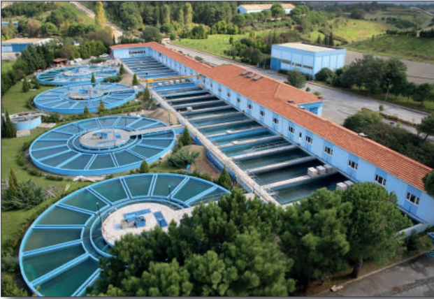
Ömerli Çıme Suyu Arıtma Tesisi
