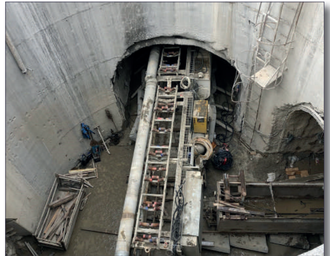
Atık Su Tünel Çalışmaları
