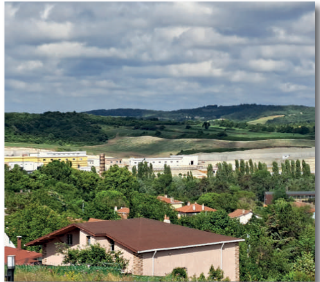
Terkos İçme Suyu Arıtma Tesisi İnşası
