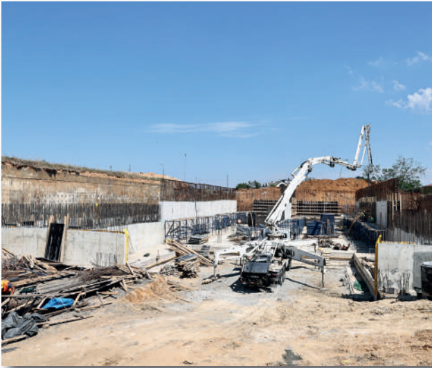
Şile İçme Suyu Deposu İnşası
