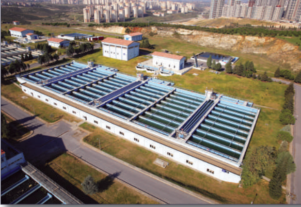
İkitelli Çıme Suyu Arıtma Tesisi
