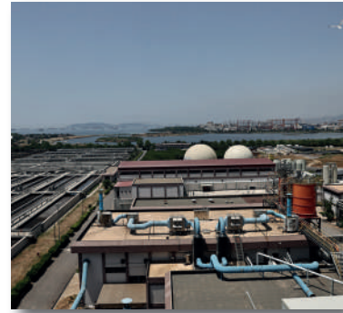
Tuzla İleri Biyolojik Atık Su Arıtma Tesisi
