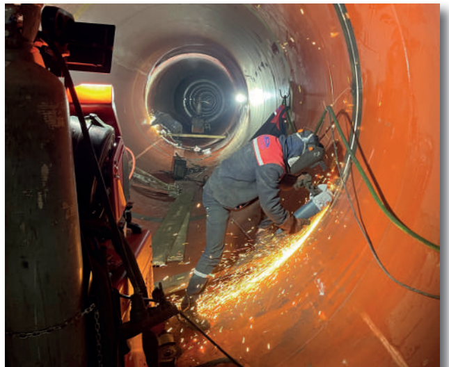
Kağıthane-Bahçelievler-Sefaköy İçme Suyu Tüneli Çalışması
