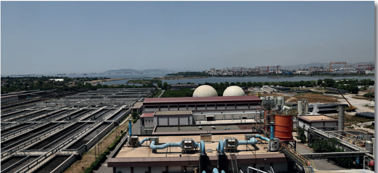
Tuzla İleri Biyolojik Atık Su Arıtma Tesisi
