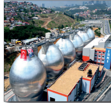
Baltalımanlı Biyolojik Atık Su Arıtma Tesisi
