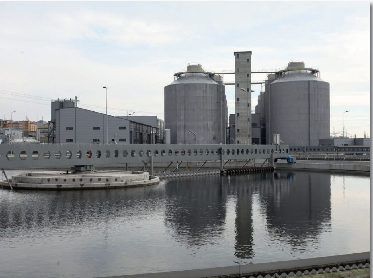
Ambarlı İleri Biyolojik Atık Su Arıtma Tesisi
