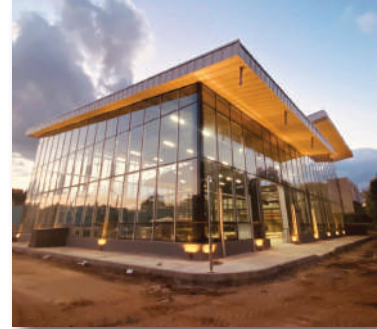
Şile Ultrafiltrasyon Membran İçme Suyu Arıtma Tesisi
