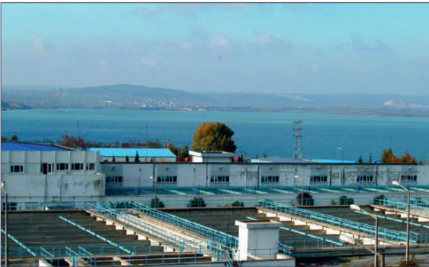
Büyüçekmece Çıme Suyu Arıtma Tesisi
