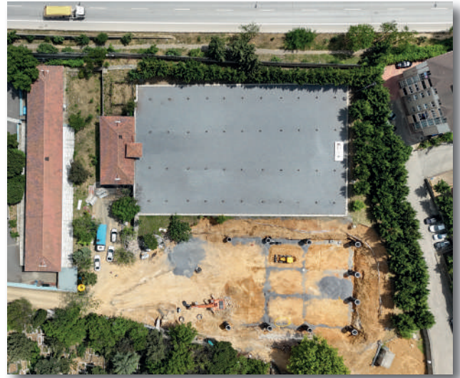
Kartal-Soğanlık İçme Suyu Deposu İnşası
