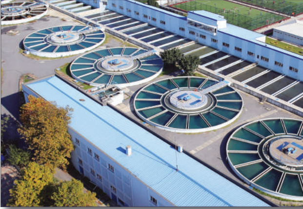
Kağıthane Çıme Suyu Arıtma Tesisi
