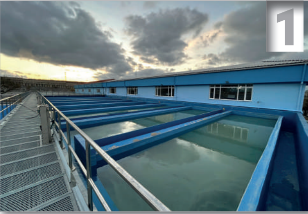
Taşoluk İçme Suyu Arıtma Tesisi
