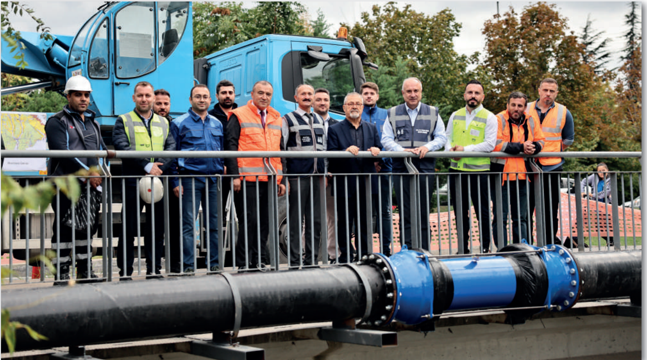
Deprem Muhtemel Risklerine Karşı - Esnek Boru Parçası Montaj Çalışması
