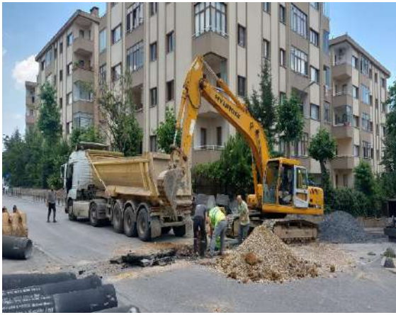
Fotoğraf 26: Yağmur Suyu Kanal Yapımı
