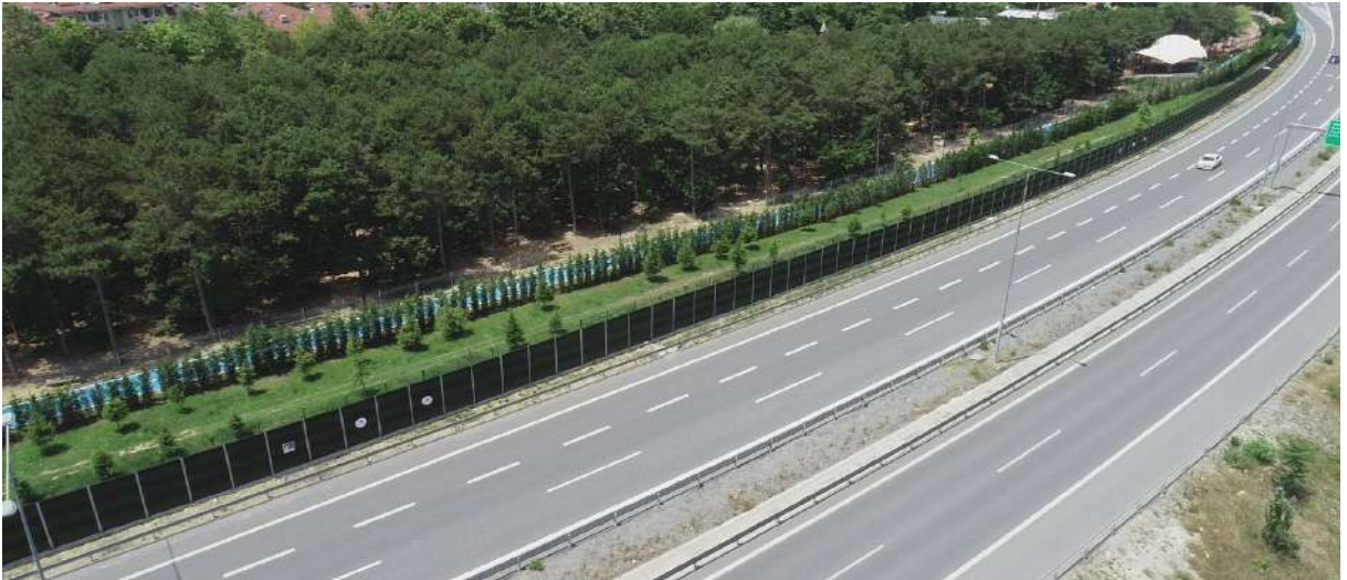
Fotoğraf 9: Çamlık Mahallesi Çevreyolu Bağlantısı Ses Bariyeri
