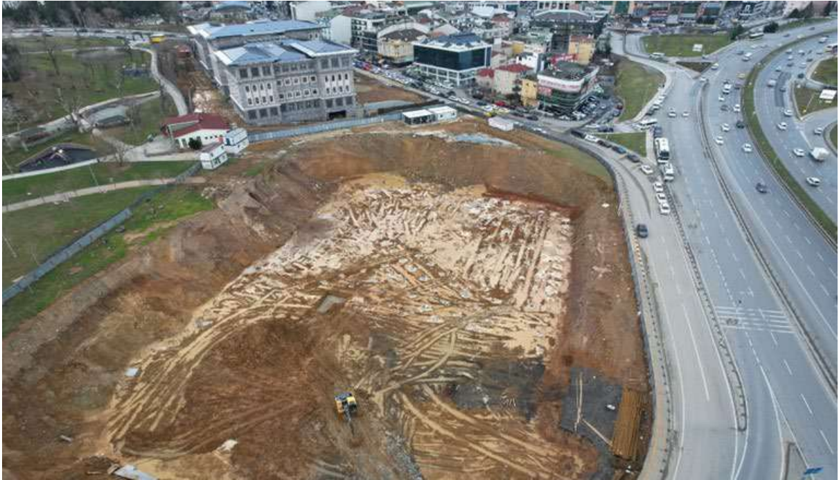
Fotoğraf 16: Kapalı Otopark Yapım İşi
