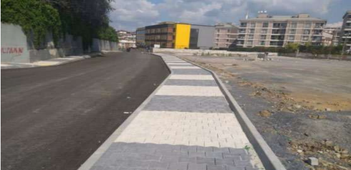
Fotoğraf 6: Bordür ve Tretuvar Çalışmaları
