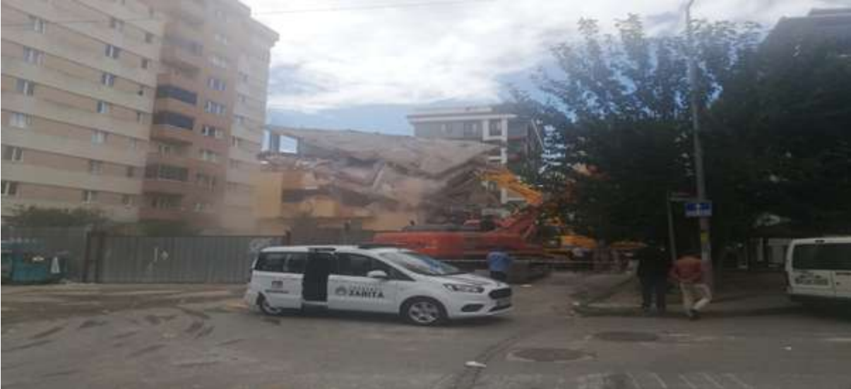
Fotoğraf 98: Kontrollü Yıkım Çalışması
