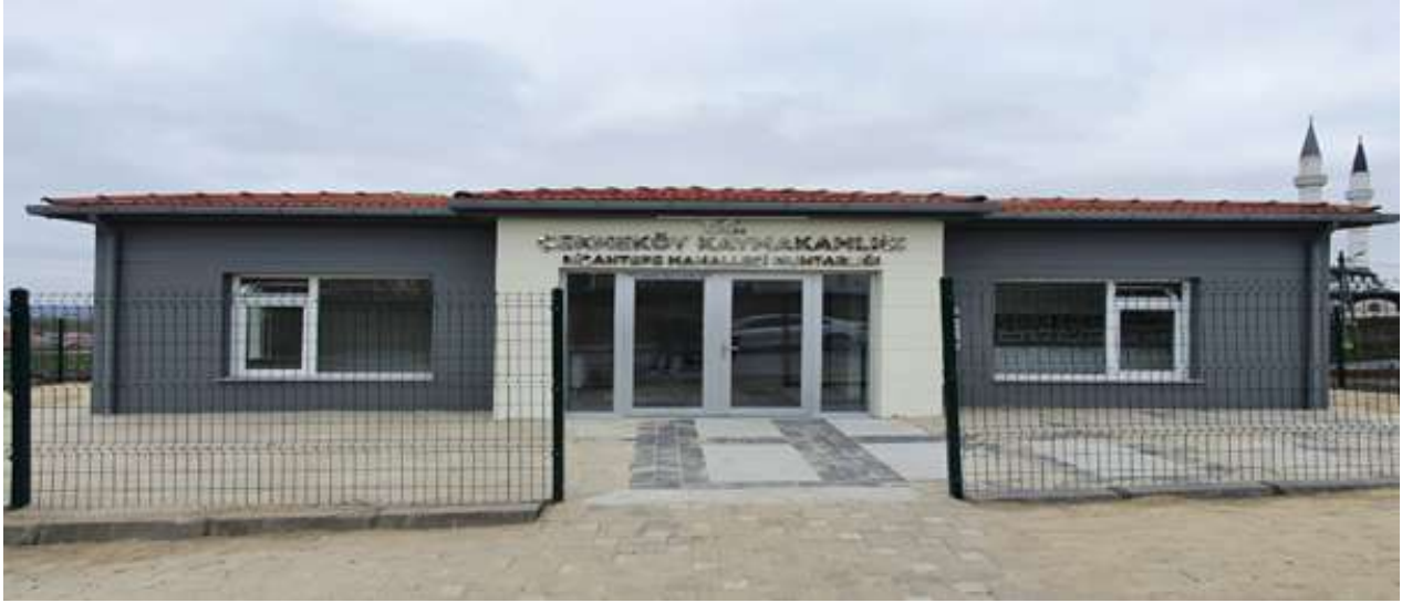
Fotoğraf 19: Nişantepe Mahallesi Muhtarlığı
