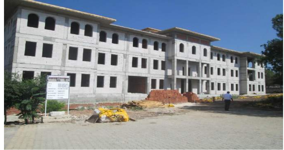
ÇAVDIR HÜKÜMET KONAĞI İNŞAAT FOTOĞRAFI
