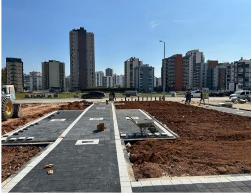
Batıkent Mahallesi 26101 Yeni Park Yapım Aşaması
