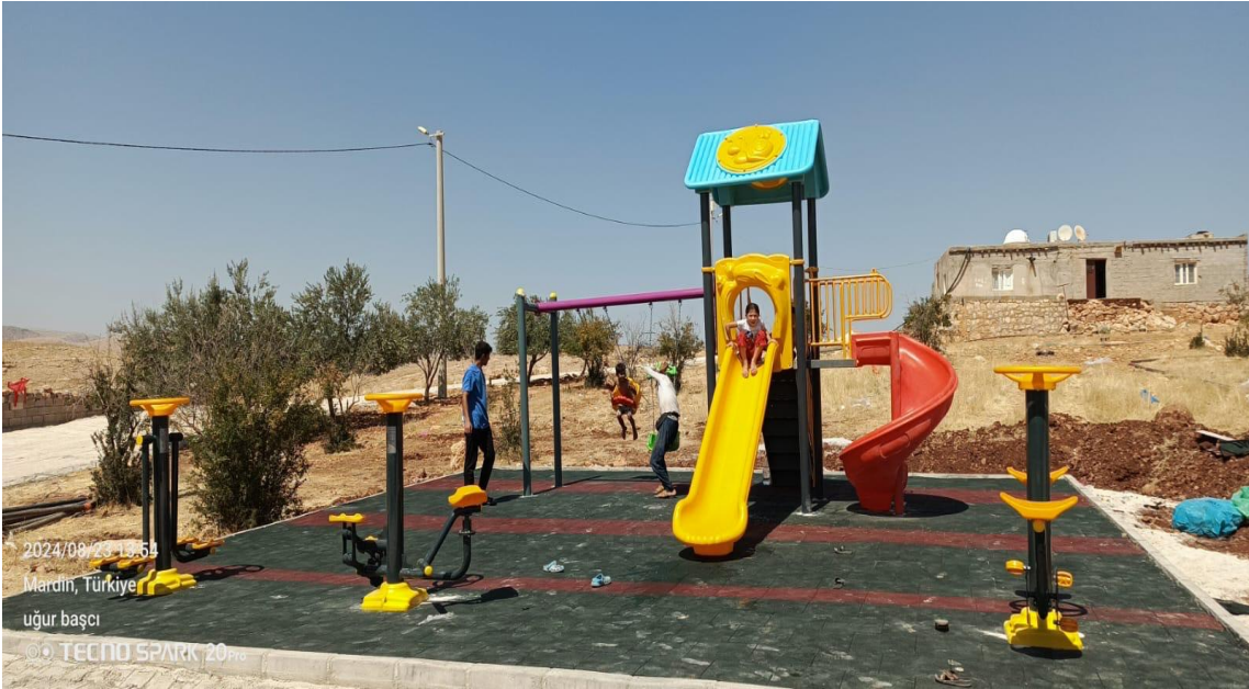
13-) Yeniköy Mahallesi lice mezzasına çocuk oyun grubu, kauçuk zemin ve spor aletleri kurulum çalışması tamamlandı.
