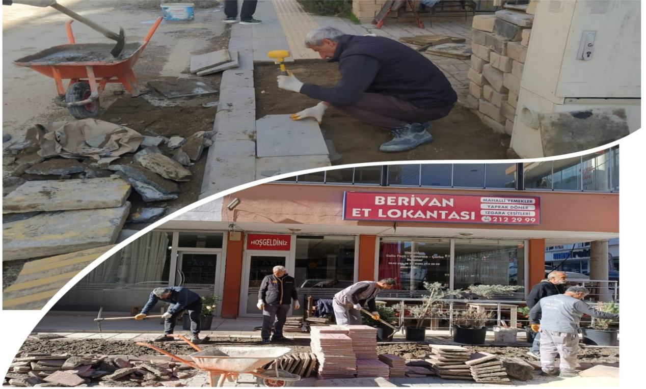
İlçe merkezimizde bulunan kaldırımlarımızın onarım çalışması yapıldı.
