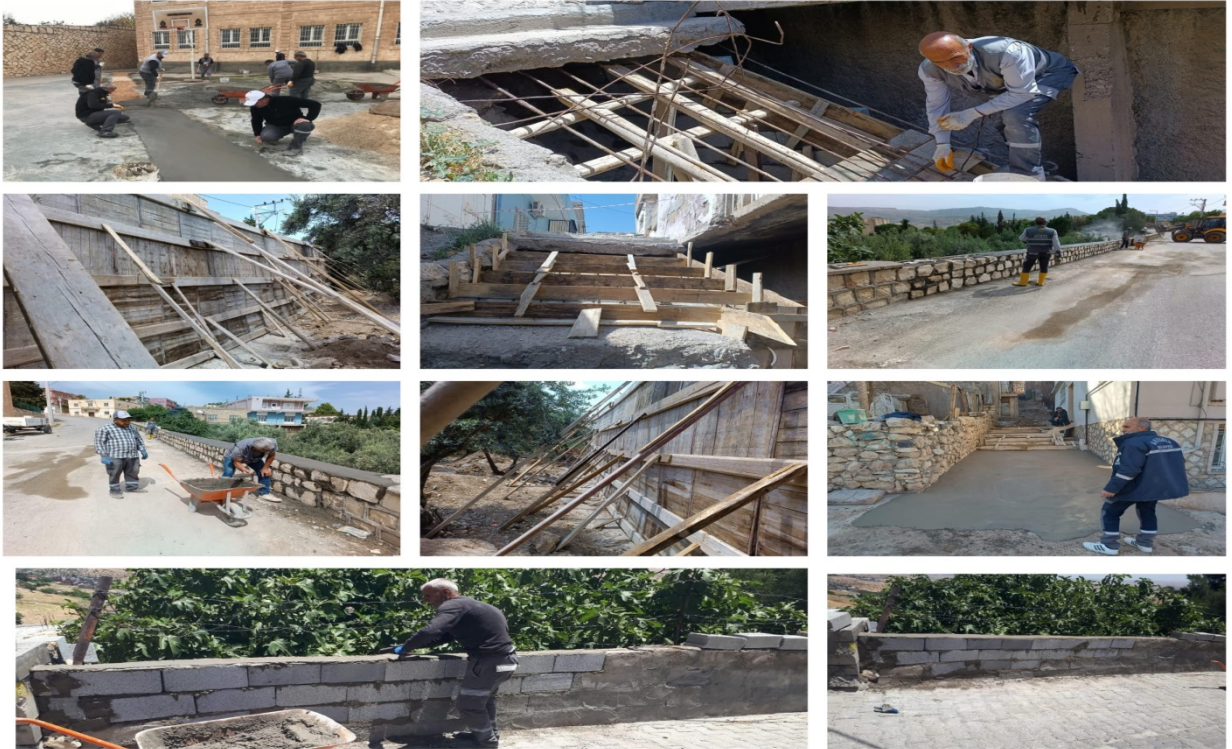
İlçemizin bir çok yerinde merdiven ve istinat duvarlarında betonlama çalışması yapıldı.
