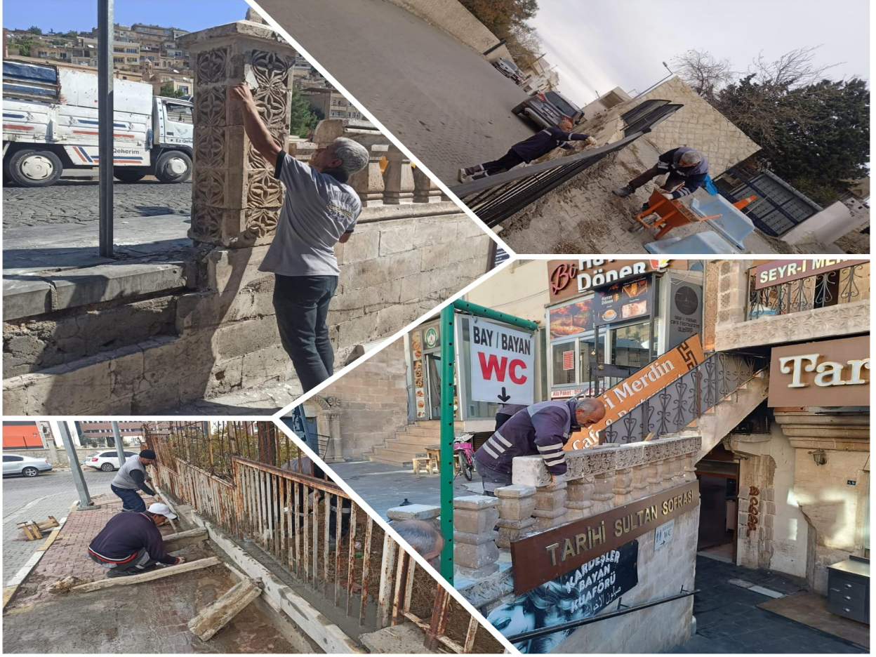
Sit Alanında bulunan sütun ve demir korkuluk onarım çalışması yapıldı.
