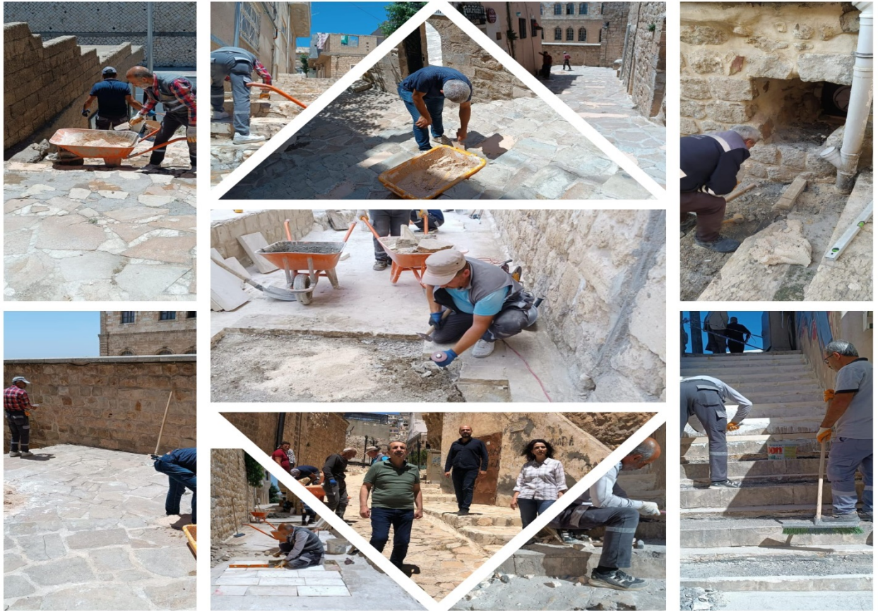
Sit alanında bulunan sokaklarımızda onarım çalışması yapıldı.
