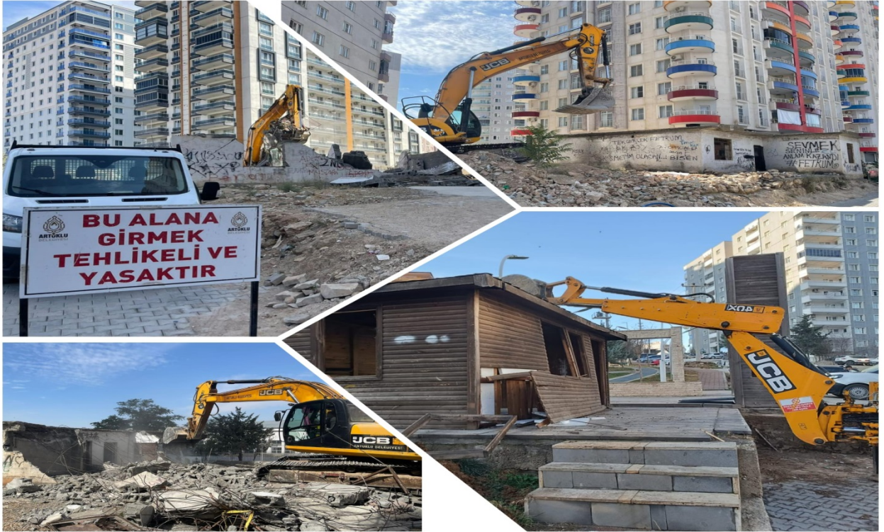
Metruk ve hasarlı binaların yıkımını gerçekleştirdik
