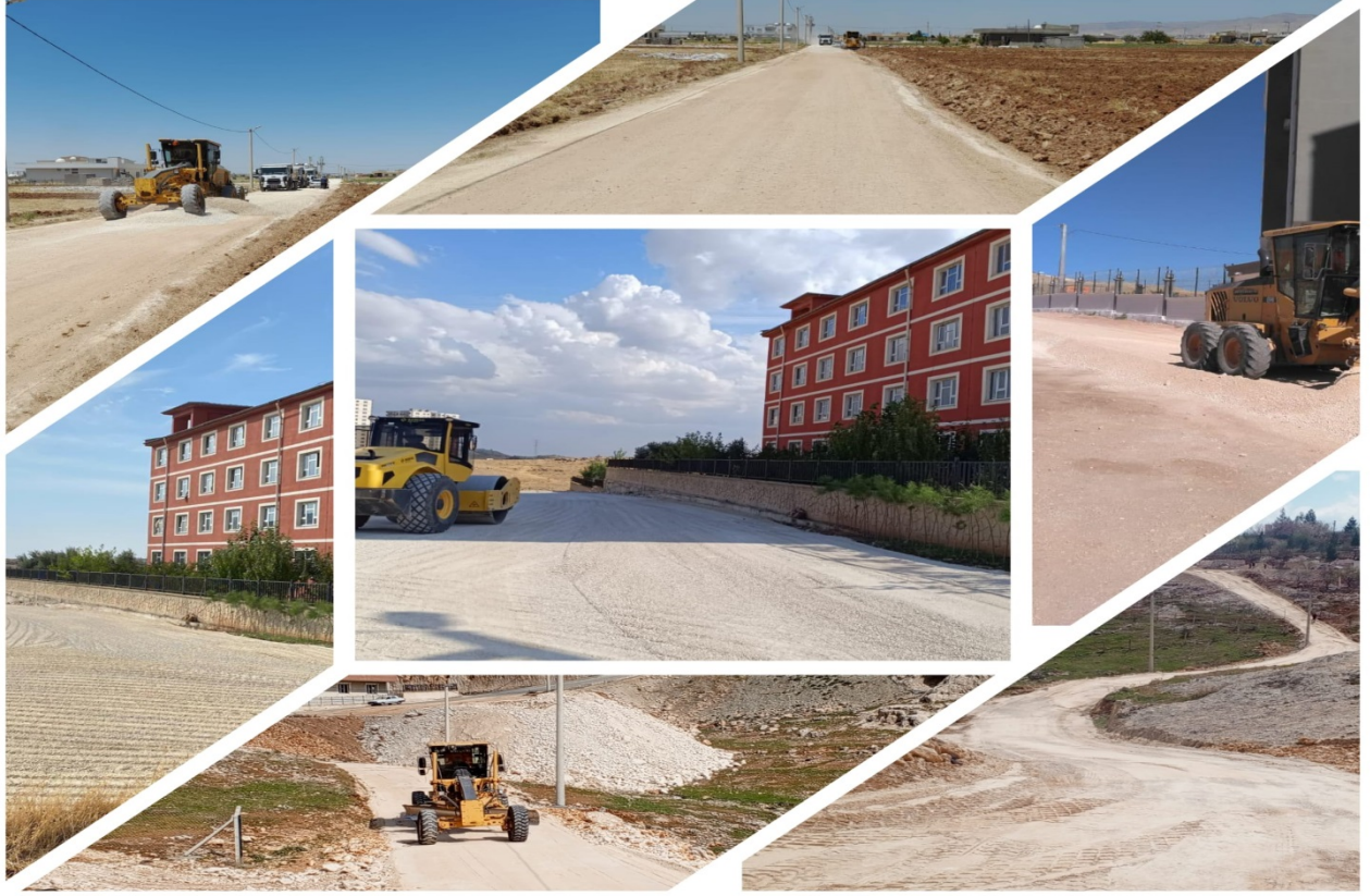
Mucur yol ıslahı ve stabilize çalışması yapıldı.
