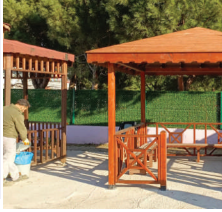
DR. LÜTFİ KIRDAR ŞEHİR HASTANESİ KAMELYA YAPIM ÇALIŞMASI
