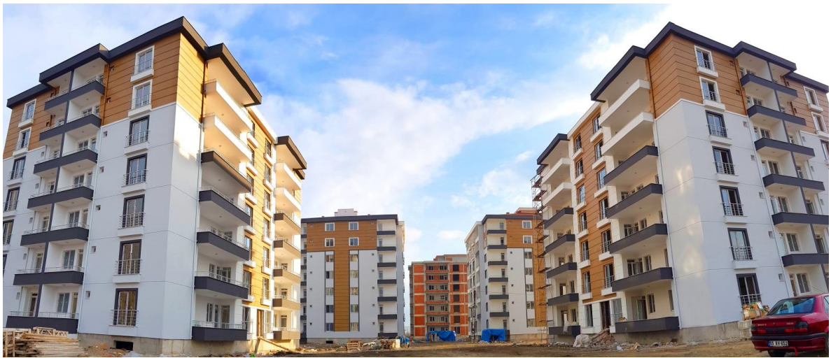
Kentsel Dönüşüm 1.Etap Çalışmaları
