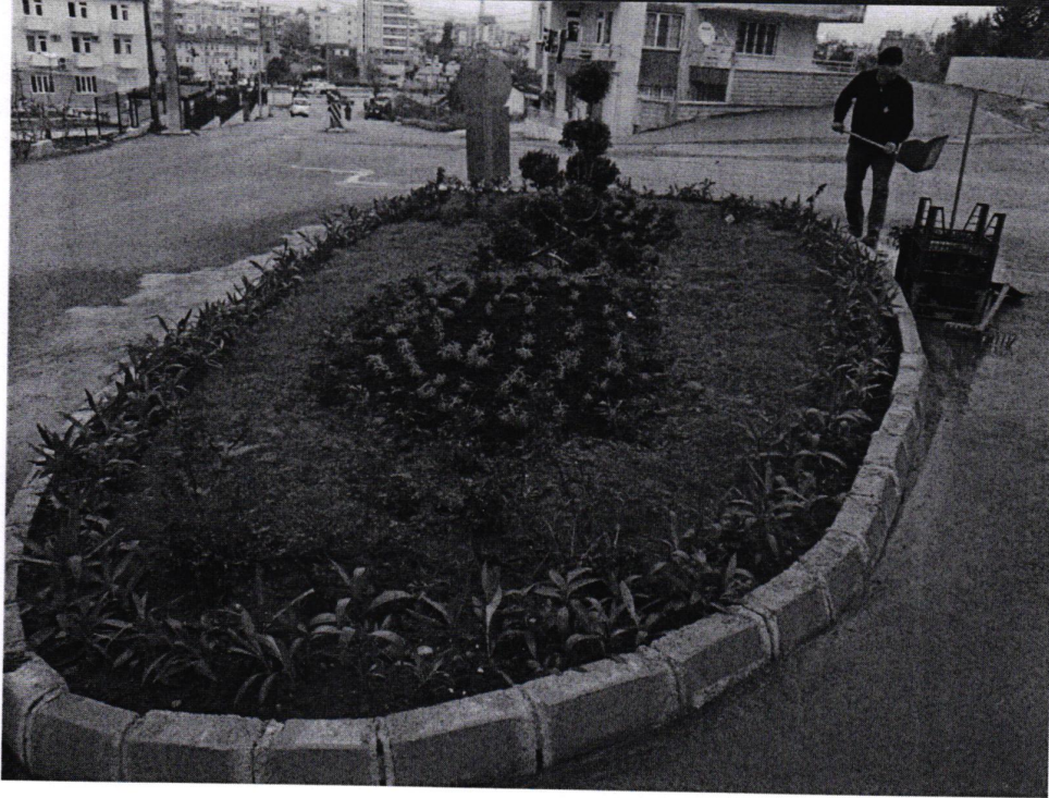
Belek mahallesi PTT kavşağında peyzaj çalışması yapıldı.
