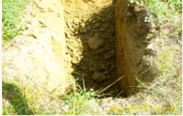
Şekil 23. Arazide Araştırma Çukuru Çalışmalarından Bir Görünüm
