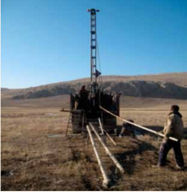
Şekil 20. Arazide Sondaj Çalışmalarından Bir Görünüm
