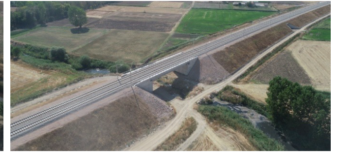
Km:199+505 Demiryolu Köprüsü
