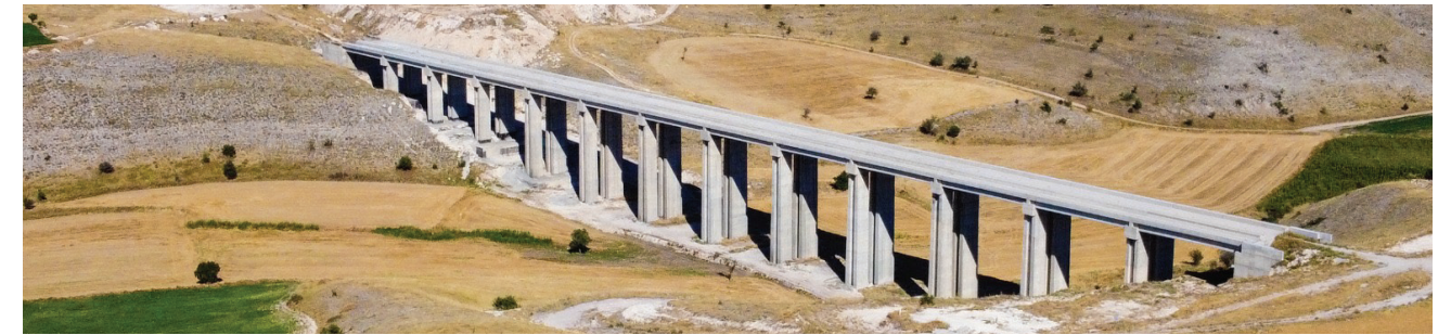
V14 Viyadüğü 426 m, Açıklık Sayısı : 13 m
