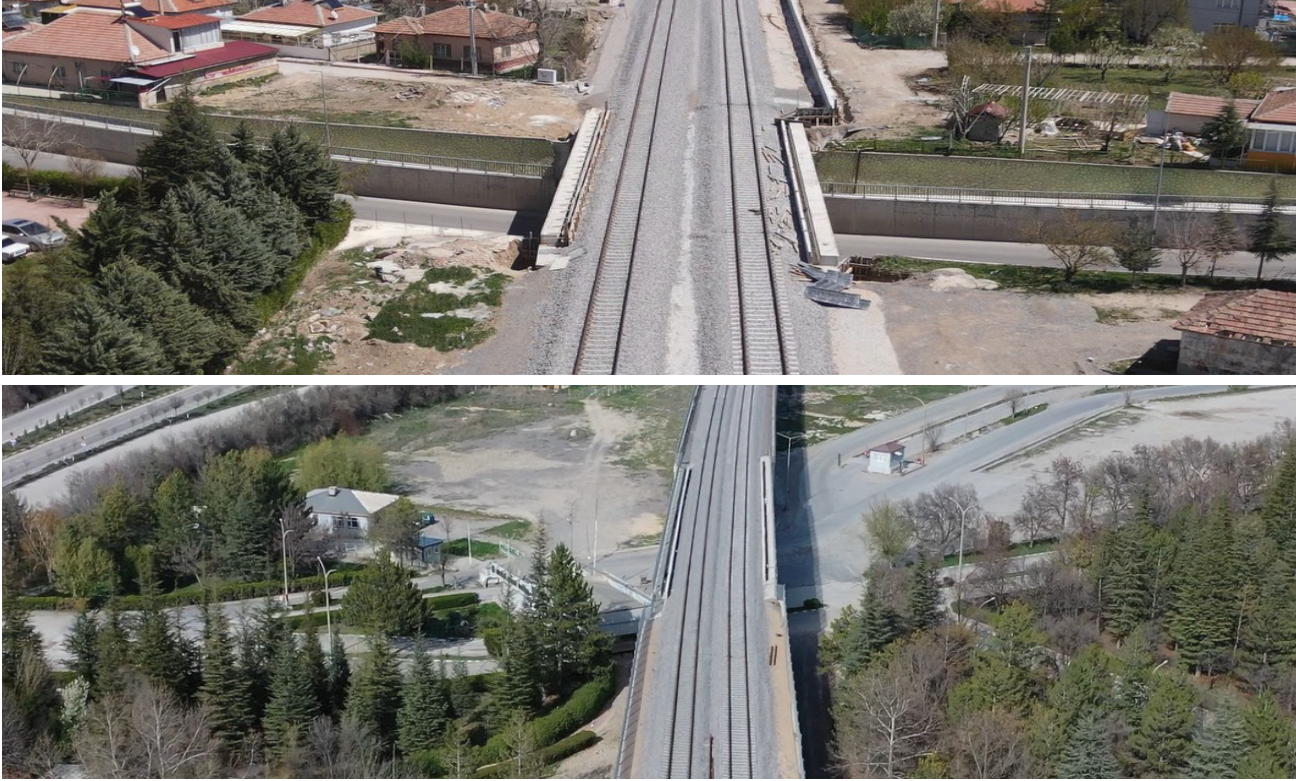
K11(Şeker Fabrikası Giriş) Köprüsü
