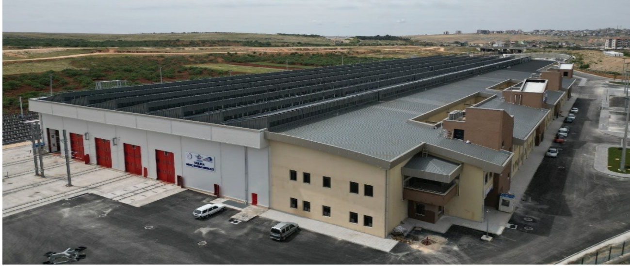
Gaziray Depo Binası
