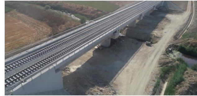
Km:125+680 Demiryolu Köprüsü
