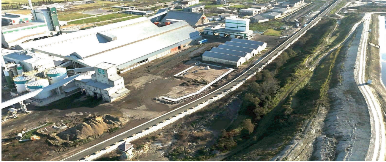
Gelemen-Tekkeköy İltisak Hattı
