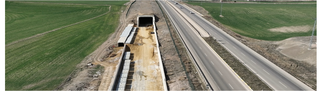
Sincan OSB-Yenikent-Kazan Demiryolu (AÜE) (18 km)
