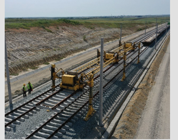
Çerkezköy-Kapıkule HT Saha Çalışmaları
