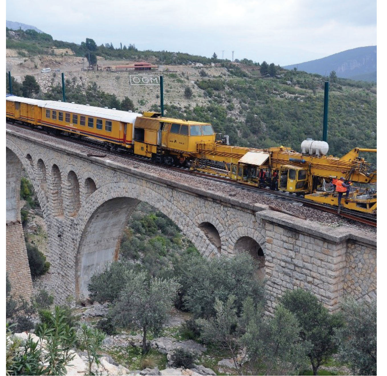
Adana Bölgesi Hacıkırı Yenice Arası Poz Çalışması
