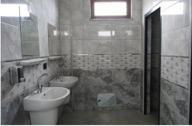
Uzunyayla mahallesi tuvalet ve abdesthane
