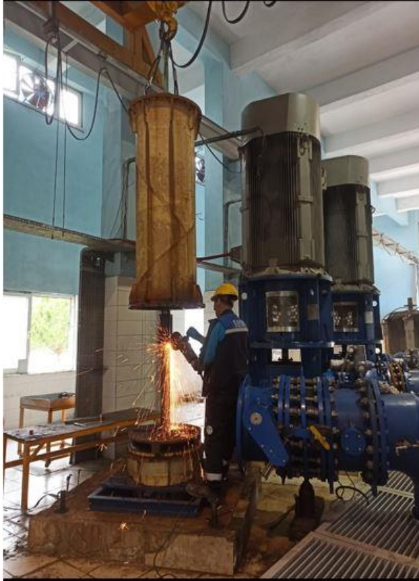
4 Nolu Motorun Akıtma Başlığı Tamiri
