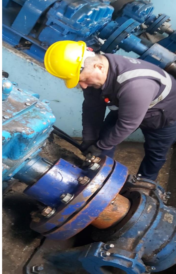
Atıksu Terfi Merkezi Burgu Tip Kaplin Ayarı Yapılması
