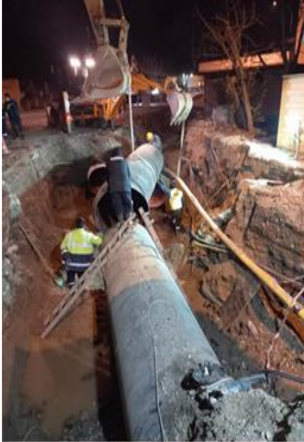
SSK Kavşağı Ø1400 mm. Deplase Çalışması
