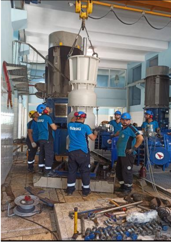
3 Nolu Motorun Vibrasyon Arızası Tamiri.
