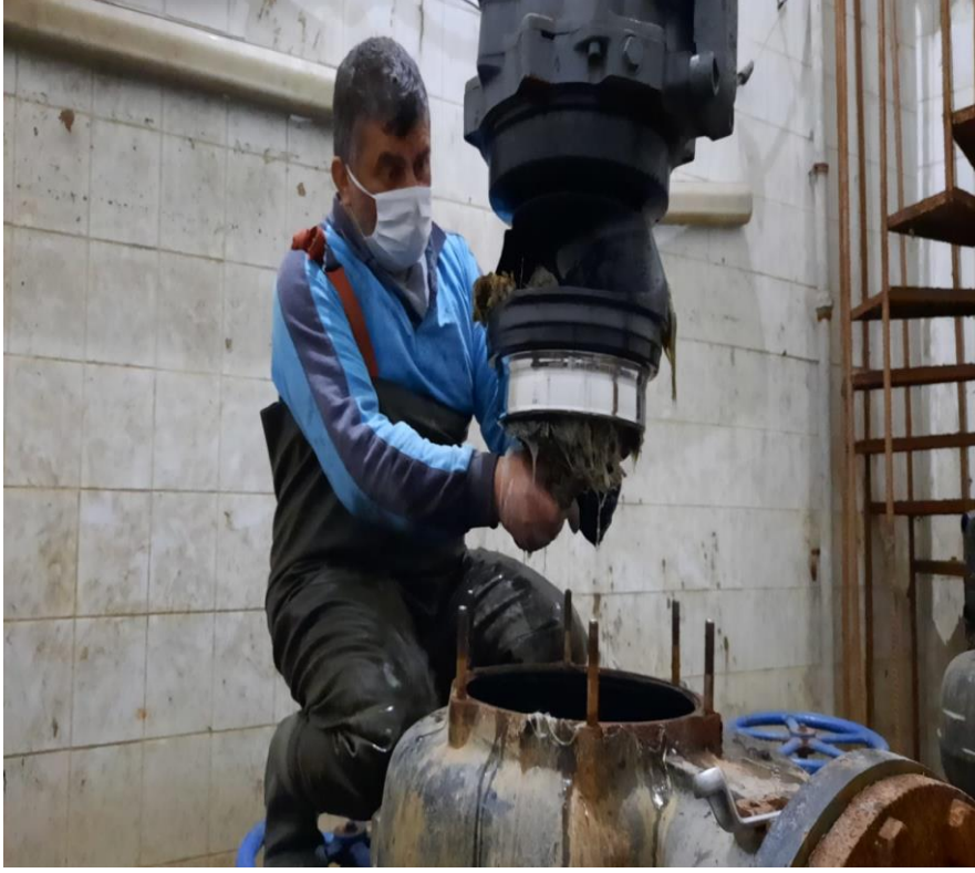
Atıksu Terfi Merkezi Motor Temizliđi
