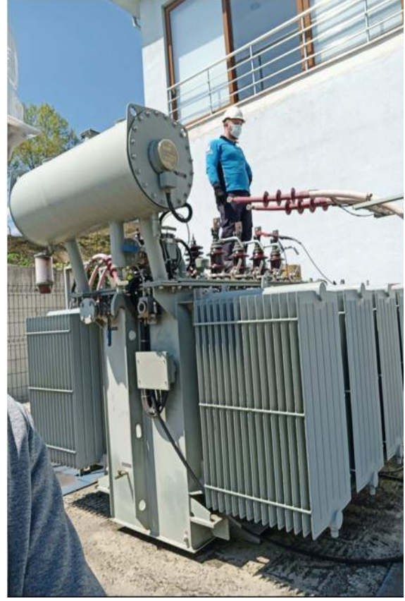
5 ve 10 MVA Trafo Bakımlarının Yapılması
