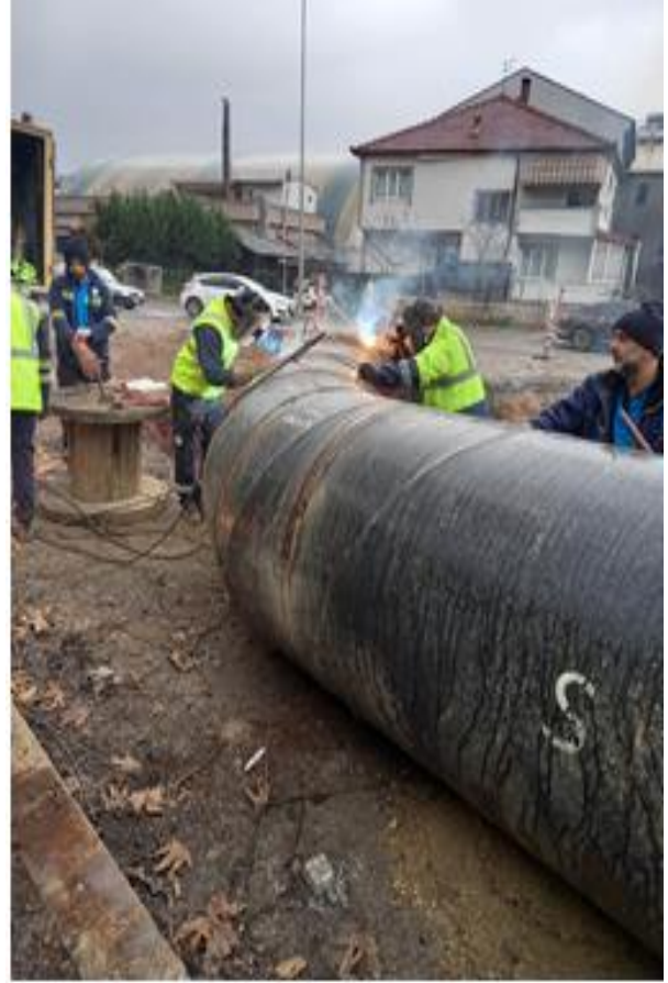
SSK Kavşağı Ø1400 mm. Deplase Çalışması
