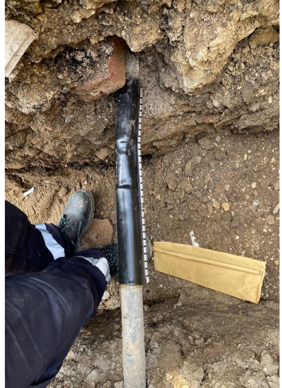
Enerji Nakil Hatları Yeraltı Kablo Patlağı Tamirlerinin Yapılması
