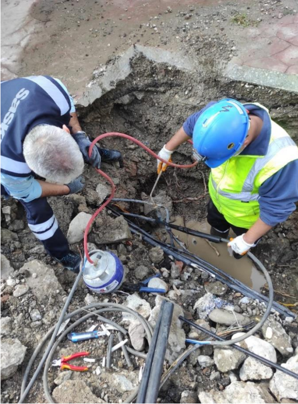
Enerji Nakil Hatları Yeraltı Kablo Patlağı Tamirlerinin Yapılması
