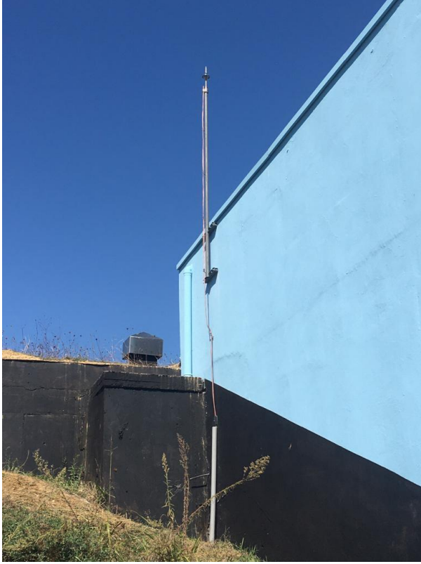
Korucuk 5000 Lik Paratoner Montajının Yapılması
