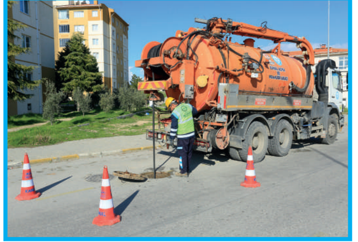
Kayalar Mahallesi Kanalizasyon Hattı Tıkanıklığı Müdahale İşlemi
