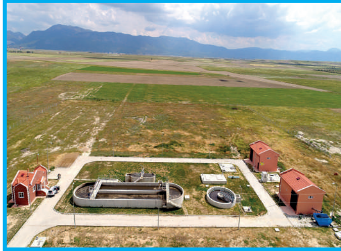
Çardak Atıksu Arıtma Tesisi Genel Görünüm
