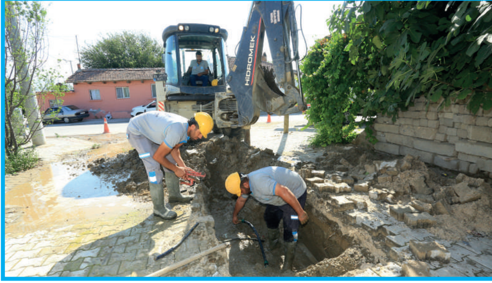
Sarayköy İlçesi, Sığma Mahallesi İçme Suyu Arıza Çalışması
