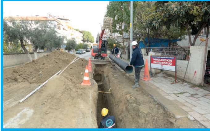
Sarayköy İlçesi, Merkez Mahallesi Yağmursuyu Hattı İmalatı ve Ölçümü
