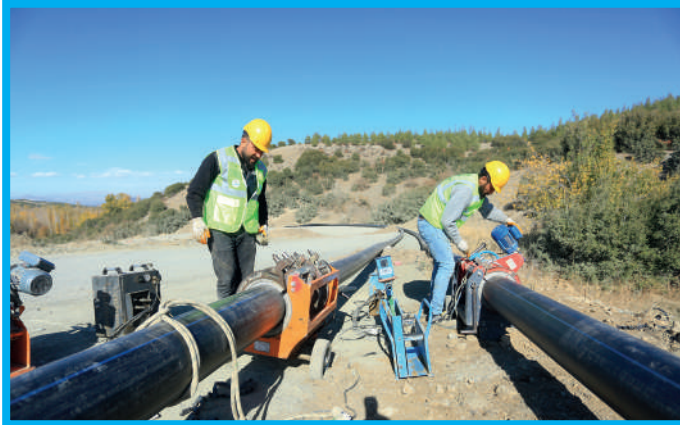
Bozkurt İlçesi, İnceler Mahallesi İçme Suyu İsale Hattı Elektro Füzyon Kaynak İmalatı
