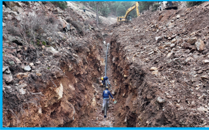
Tavas İlçesi, Bahçeköy Mahallesi İçme Suyu Kaynak Çalışması
