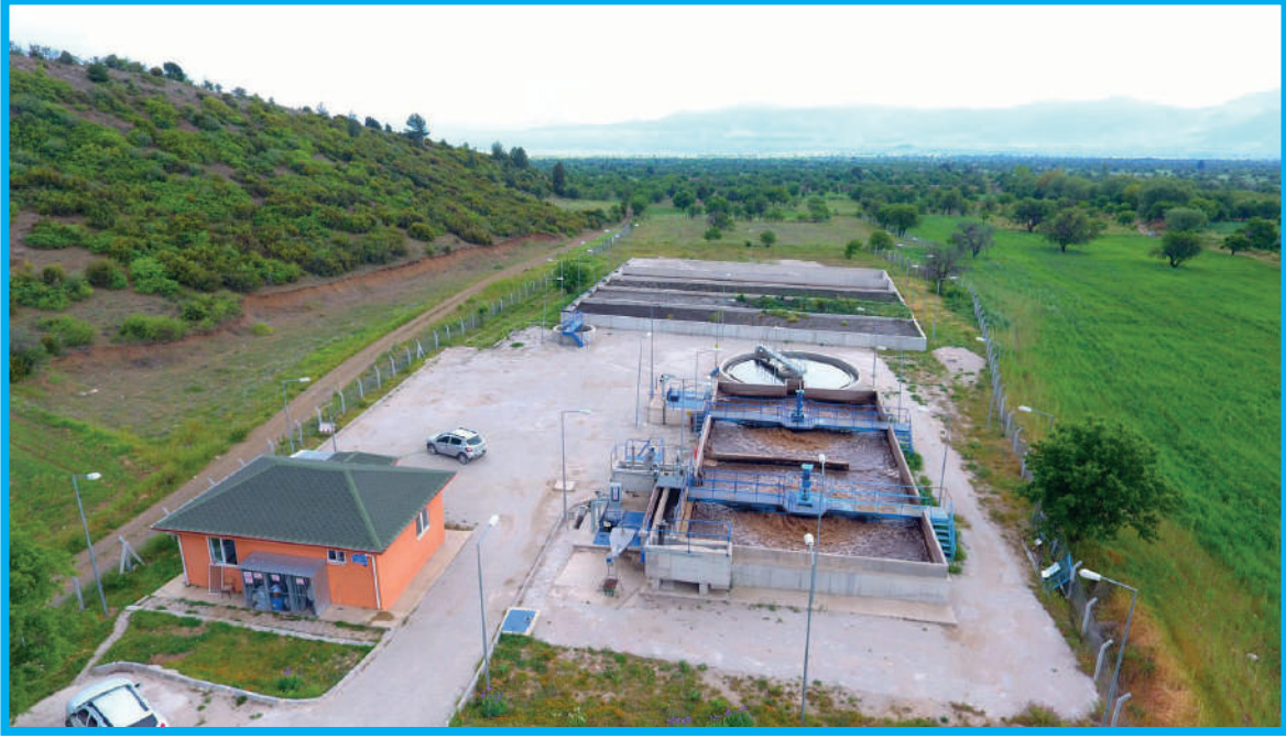
Acipayam Yeşilyuva Atıksu Arıtma Tesisi
