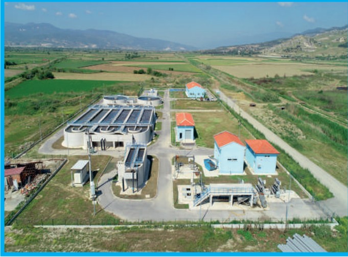
Sarayköy Atıksu Arıtma Tesisi Genel Görünüm
