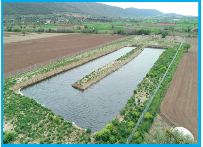
Tavas Baharlar-Hırka Doğal Atıksu Arıtma Tesisleri
