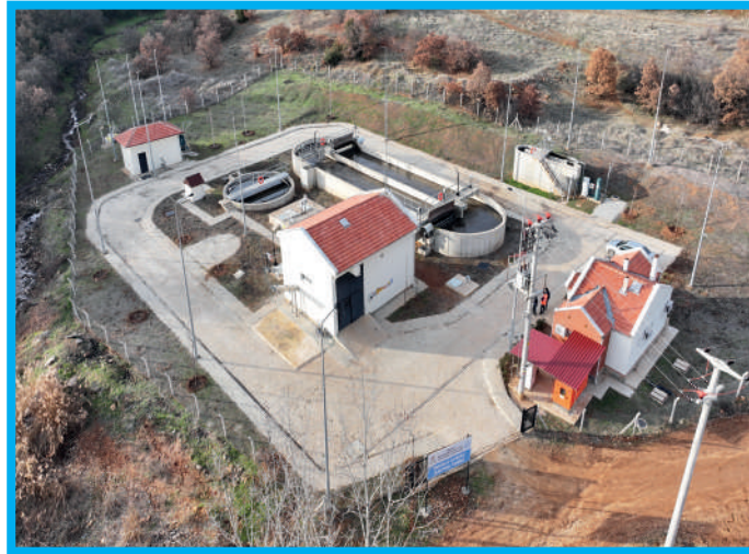
Bekilli Atıksu Arıtma Tesisi Genel Görünüm
