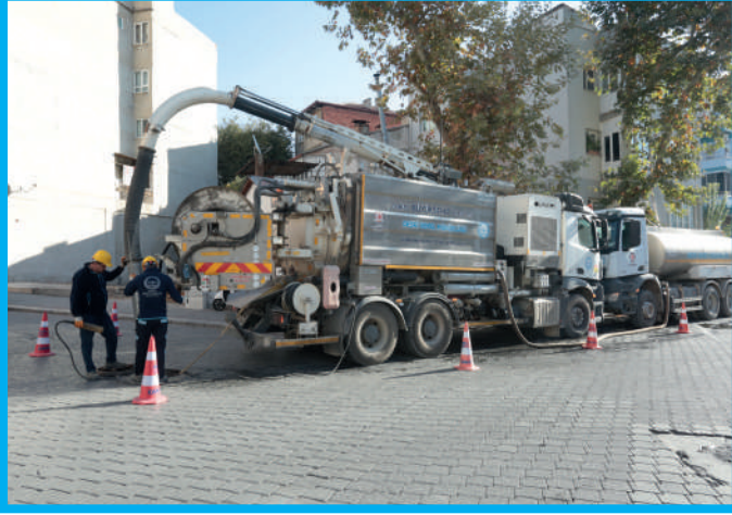
Karaman Mahallesi Kombine Aracı İle Kanalizasyon Hattı Temizliği
