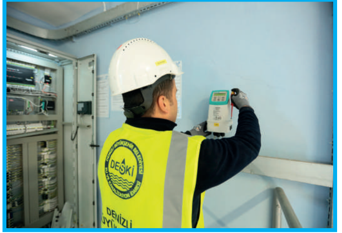
Elektromanyetik Debimetre Tamiri
