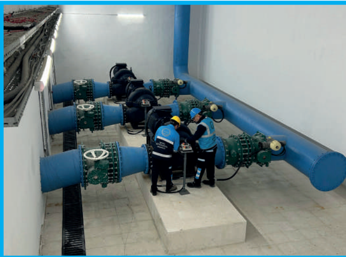
Geri Yıkama Suyu Pompalarının Bakımı
