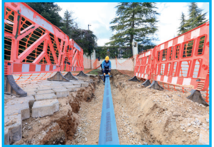
Bağbaşı Mahallesi Abone Şube Hattı İmalatı
