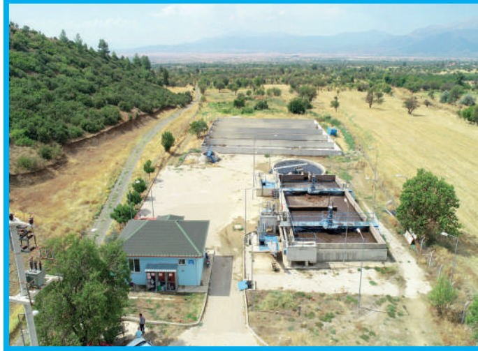
Yeşilyuva Atıksu Arıtma Tesisi Genel Görünüm
