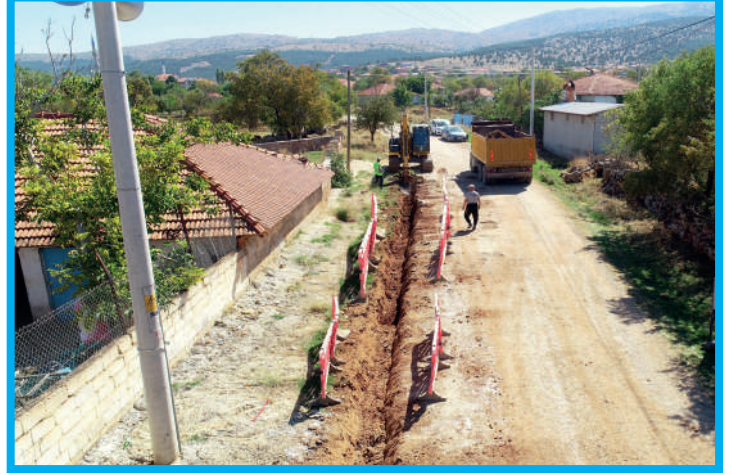
Tavas İlçesi Sariatat Mahallesi Altyapı Çalışmaları
