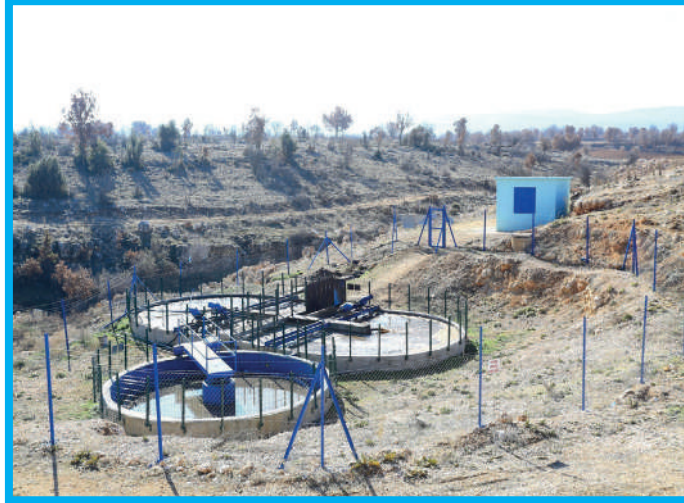
Gözler Atıksu Arıtma Tesisi Genel Görünüm
