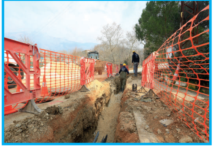
Cankurtaran Mahallesi İçme Suyu Ana Şebeke İmalatı
