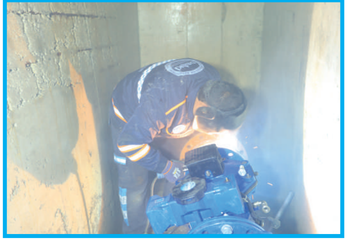
Karaman Mahallesi Basınç Kırıcı Vana Montajı
