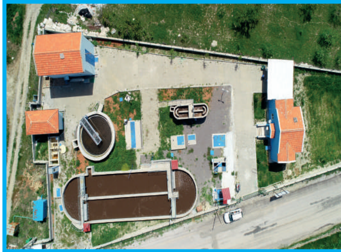
Çameli Atıksu Arıtma Tesisi Genel Görünüm
