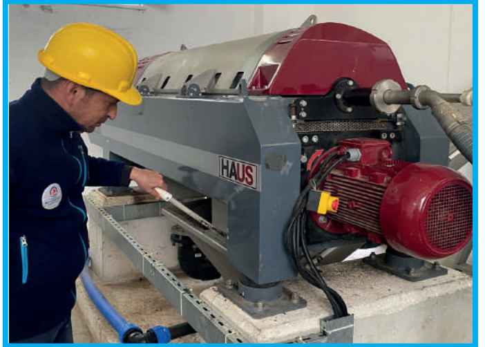
Dekantör Çamur Çıkışı Kuruluk Kontrolü
