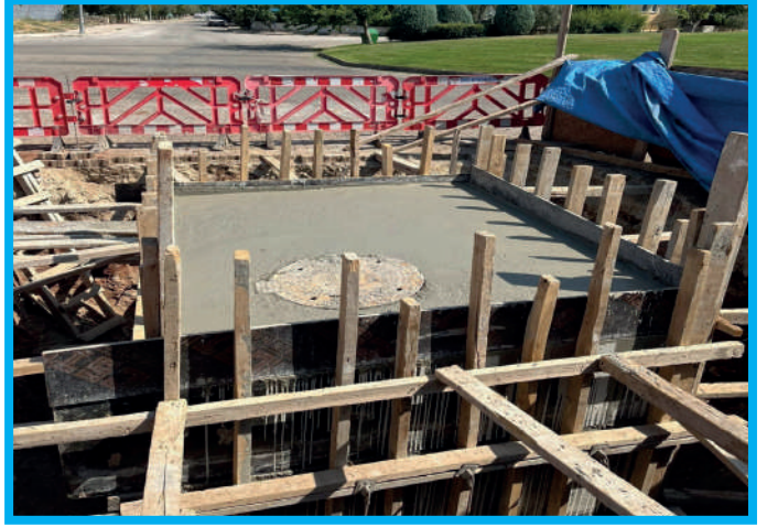
Selçukbey Mahallesi Basınç Kırıcı Vana Odası İmalatı
