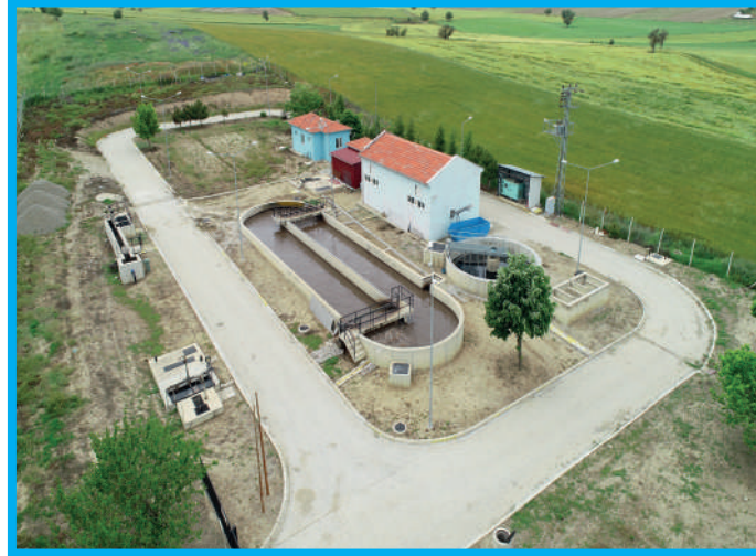
Bozkurt Atıksu Arıtma Tesisi Genel Görünüm
