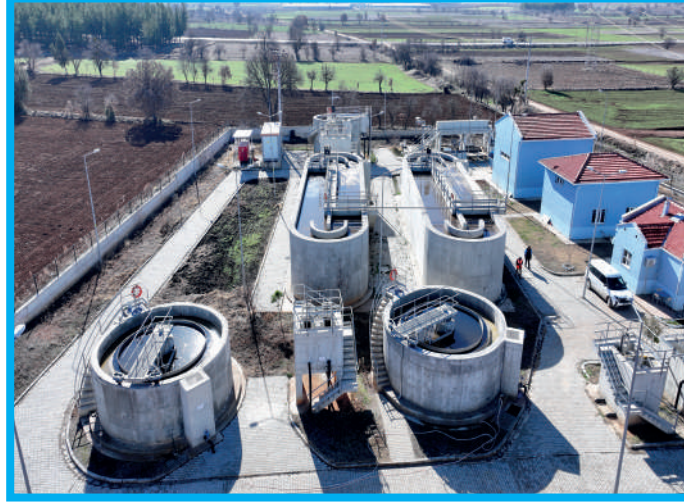
Baklan Atıksu Arıtma Tesisi Genel Görünüm
