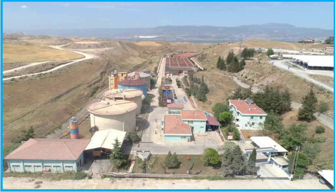
Denizli Eskihsar(Merkez) Atıksu Arıtma Tesisi
