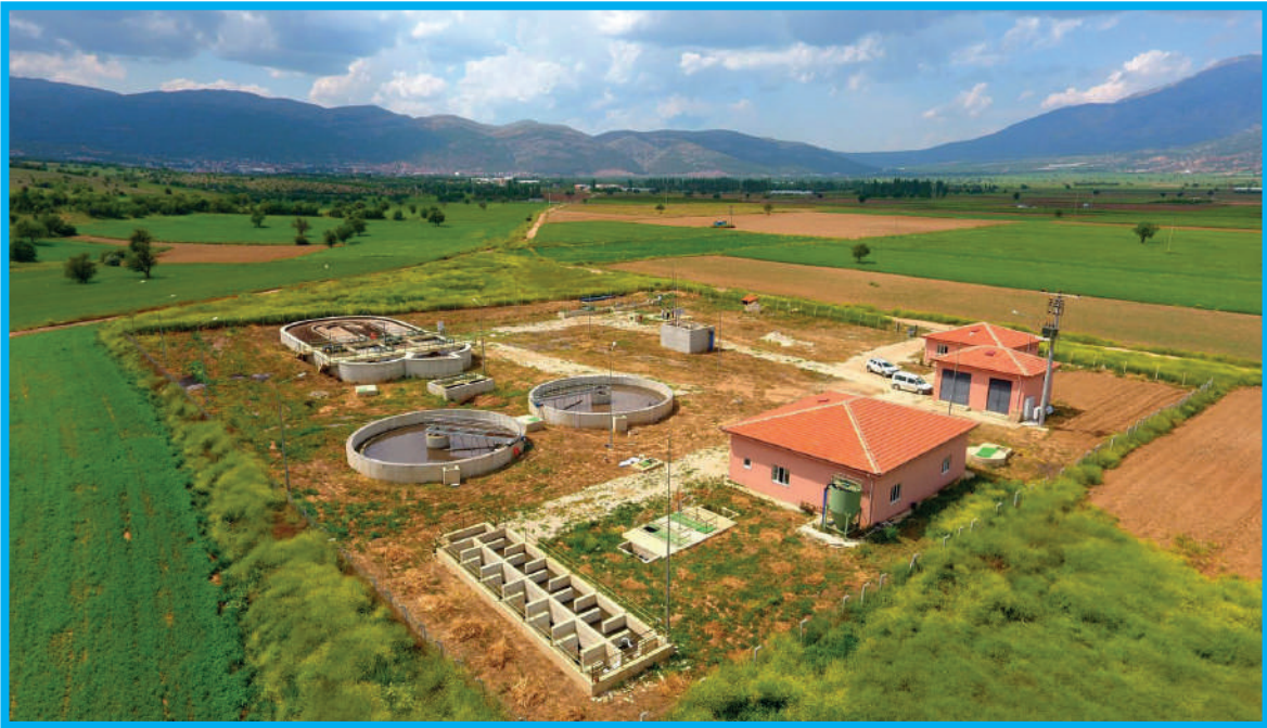
Serinhisar Atıksu Arıtma Tesisi
