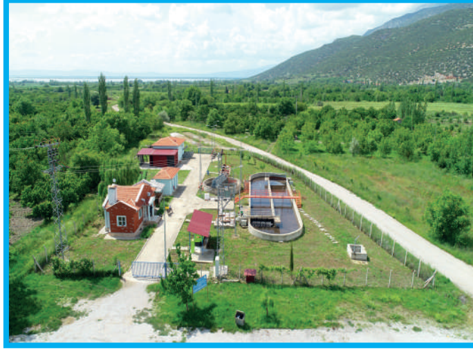
Gümüştü Atıksu Arıtma Tesisi Genel Görünüm
