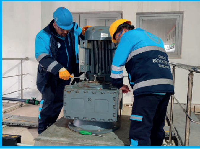
Karıstırıcı Motor Bakımı
