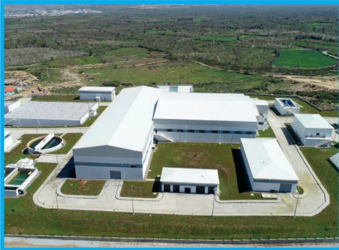
Denizli İçme Suyu Arıtma Tesisi Genel Görünümü
