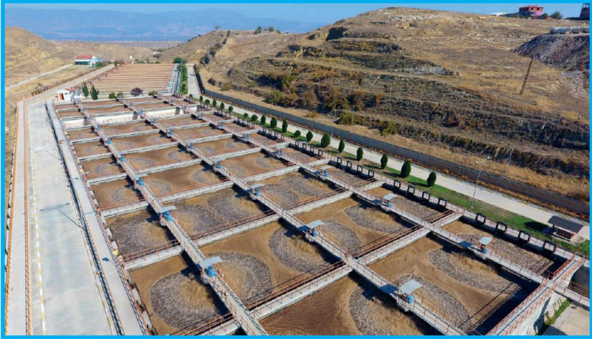
Denizli Eskihsar(Merkez) Atıksu Arıtma Tesisi
