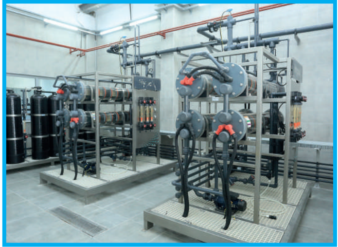
Denizli İçme Suyu Arıtma Tesisi Klor Üretim Binası
