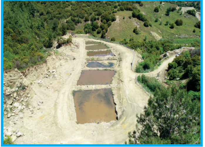
Buldan Doğal Atıksu Arıtma Tesisleri
