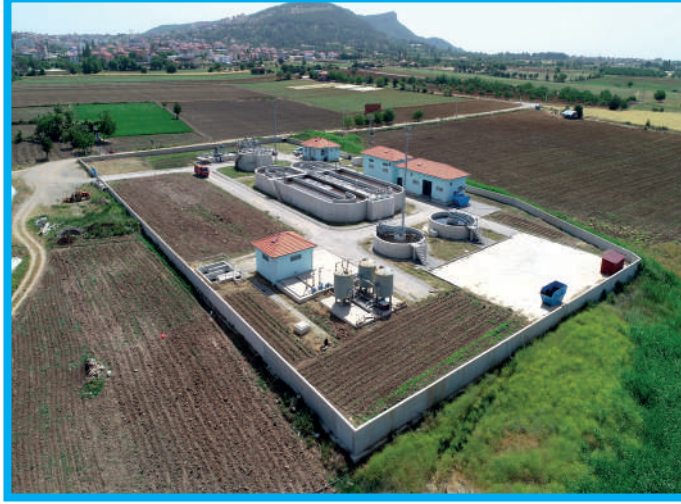
Kale Atıksu Arıtma Tesisi Genel Görünüm
