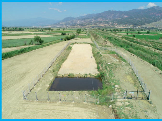
Sarayköy Hasköy Doğal Atıksu Arıtma Tesisleri
