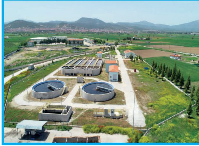
Acıpayam Atıksu Arıtma Tesisi Genel Görünüm
