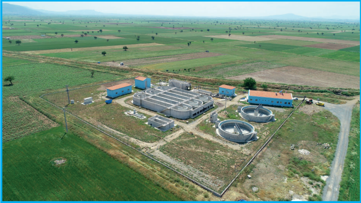
Tavas Atıksu Arıtma Tesisi
