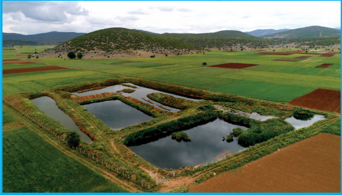
Tavas Nikfer Doğal Atıksu Arıtma Tesisi
