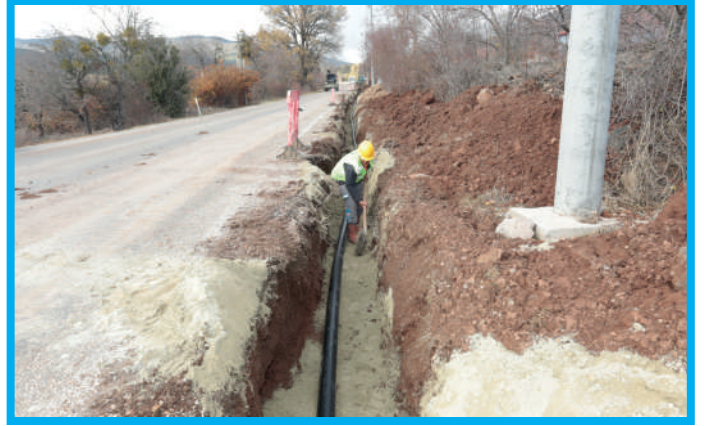
Tavas İlçesi, Yukarıboğaz Mahallesi İçme Suyu İsale Hattı İmalatı
