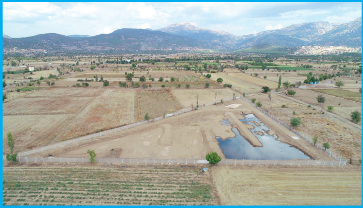
Acıpayam Yazır Doğal Arıtma Tesisi
