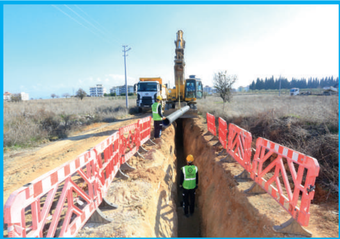
Kayalar Mahallesi Kanalizasyon ve Yağmursuyu Hattı İmalatı
