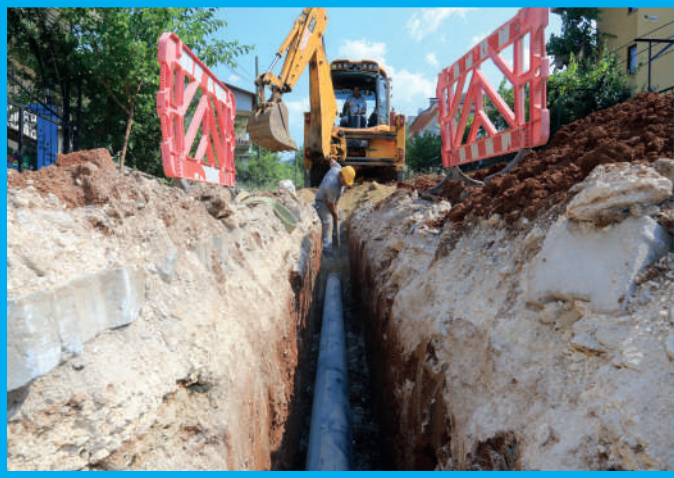
Başkarcı Mahallesi İçme Suyu Ana Şebeke İmalatı
