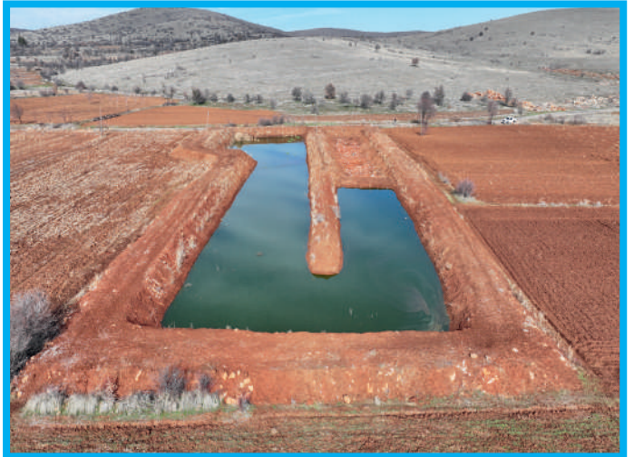
Bekilli Poyrazlı Doğal Atıksu Arıtma Tesisleri
