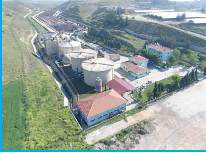
Denizli Merkez Atıksu Arıtma Tesisi Genel Görünüm
