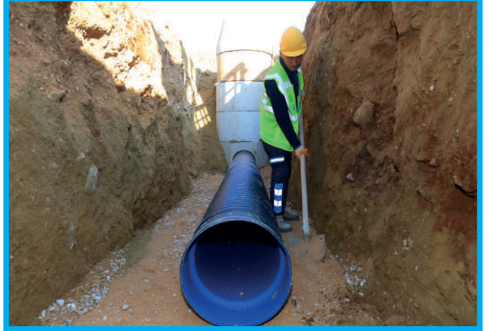
Karahasanlı Mahallesi Kanalizasyon ve Yağmursuyu Hattı İmalatı
