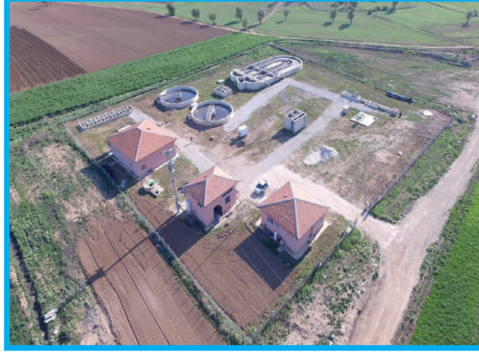
Serinhisar Atıksu Arıtma Tesisi Genel Görünüm
