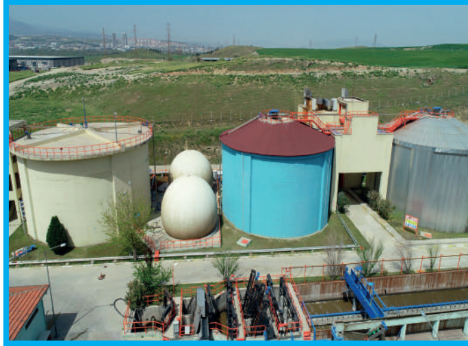
Denizli Merkez Atıksu Arıtma Tesisi Biyogaz Ünitesi
