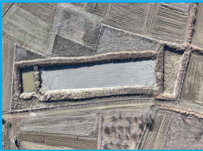
Acıpayam Karahüyükafşarı Doğal Atıksu Arıtma Tesisleri
