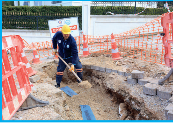
Bağbaşı Mahallesi Abone Şube Hattı İmalatı
