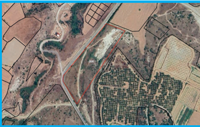
Merkezefendi-Karahasanlı Hizmet Binası ve Malzeme Deposu Alanı
