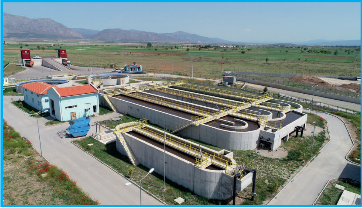
Acipayam Atıksu Arıtma Tesisi
