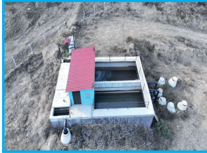
Kelleci Atıksu Arıtma Tesisi Genel Görünüm
