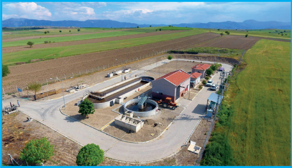
Bozkurt Atıksu Arıtma Tesisi
