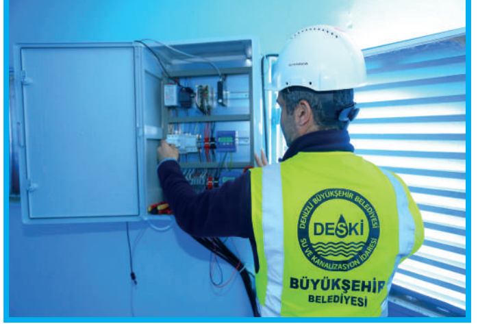
SCADA Panosu Montajı
