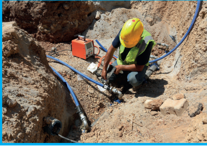
Çal İlçesi Hançalar Mahallesi Altyapı Çalışmaları
