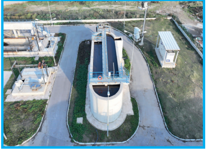
Sarayköy Atıksu Arıtma Tesisi Bio-P Tankı
