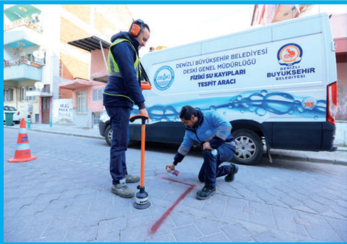
Mehmetçik ve Karaman Mahallesi Fiziki Kayıp-Kaçak Tespit Çalışmaları
