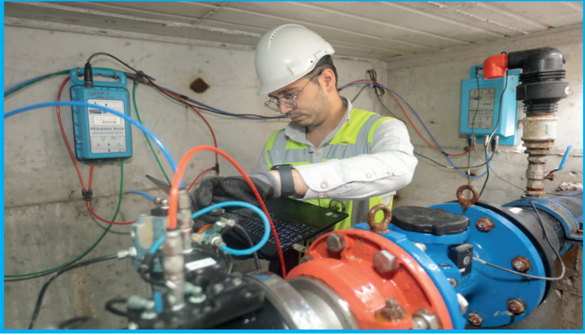
DMA Odası Basınç Ayarı Yapılması
