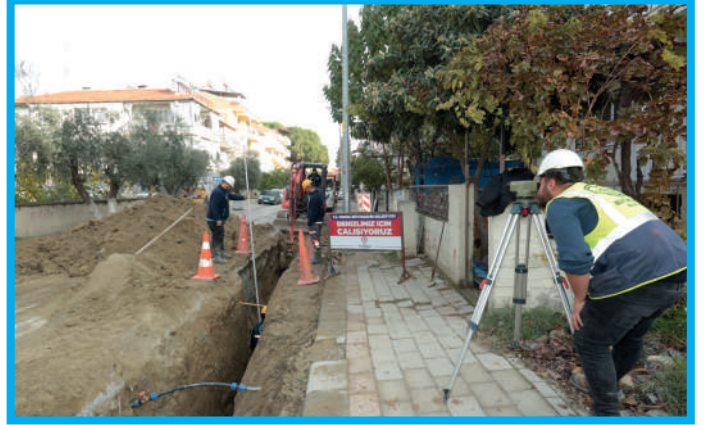
Sarayköy İlçesi, Merkez Mahallesi Yağmursuyu Hattı İmalatı ve Ölçümü
