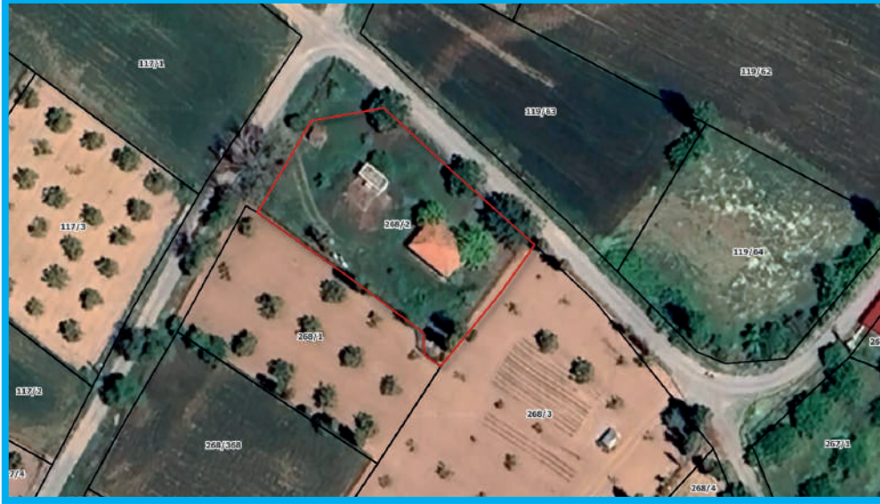
Tavas-Garipköy İçme Suyu Tesisi Alanı
