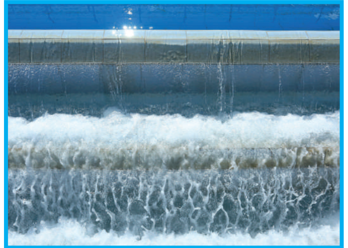
Denizli İçme Suyu Arıtma Tesisi Giriş Havalandırma Yapısı
