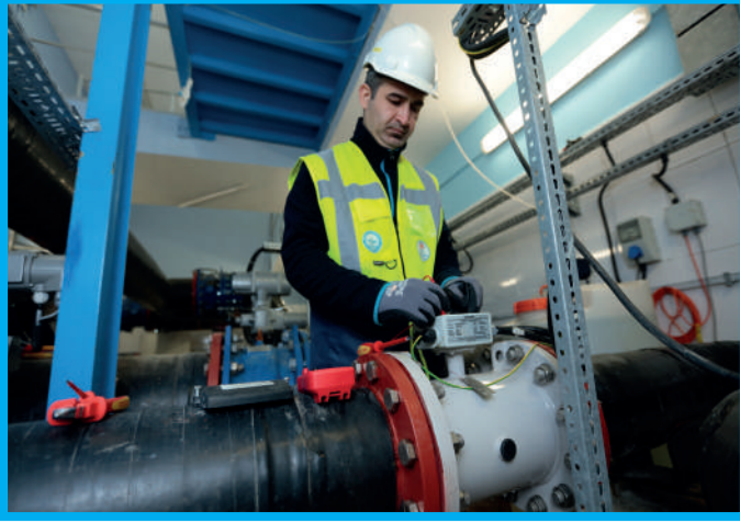
Elektromanyetik Debimetre Tamiri
