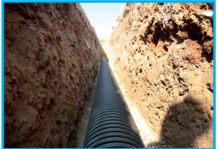
Kayalar Mahallesi Kanalizasyon ve Yağmursuyu Hattı İmalatı
