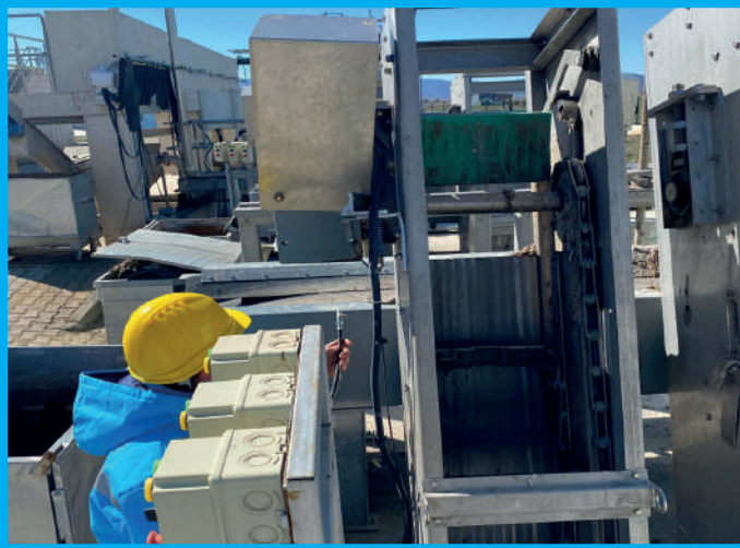
Kaba Izgara Zincir Sistemi Sensör Kontrolü
