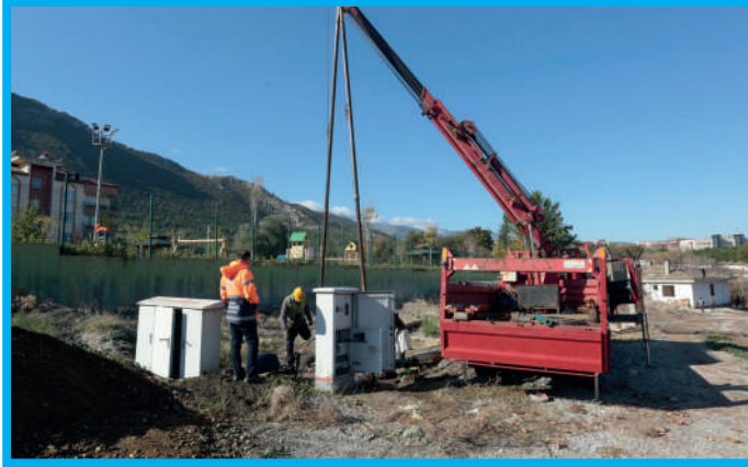
Pamukkale İlçesi Kozlupınar Mahallesi Pompa Değişimi
