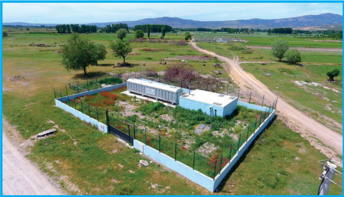
Çivril Beydilli Paket Atıksu Arıtma Tesisi
