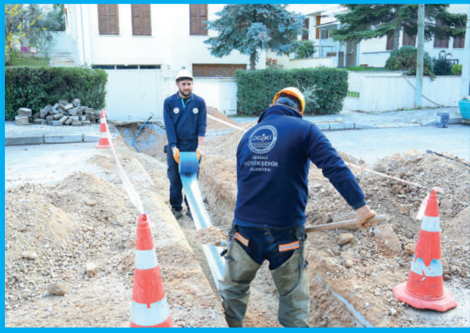
Kervansaray Mahallesi İçme Suyu Abone Şube Hattı İmalatı
