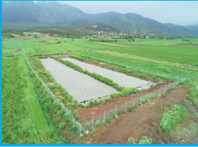
Çardak Beylerli Doğal Atıksu Arıtma Tesisleri
