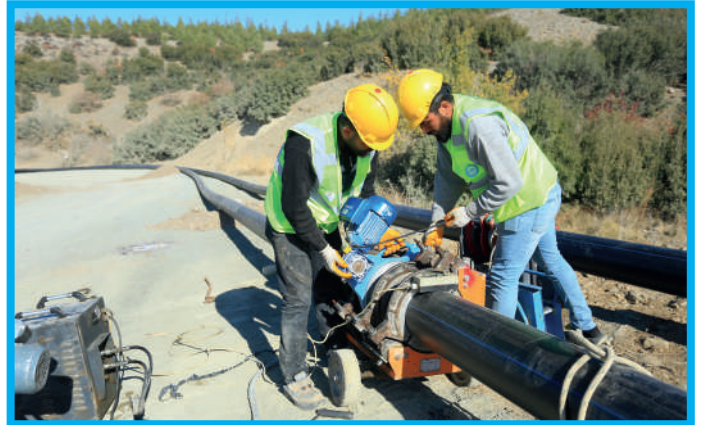
Bozkurt İlçesi, İnceler Mahallesi İçme Suyu İsale Hattı Elektro Füzyon Kaynak İmalatı
