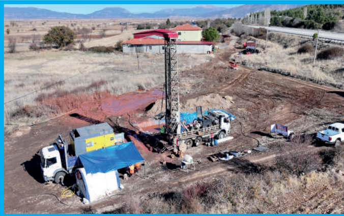
Tavas İlçesi, Baharlar Mahallesi İçme Suyu Sondaj Çalışması
