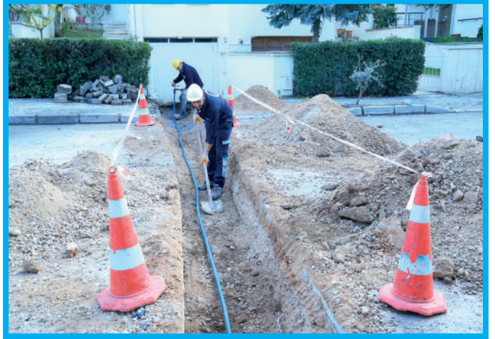
Kervansaray Mahallesi İçme Suyu Abone Şube Hattı İmalatı
