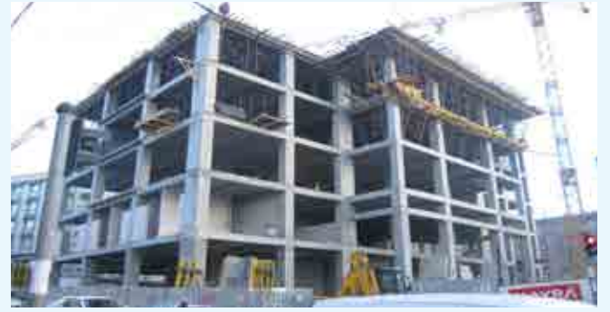
Hükümet Konağı İnşaat Çalışmaları
