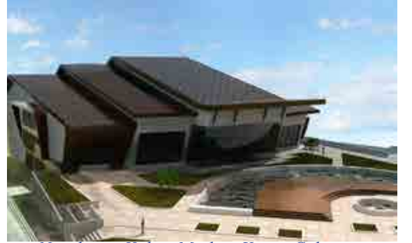
Nenehatun Kültür Merkezi Yapım Çalışması
