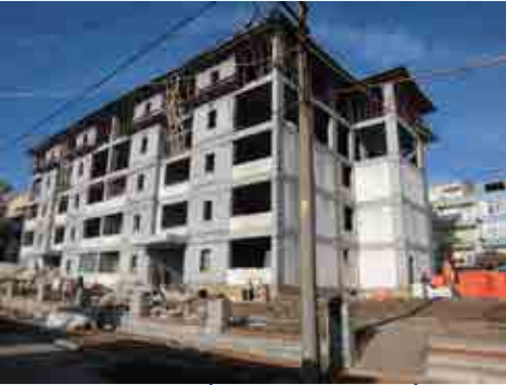
Hasip Dinçsoy İlköğretim Okulu İnşaatı Çalışması
