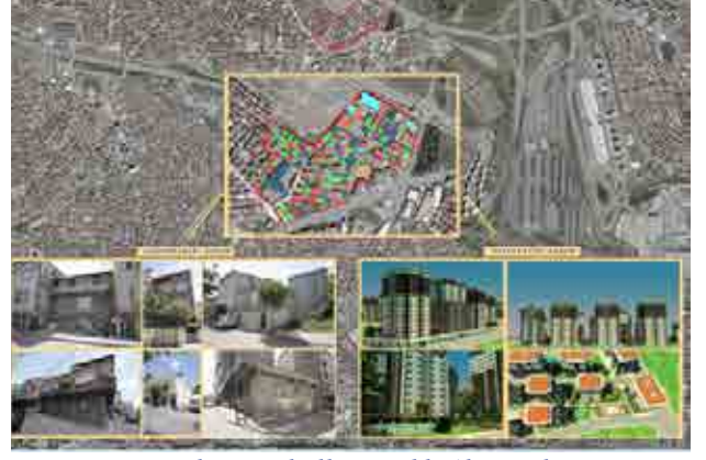
Havaalanı Mahallesi Riskli Alan Bölgesi
