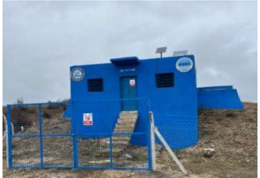
Mahalle Su Deposu
