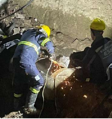
Gömece Lojmanları İçme Suyu Hattı
