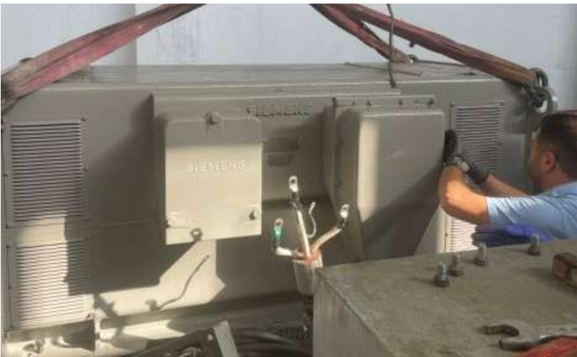
Temizsu Pompa İstasyonu
