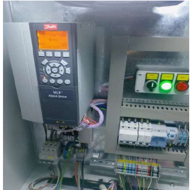
Frekans Konvertörü Montaj İşı
