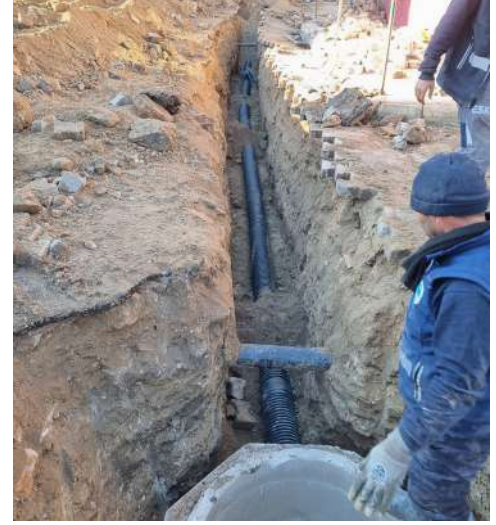
Kanalizasyon Hattı Yapım İşİ
