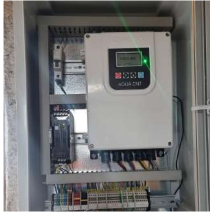
Erken Uyarı ve Otomasyon (SCADA) Sistemi Montajı
