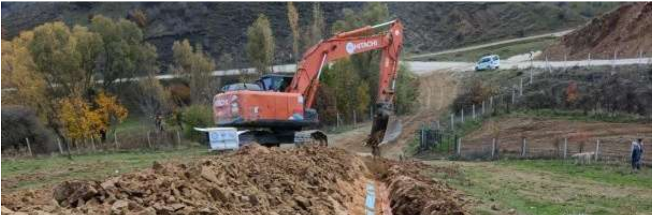
Şebeke Hattı Yapım Çalışması
