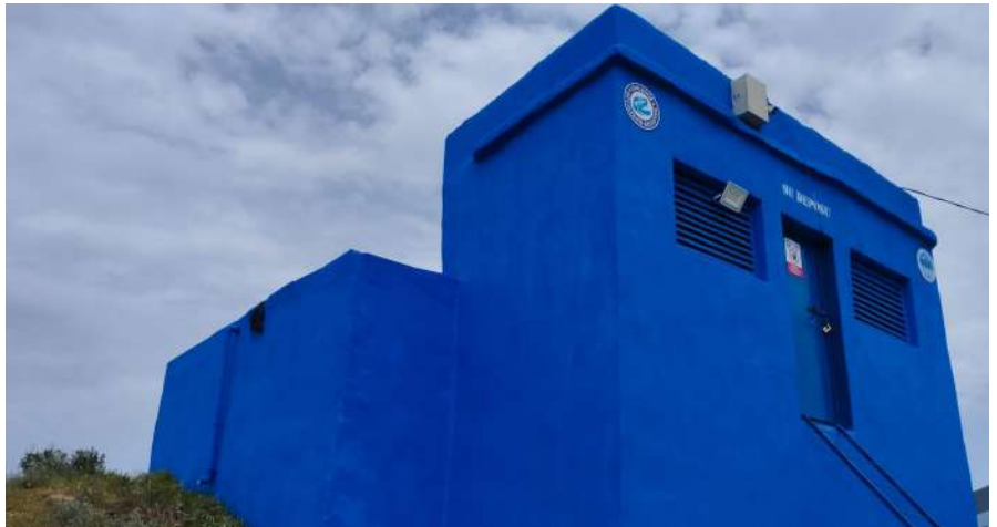
Mahmudiye Su Deposu Bakım ve Onarım Sonrası
