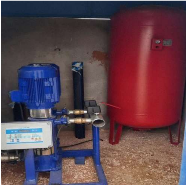
Hidrofor Sistemi Montajı
