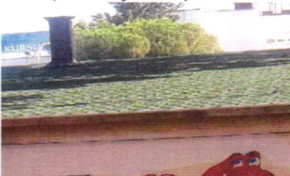
*Kütüphane Çatı Yapımı
