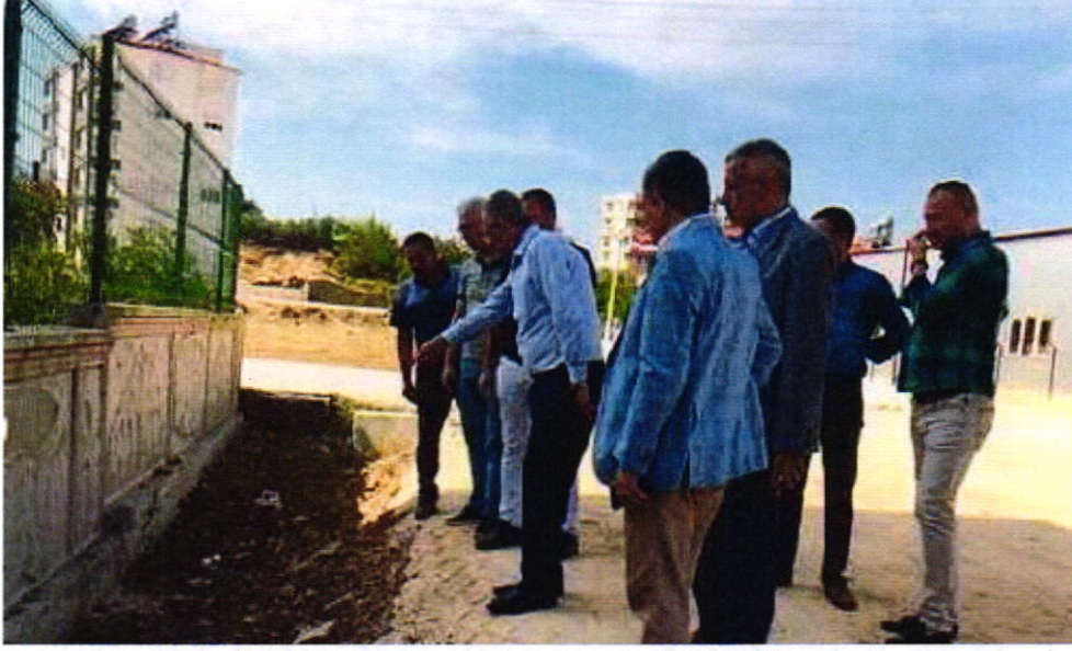
19/10/2019 Merkez Mahallesi Kaymakamlık binası etrafında düzenleme ve yol çalışmalarımızı, Akcaalan mahallesi stad yolunda asfalt ve yağmur suyu çalışmalarımızı ve ilköğretim okulu etrafında sıcak asfalt çalışmalarımızı yerinde inceledik.
