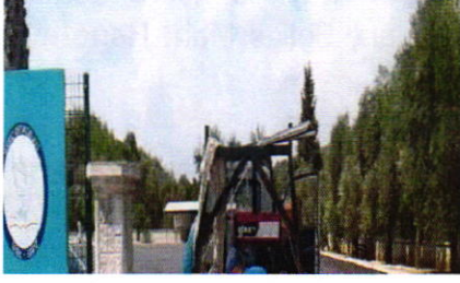
*Okullara Kapı Yapımı
