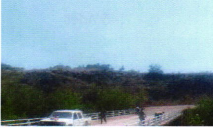
*Köylere Köprü Korkuluğu Yapımı
