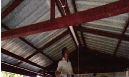
*Okul Kantini Elektrik Montajı
