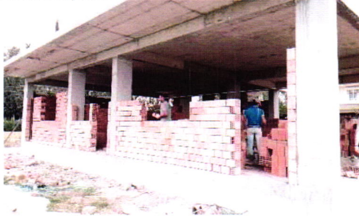
Yukarıkocayatak Futbol Sahası Soyunma Odaları Yapımı
