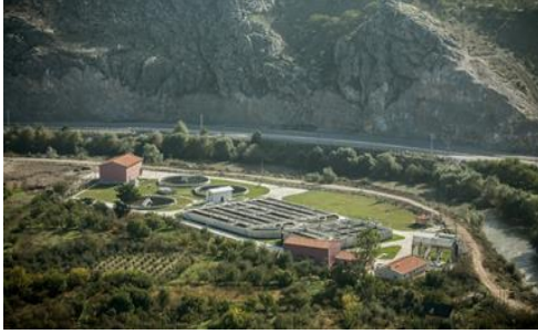
Şekil 9. Amasya Su ve Atıksu Projesi- Atıksu Arıtma Tesisi
