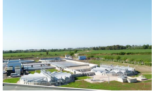
Şekil 10. Ceyhan Su ve Atıksu Projesi- Atıksu Arıtma Tesisi
