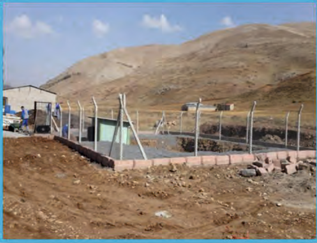
DEVELİ ŞİHLİ ARITMA TESİSİ TEL ÇİT ÇALIŞMASI
