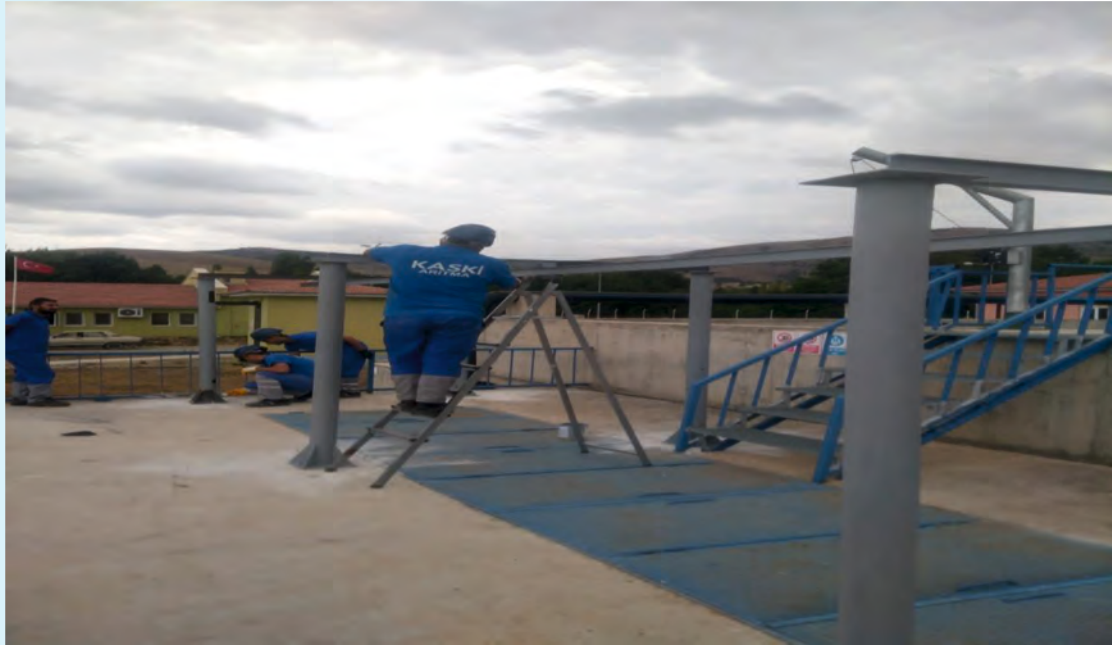
Vinç İskelesi Yapımı
