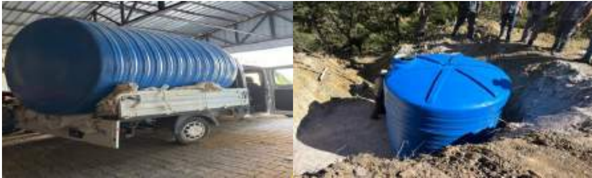
Kaplan Mahallesi Su Deposu Monte Çalışmalarından Görüntüler
