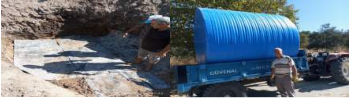
Boncuklu Mahallesi Su Deposu Yeri Zemin Hazırlığı
