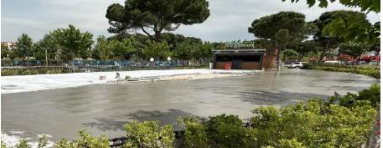
MİLLET BAHÇESİ VARGEL KAFE 2 YAPIM ÇALIŞMASI
