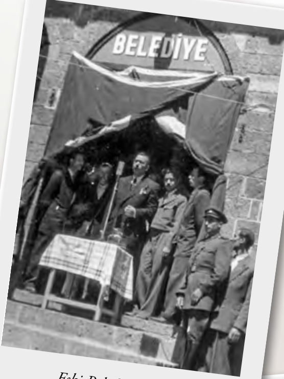
Eski Belediye Binası
