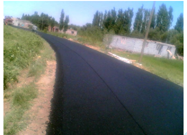
Sıcak Asfalt Yapılan köy Yolları
