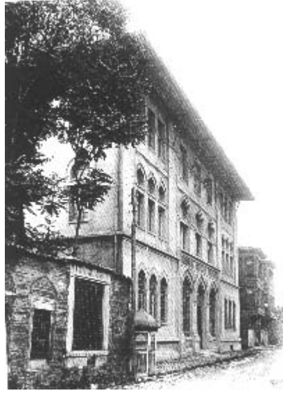
Medresetü'l- Kuzat Binası'nda İstanbul Üniversitesi Merkez Kütüphanesi
