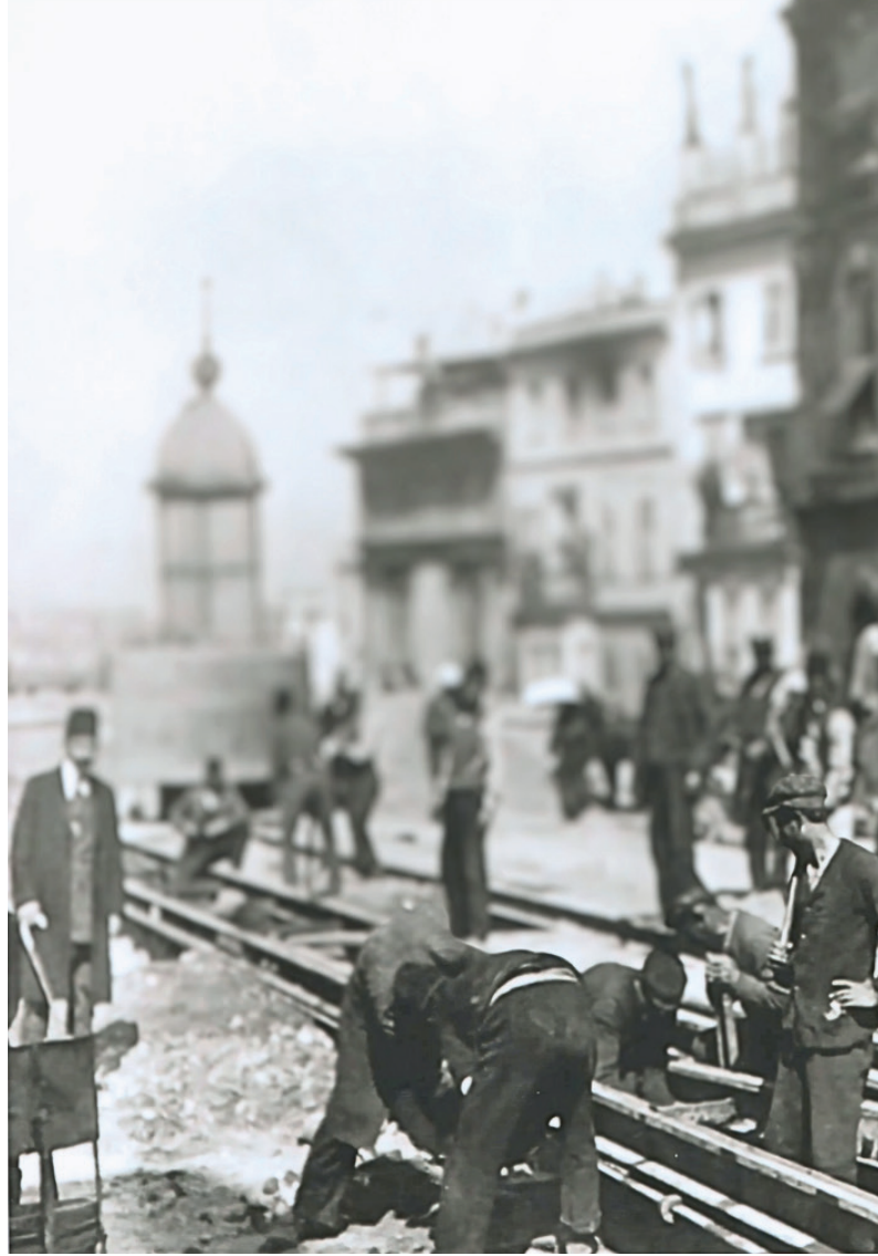
1913 Tünel meydanına elektrikli tramvay için ray döşeniyor.
