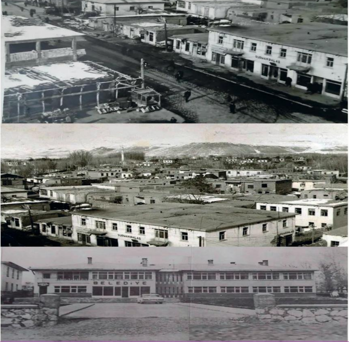
Eski Erciș Resimleri ve 2011 Erciș Depreminde Yıkılan Erciș Belediyesi Binası
