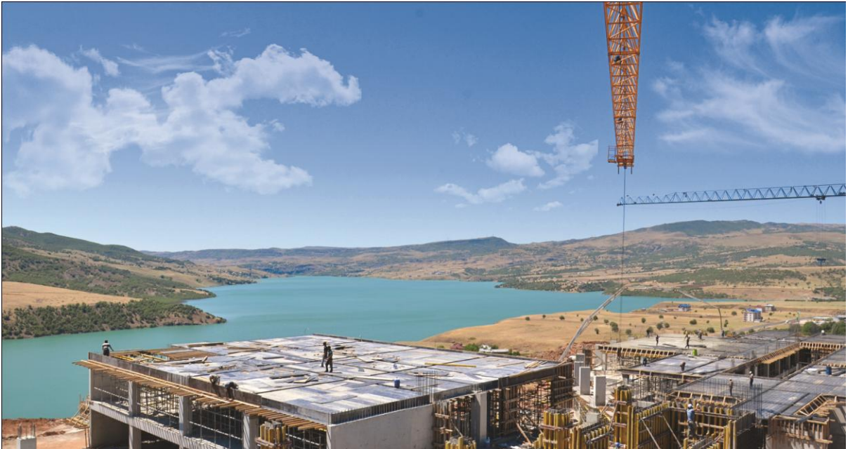
Kampüs Alanı İnşaatından Görüntüler
