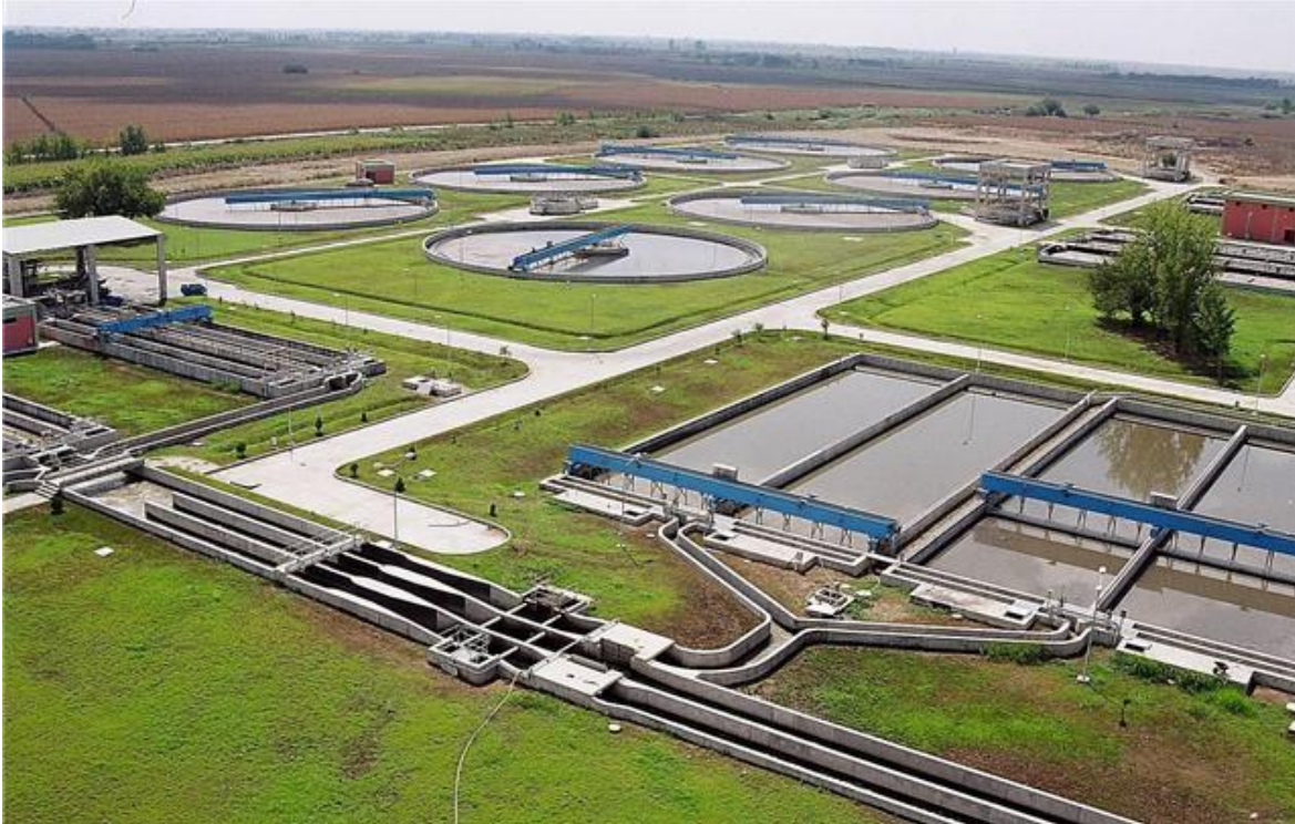
Seyhan ilçesinde bulunan Adana Batı Atıksu Arıtma Tesisinden genel bir görünüm.
