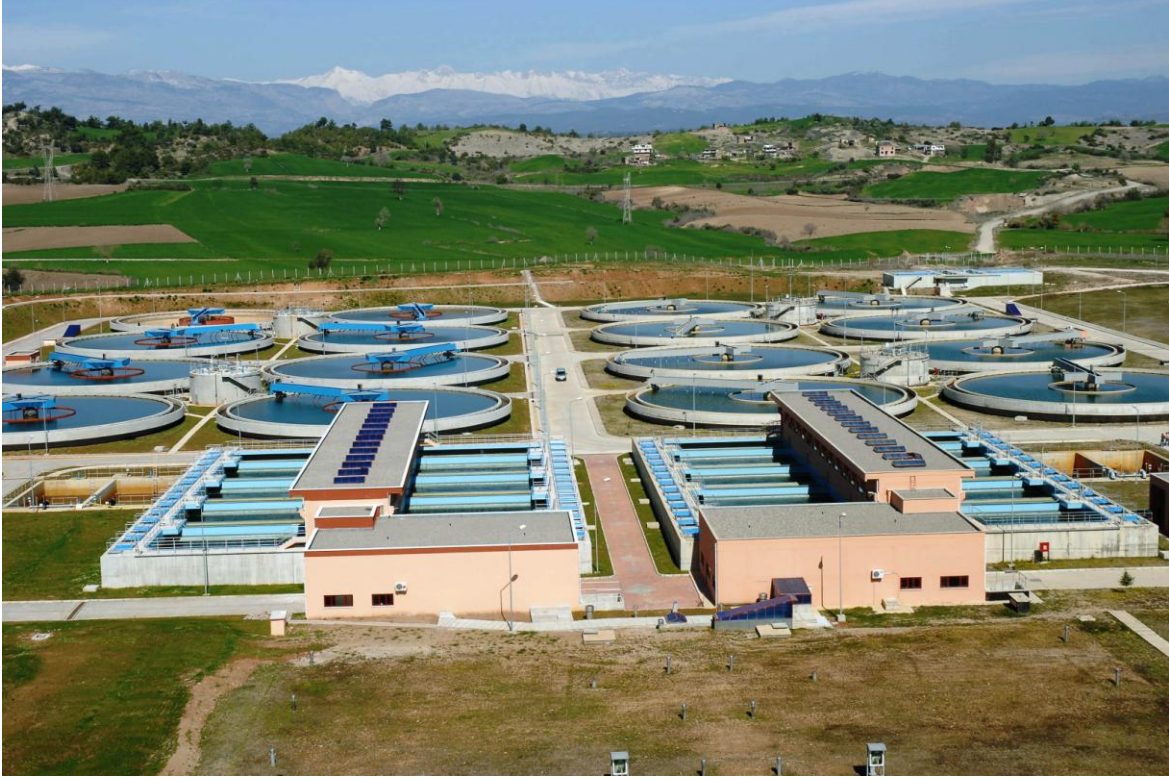
Çatalan İçmesu Arıtma Tesislerinden genel bir görünüm
