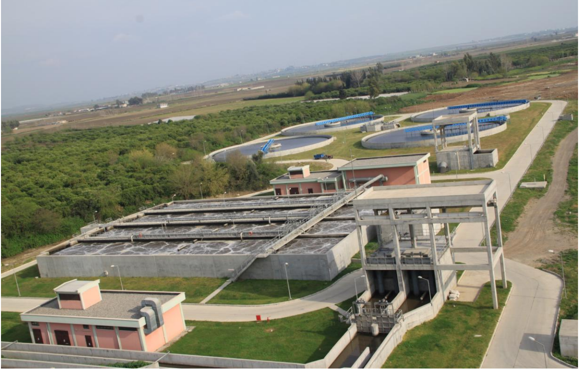
Yüreğir ilçesinde bulunan Doğu Adana Atıksu Arıtma Tesisinden genel bir görünüm
