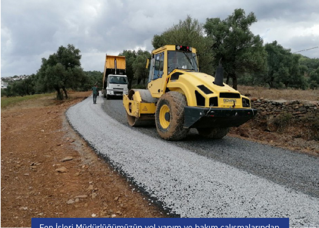
Fen İşleri Müdürlüğümüzün yol yapım ve bakım çalışmalarından.
