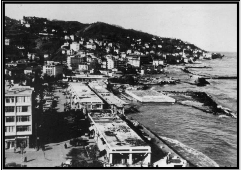
Foto 50. Belediye bloklarının yapımı
